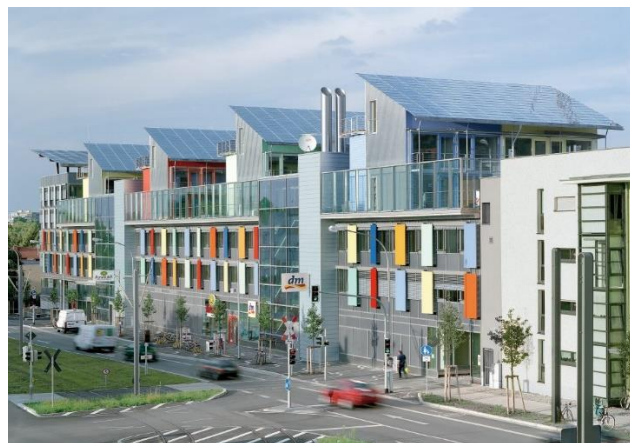
Figura 2 Nave Solare di Friburgo
