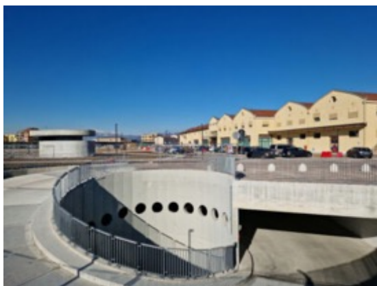
Figura 67 Ingresso del parcheggio sotterraneo a due livelli situato di fronte il Children museum e il Magazzino 1 dell'archivio di Stato e dell'Ordine degli ingegneri.
