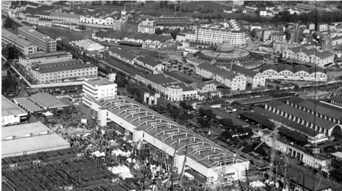
Figura 47 Veduta aerea dei Magazzini intorno alla fine degli anni 80. Foto Alberto Vignolo Architetto.
