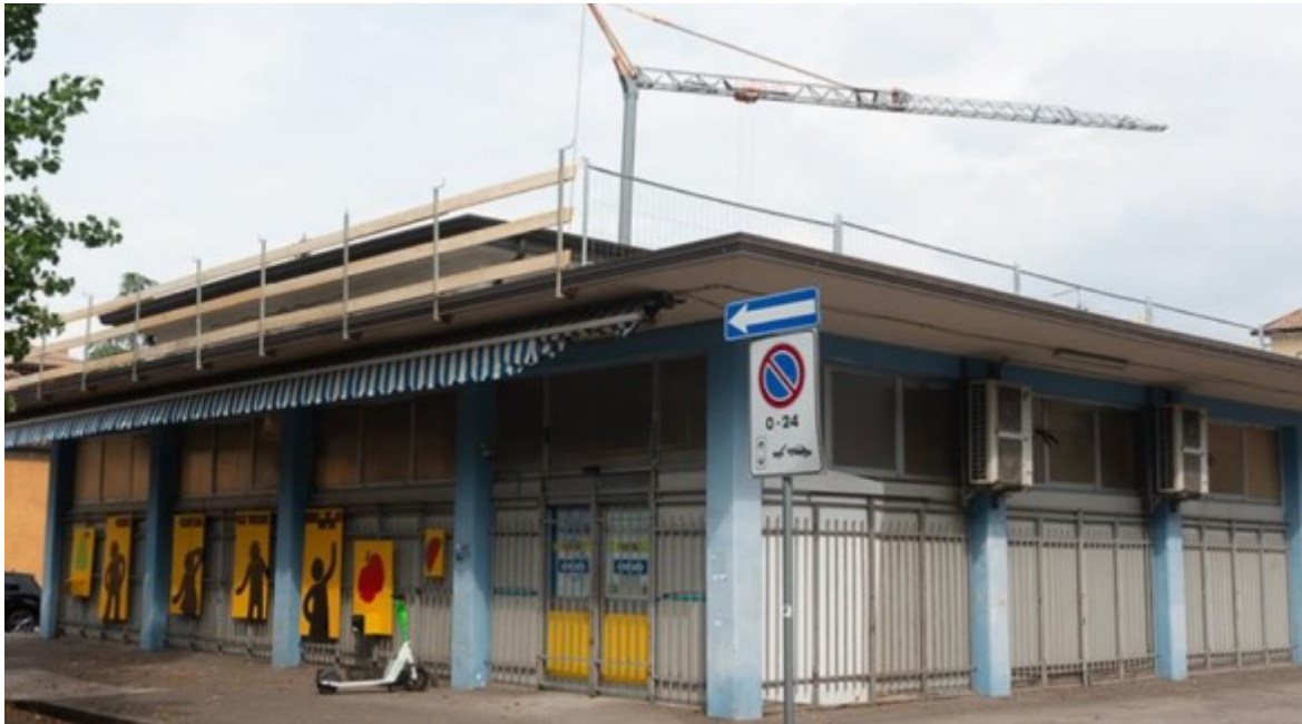
Figura 20 Baleno: passato, presente e futuro di un progetto di rigenerazione di comunità: sede della Casa di Quartiere o Community Center rigenerato nel quartiere degli Orti di Spagna. La partnership tra Energie Sociale e il Comitato cittadino del quartiere hanno generato questo spazio di co-progettazione innovativa. Grazie a questo progetto si intende contribuire a rafforzare il tessuto socio-culturale del quartiere promuovendo la vivibilità urbana e la valorizzazione del patrimonio di relazioni, conoscenze e competenze comunitarie. Foto: Energie Sociali
