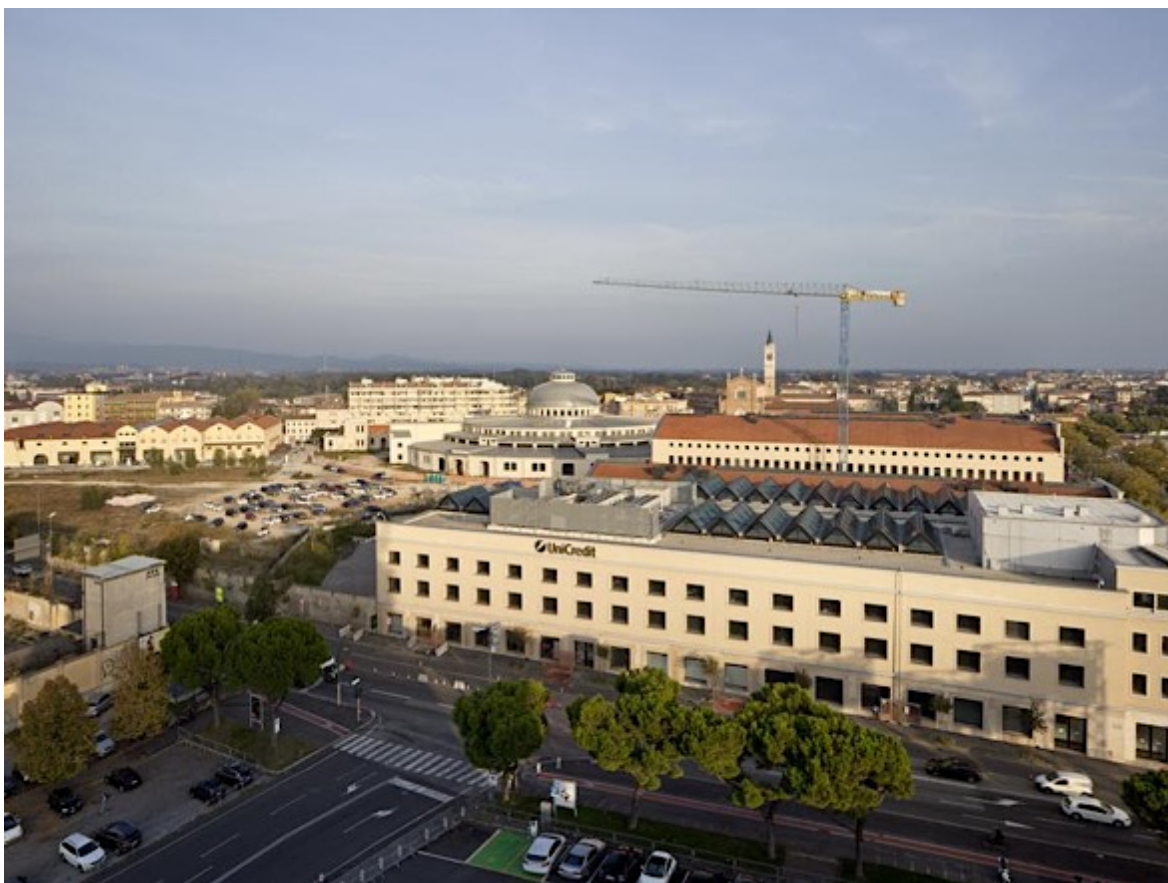
Figura 61 Veduta dal Centro Uffici di Veronafiere del Business District dei Magazzini, con le sedi di Unicredit e della GSK Italia. In lontananza si può notare la Stazione Frigorifera Specializzata in fase di restauro e i Fabbricati dell'Archivio di stato; il Parco urbano ancora doveva essere realizzato,
