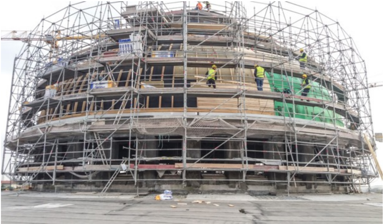
Figura 70 Lavori di ristrutturazione nella Stazione frigorifera specializzata. Foto Lonardi impresa edile.
