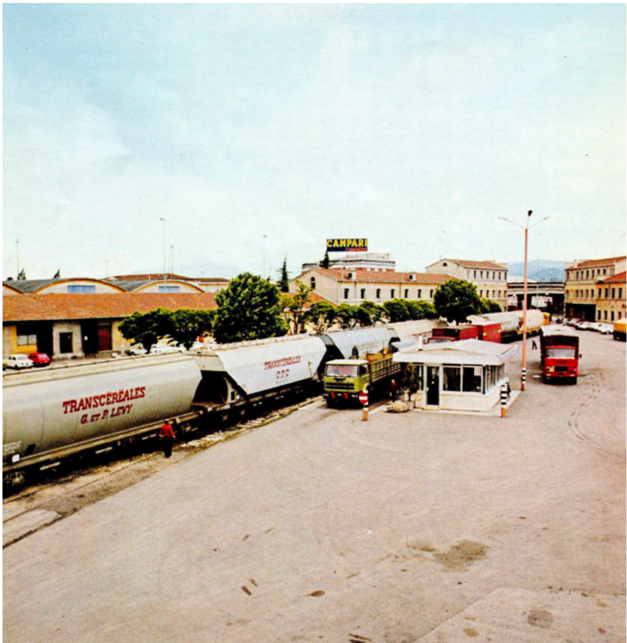
Figura 46 Ultima fase di operatività dei Magazzini, piazzale Nord, attuale sede dell'ordine degli architetti di Verona e di una sala conferenze, sullo sbocco di Viale Piave. Foto E.A. Magazzini Generali
