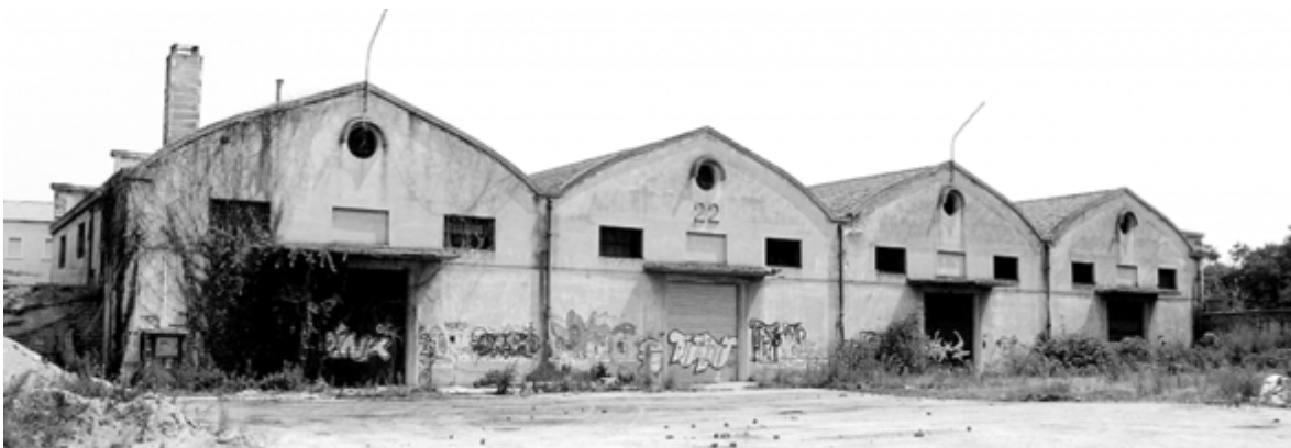
Figura 66 Facciata del Fabbricato 22, sede di Interzona.
