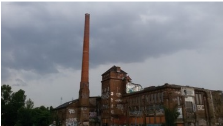
Figura 11 Area abbandonata della EISFABRIK, l'antica fabbrica del ghiaccio di Berlino: Uno degli esempi più riconoscibili di Archeologia Industriale dal fortissimo potenziale di riuso urbano. La struttura, versa in condizioni di totale abbandono e il grande vuoto antistante, conseguenza dei bombardamenti della Seconda guerra mondiale e di successive demolizioni, sono quel che resta dell'antico impianto. Tante le attività, più o meno lecite, svolte nel corso degli anni, ma la Eisfabrik attende ancora inerme il suo destino, circondata da micro isole di attività indipendenti Teepeland, e da nuovi e vincenti progetti di social housing Spreefeld. Fonte: https://www.berlino-explorer.com/nuovi-progetti-nellarea-della-eisfabrik/ .
