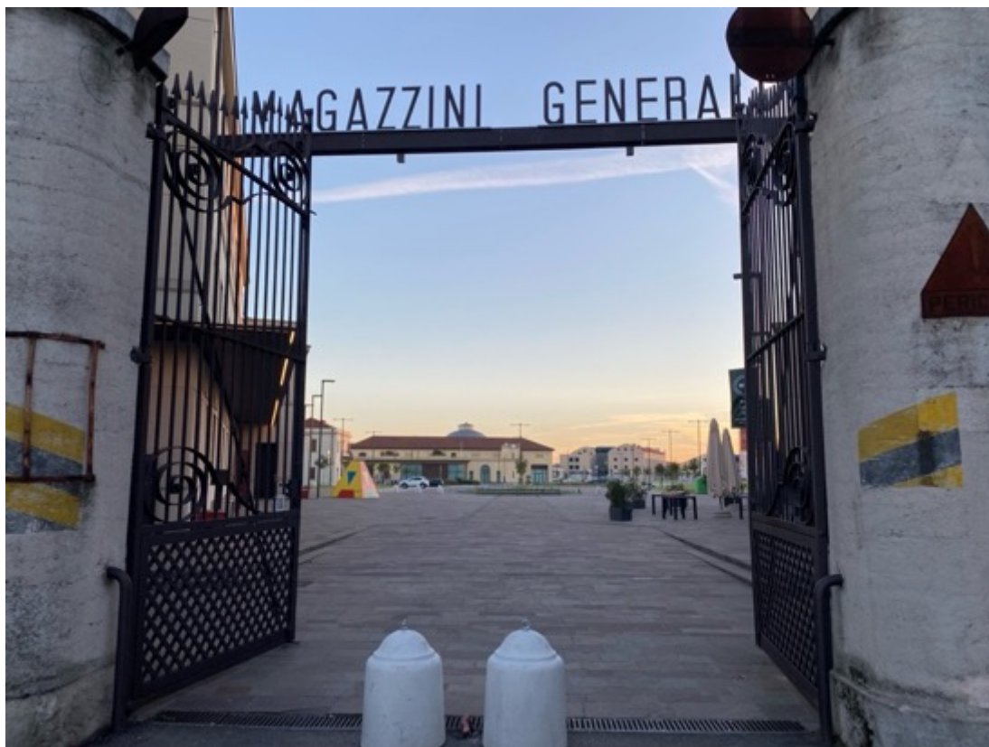
Figura 68 Antico cancello di ingresso dei Magazzini presso il Cavalcavia di Viale Piave, da qui entravano, durante il periodo di attività industriale, i treni provenienti dalla Stazione Ferroviaria e diretti alla Stazione Frigorifera. Foto dell'autore.
