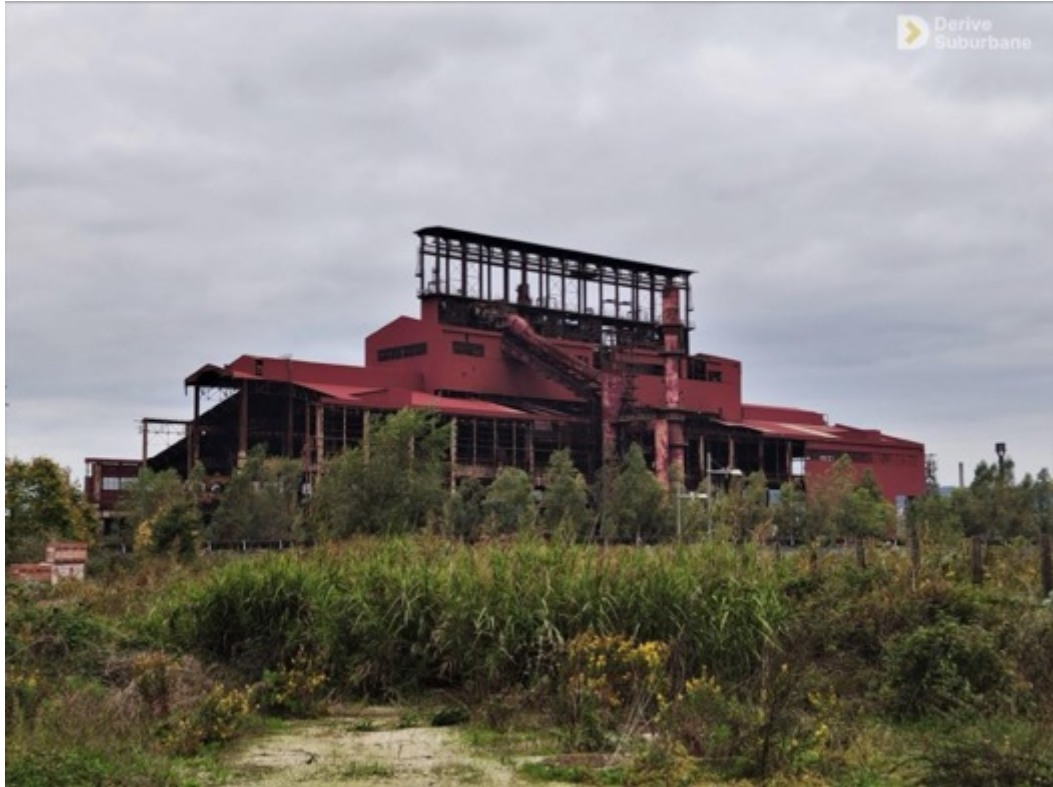
Figura 10 Edificio facente parte del complesso delle Ex Acciaierie Italsider di Bagnoli, Napoli. Lo stabilimento siderurgico di Napoli ha un passato secolare che risale al 1910 con il fenomeno di dismissione industriale che risale al 1992, nonostante i lavori di ammodernamento operati qualche anno prima che però non hanno permesso di allinearsi con le norme urbanistiche e i parametri di sostenibilità ambientale. L'area tuttora versa in uno stato di degrado e attende una completa bonifica e una rigenerazione mai giunte a causa di persistenti vincoli burocratici e controversie politiche. Nel frattempo, la ditta Italsider di Bagnoli è stata dichiarata inadempiente e i relativi piani di trasformazione urbana della zona sono naufragati inesorabilmente, tra progetti mai realizzati e altri non portati a compimento. Fonte e foto: Derive Suburbane https://derivesuburbane.it/archeologia-industriale/stabilimenti-industriali/italsider-di-bagnoli/ .
