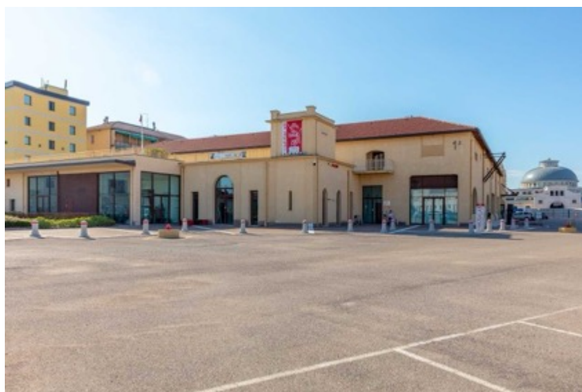
Figura 62 Veduta finale del Magazzino 1 (granaio) con l'edificio ospitante il Museo di Franca Rame e Dario Fò, sullo sfondo si vedono alcuni degli stalli bianchi di sosta presenti nel complesso.
