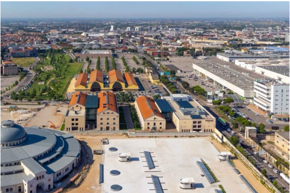
Figura 64 Altra veduta aerea della zona dei Magazzini con a destra la struttura di VeronaFiere e sulla sinistra il quartiere Borgo Roma con il Parco Santa Teresa. Foto Lonardi impresa edile.
