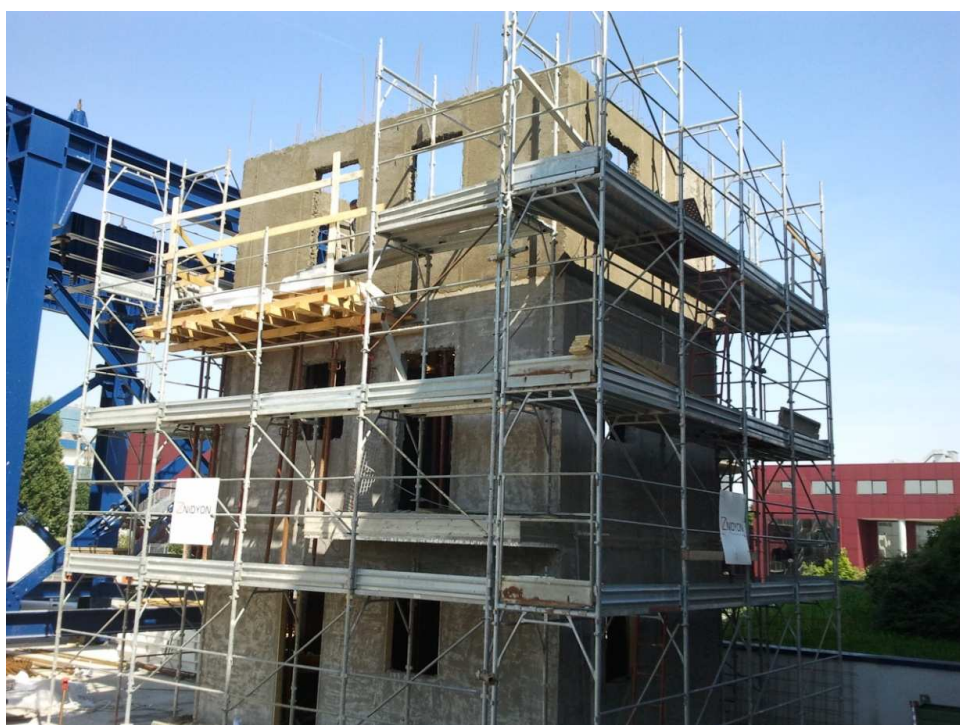
Figura 4.20: Visuale della casetta dopo la realizzazione di tutti i piani
