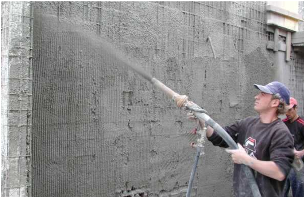
Figura 4.8: Applicazione del calcestruzzo a spritz betton
