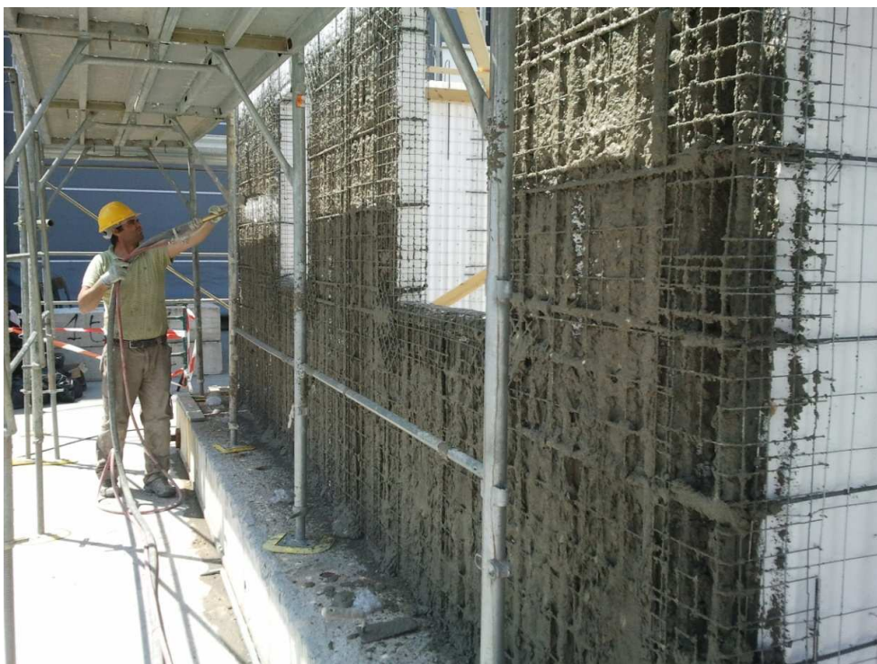
Figura 4.11: Applicazione del calcestruzzo a spritz betton
