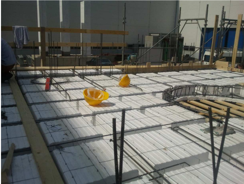
Figura 4.13: Posizionamento dei pannelli sul solaio
