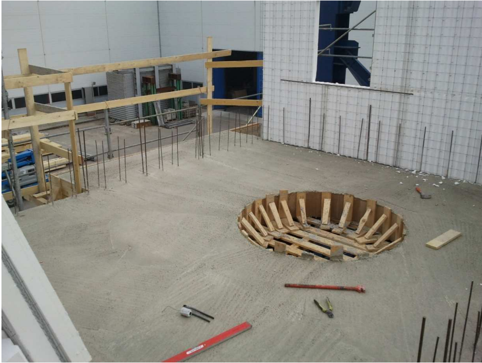
Figura 4.15: Posizionamento dei pannelli del piano 2
