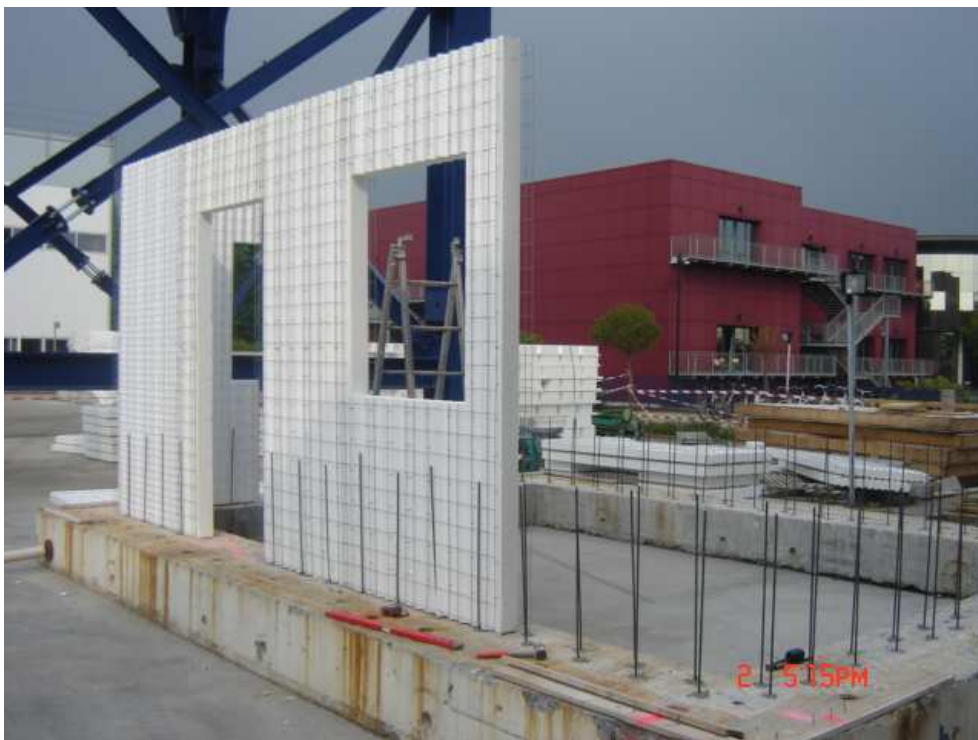
Figura 4.9: Posizionamento dei pannelli in polistirene
