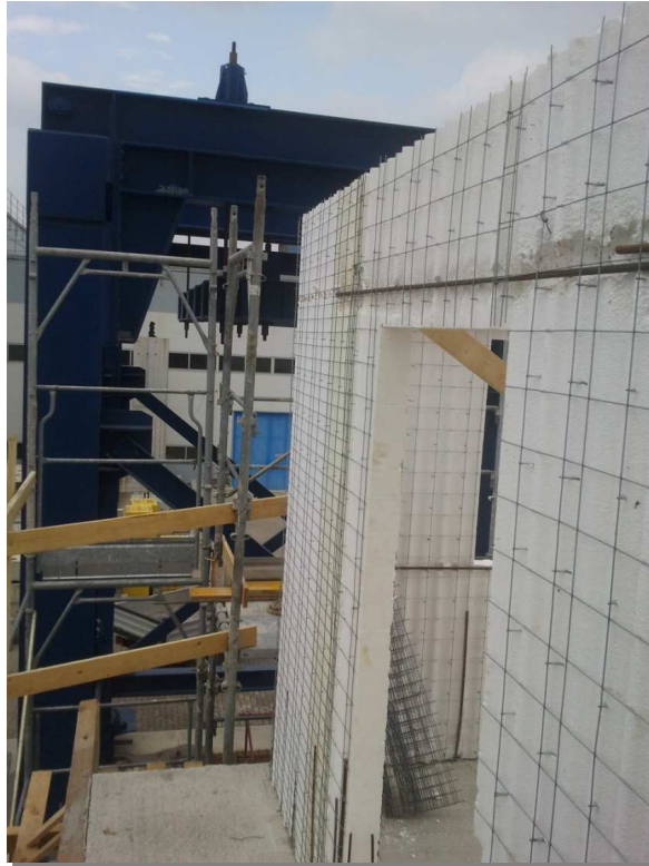
Figura 4.17: Posizionamento dei pannelli al 3° piano
