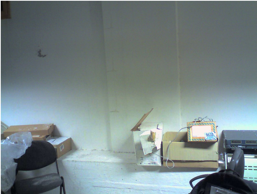
Figura 9.7 Parete Nord: particolare della lesena e della trave
