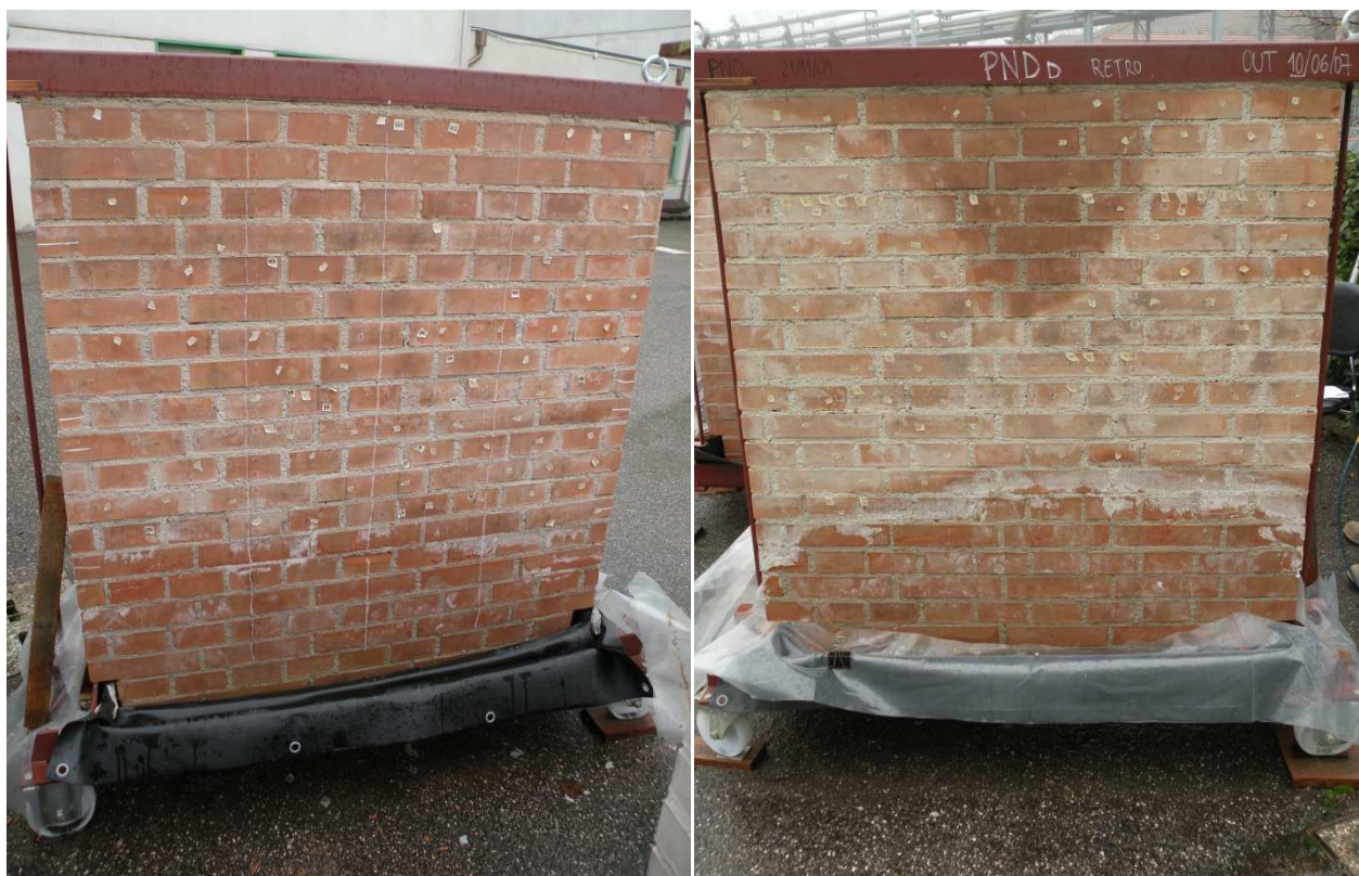
Figura 10.33 Muretto PNDD: livello di salamoia (solfato di sodio 0,5%) in vasca e condizioni superficiali del fronte (a sinistra) e del retro (a destra) durante l'acquisizione del 02/12 con antenna 900 MHz.
