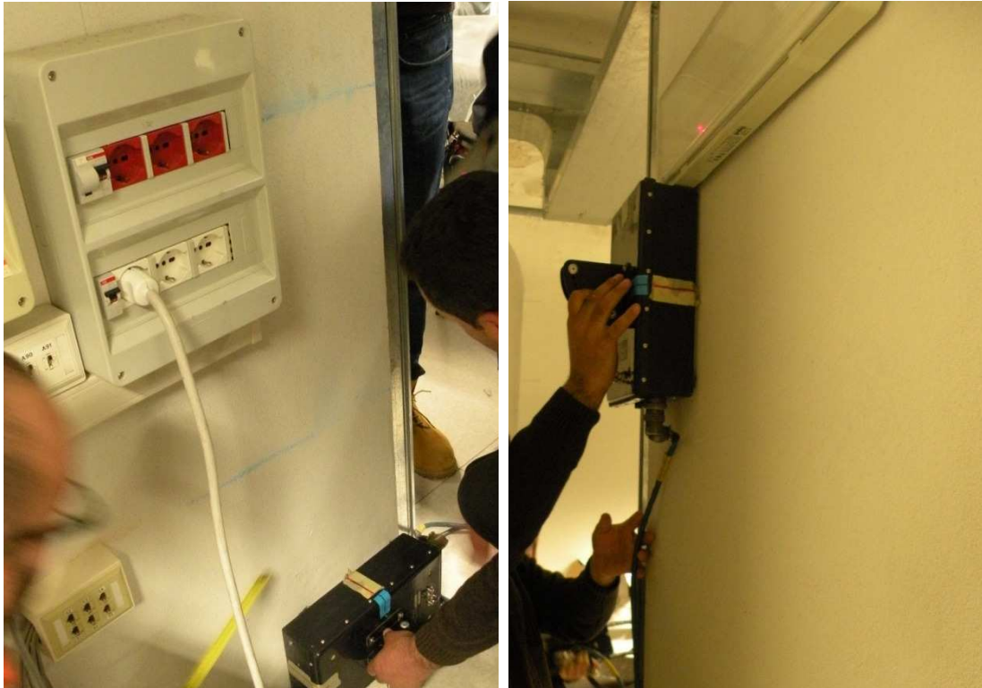
Figura 9.13 Ostacoli presenti nel Pilastro2: impianto d'illuminazione (a destra) e quadro elettrico (a sinistra).
