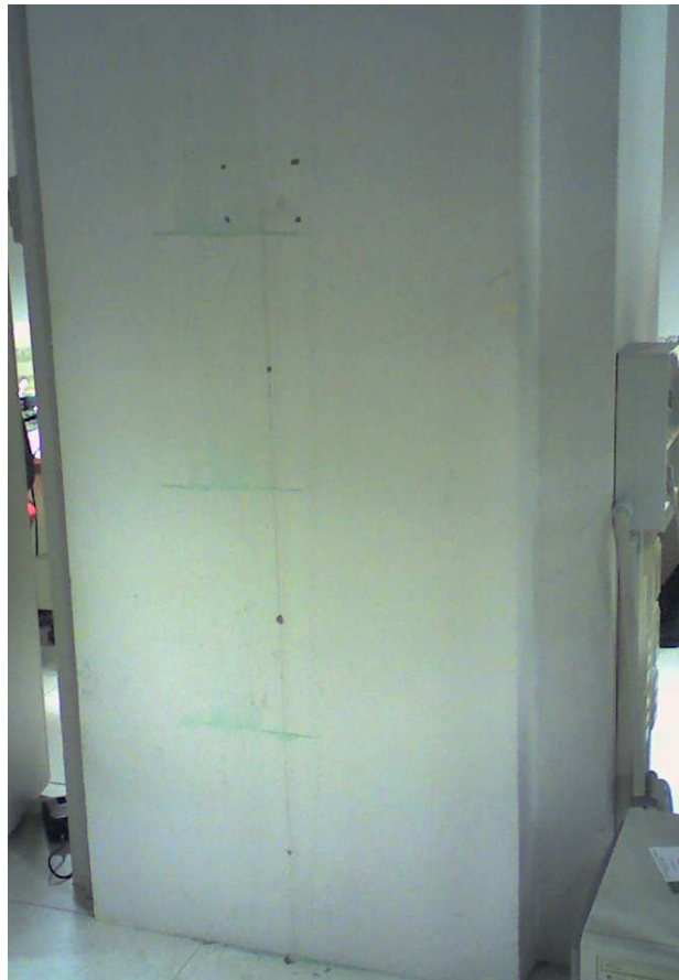
Figura 9.5 Pilastro1: visione dei riferimenti distanziometrici lungo la linea di rilievo sulla faccia
