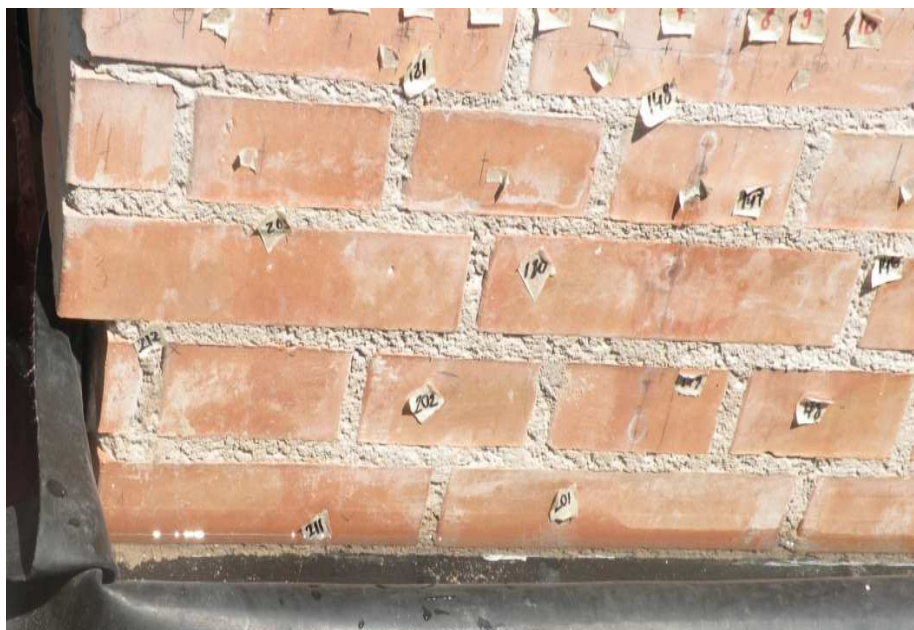
Figura 10.19 Muretto PND, fronte, ore 11:40: livello d'acqua presente nella vasca.
