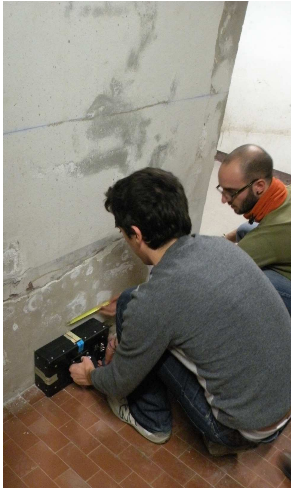
Figura 9.12 Zona ascensori: fase di misurazione della posizione del centro antenna sulla linea radar da registrare.
