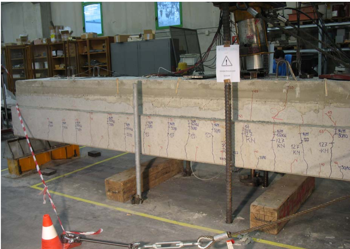
Figura 11.36: rottura della trave, zona appoggio sinistro
