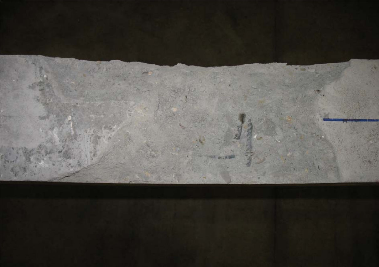
Figura 5-40: TS5 – particolare della rottura
