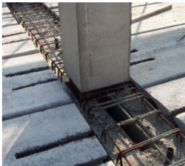
Figura 3: posa dei solai sulle travi prefabbricate
