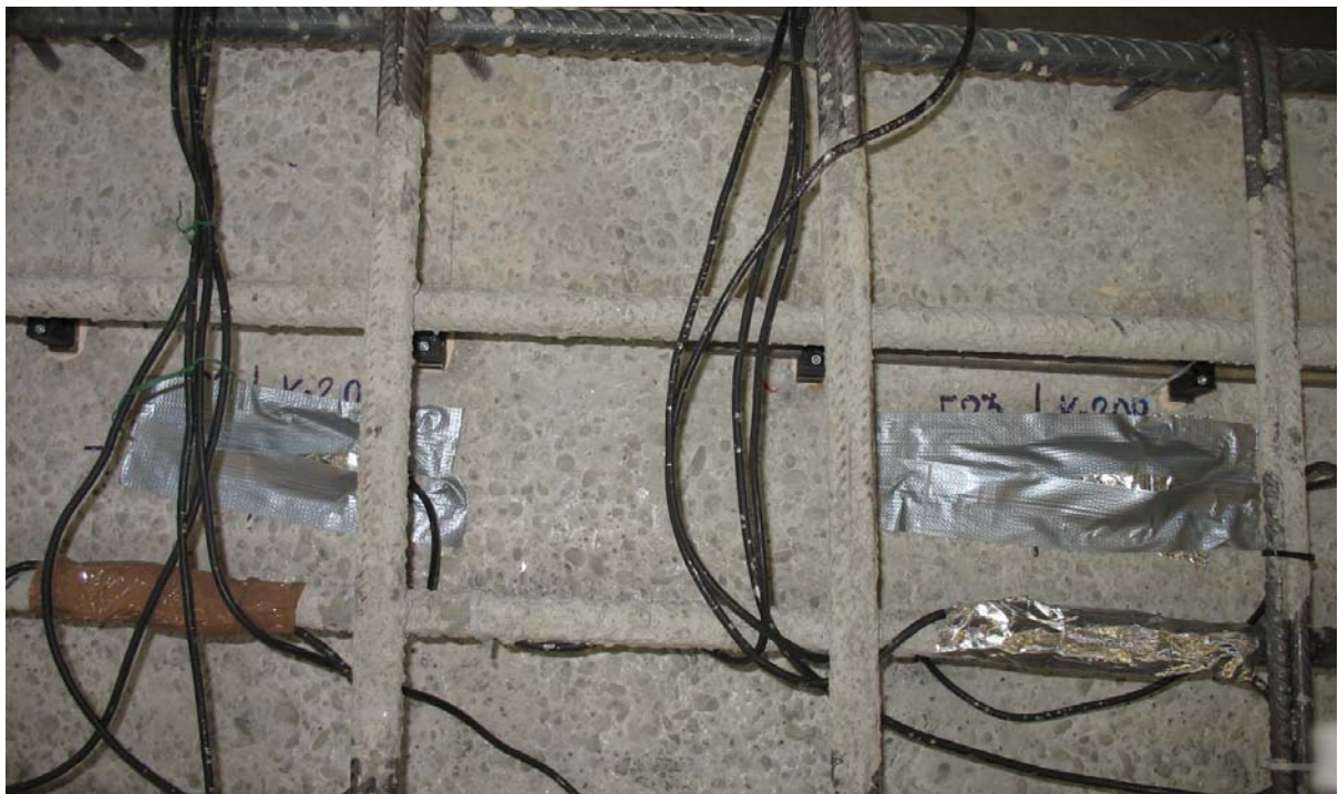
Figura 11.15: estensimetri 22-23 sul cls prefabbricato
