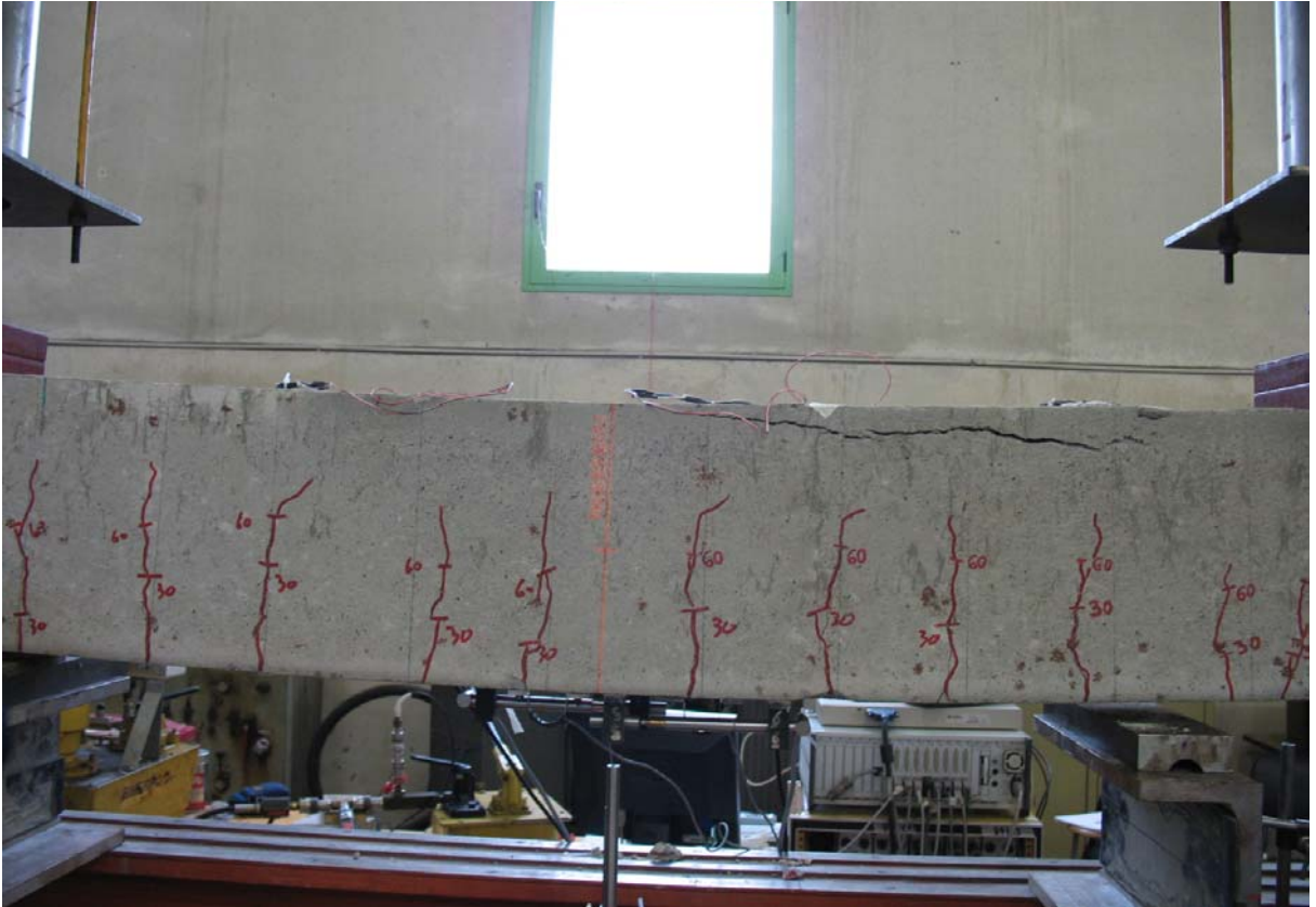
Figura 5-16: TS2 – zona di rottura
