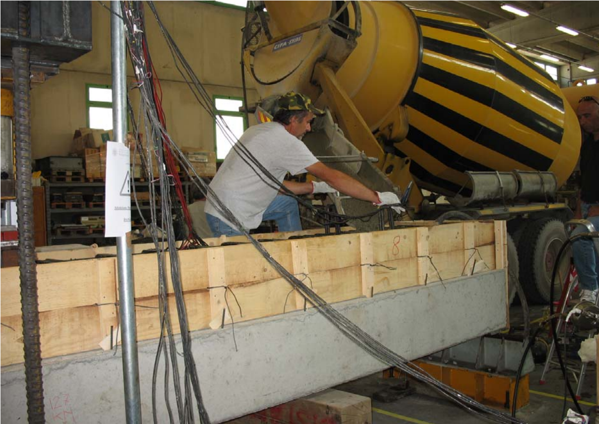
Figura 8.15: inizio fase di getto di completamento
