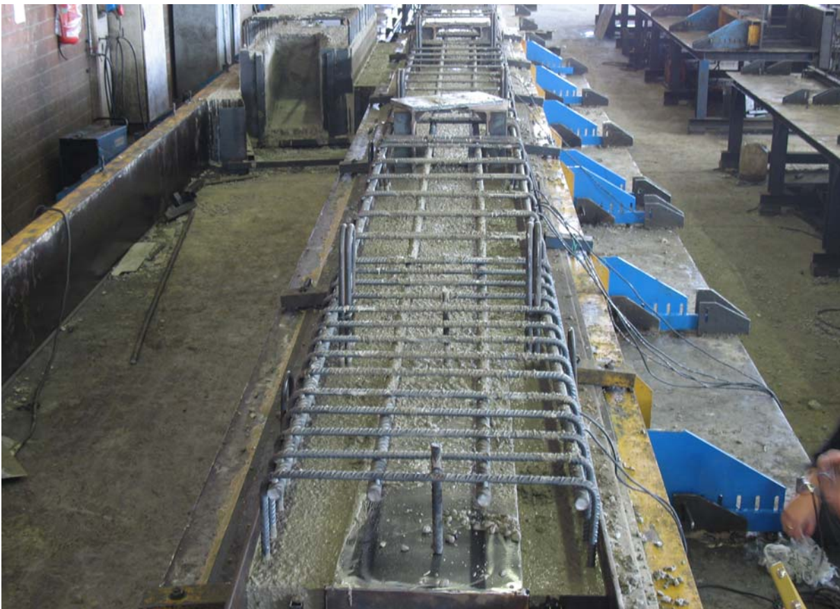
Figura 8.11: getto prefabbricato ultimato
