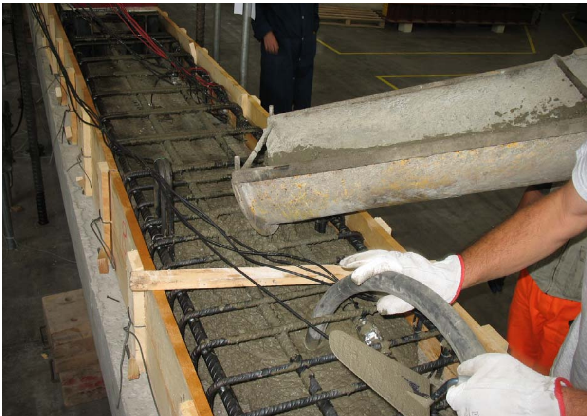
Figura 8.17: getto di completamento con vibratore in funzione
