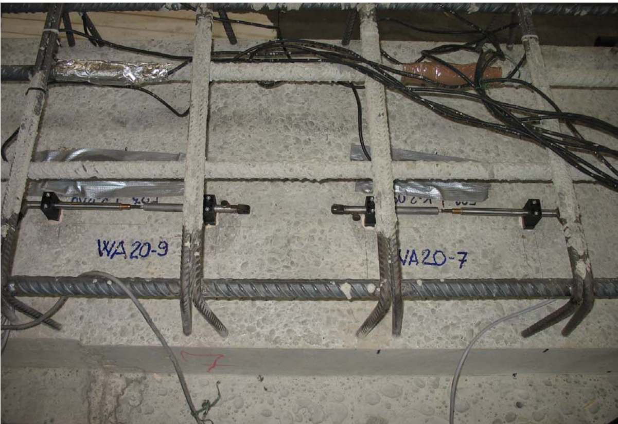
Figura 11.19: E22, E23, WA20-9 e WA20-7 sul getto prefabbricato
