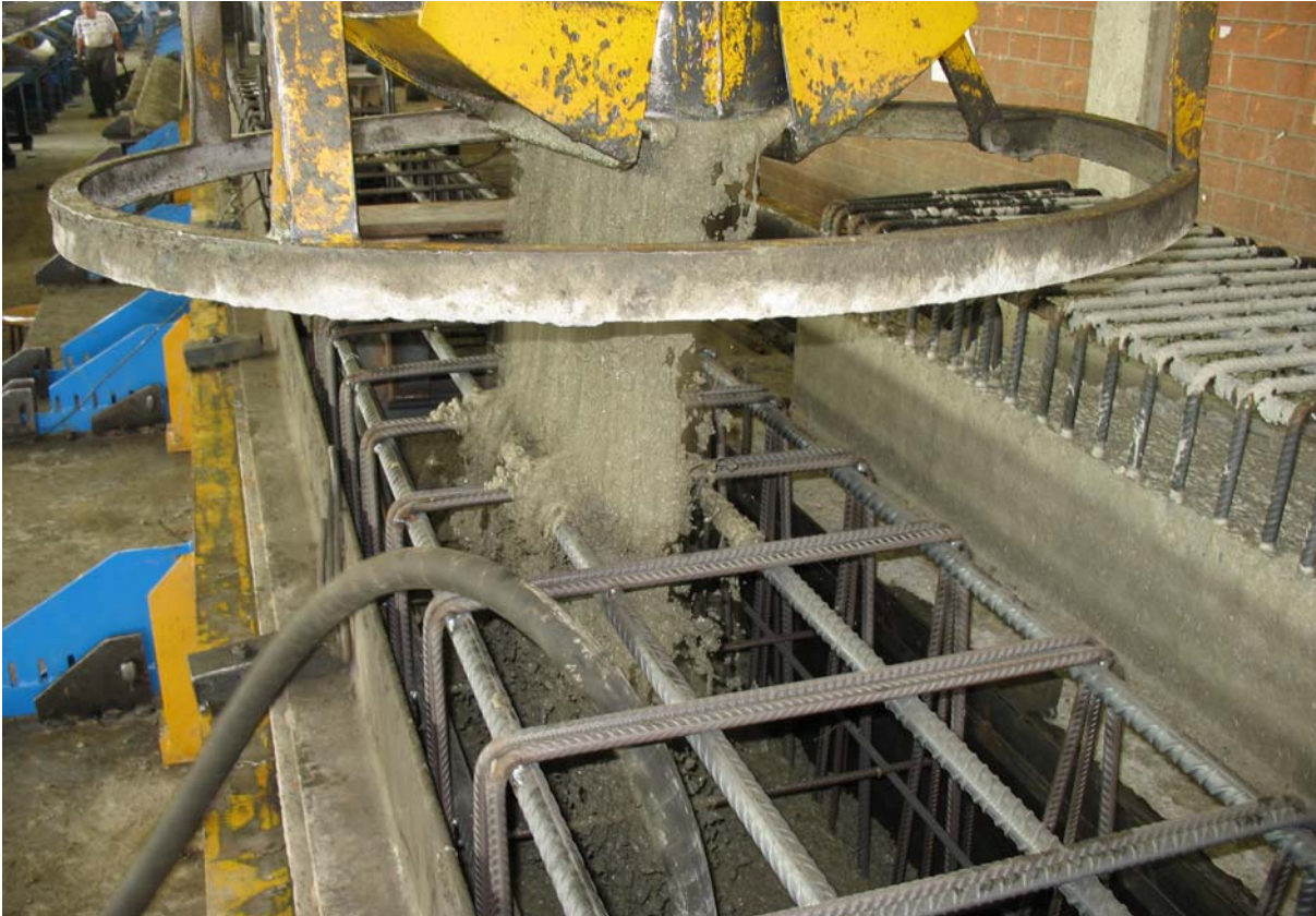
Figura 8.10: getto della trave con vibratore con vibratore in funzione
