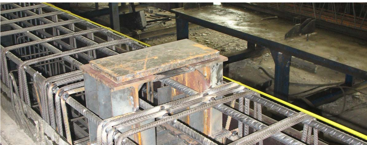
Figura 8.7: elemento metallico, punto d'applicazione del carico
