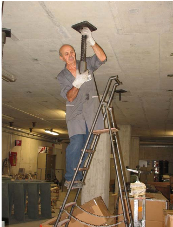
Figura 7.24: avvvitamento delle barre dalla parte inferiore del solaio rinforzato
