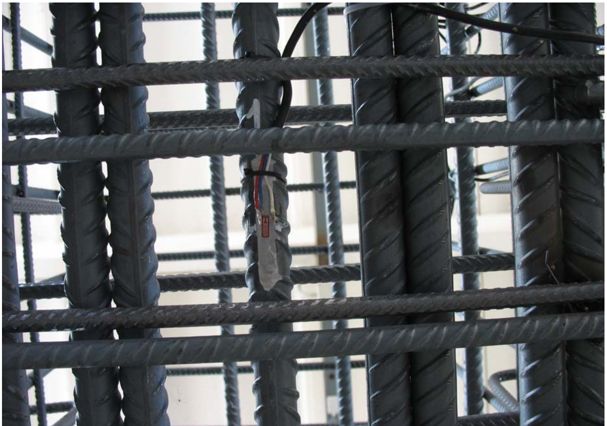
Figura 7.15: fissaggio dei cavi con fascetta e isolante trasparente
