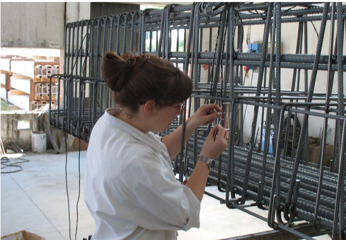
Figura 7.13: avvicinamento dei terminali con ausilio di pinze
