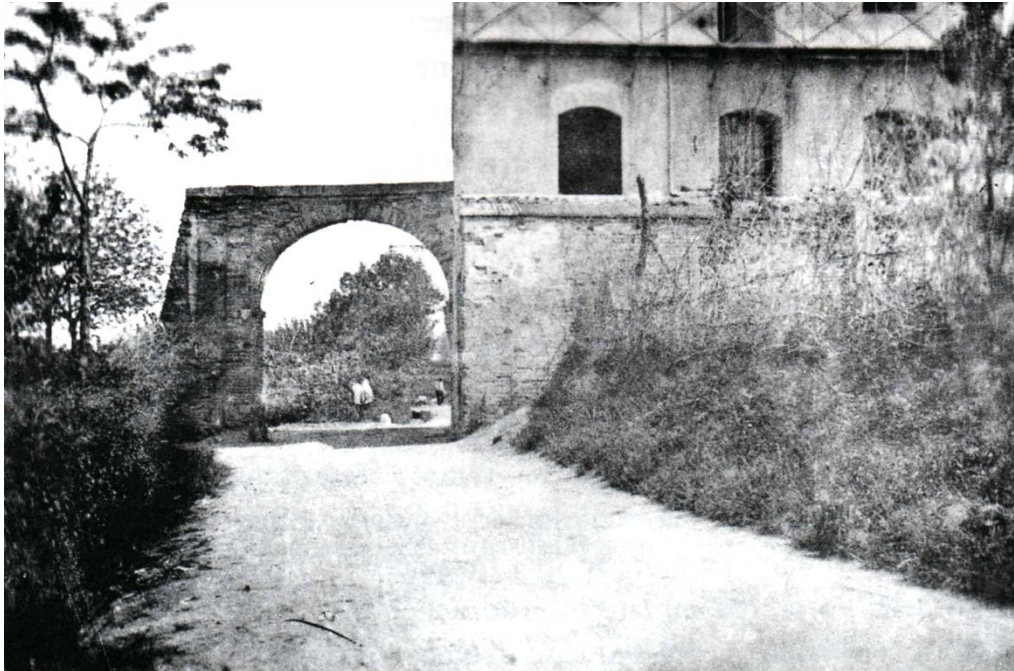
Figura 1.77 Lato interno di Porta Candiana, demolita da ignoti nel 1945 (da "Le mura di Faenza")
