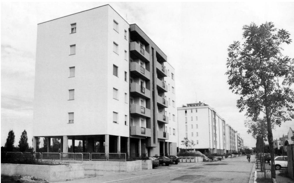
Figura 1.50 Gli edifici in linea del nuovo PEEP di Via Corbari progettato da Leonardo Benevolo (da “Faenza 100 anni di edilizia”)
