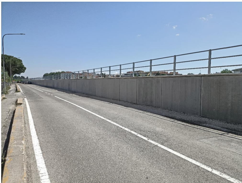
Figura 1.60 Nuovo muraglione di Via Renaccio, sorto a sostituzione del precedente distrutto dalle acque del Lamone
