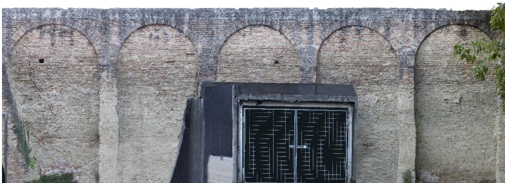
Figura 2.18 Struttura interna delle mura manfrediane ripresa nell'area fra Largo Portello e l'Ospedale
