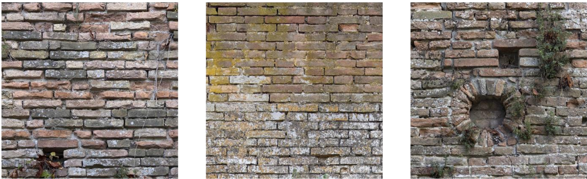
Figura 2.16 Due differenti tessiture delle mura manfrediane (a sinistra e al centro), una buca puntaia e una feritoia (a destra)
