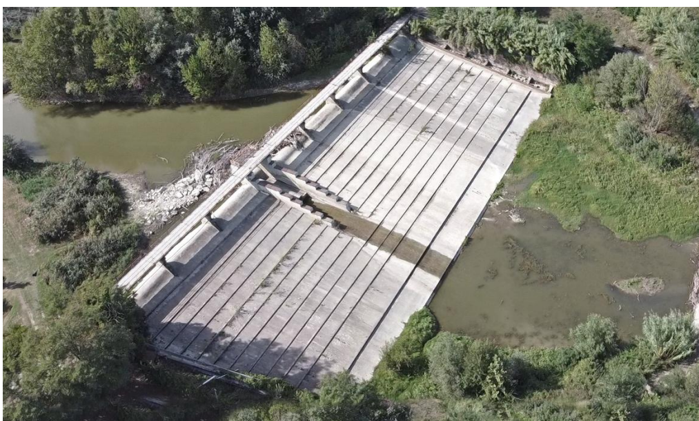
Figura 1.84 Panoramica della Chiusa di Errano, sbarramento costruito per deviare parte delle acque fluviali nel tracciato del canale artificiale diretto in città
