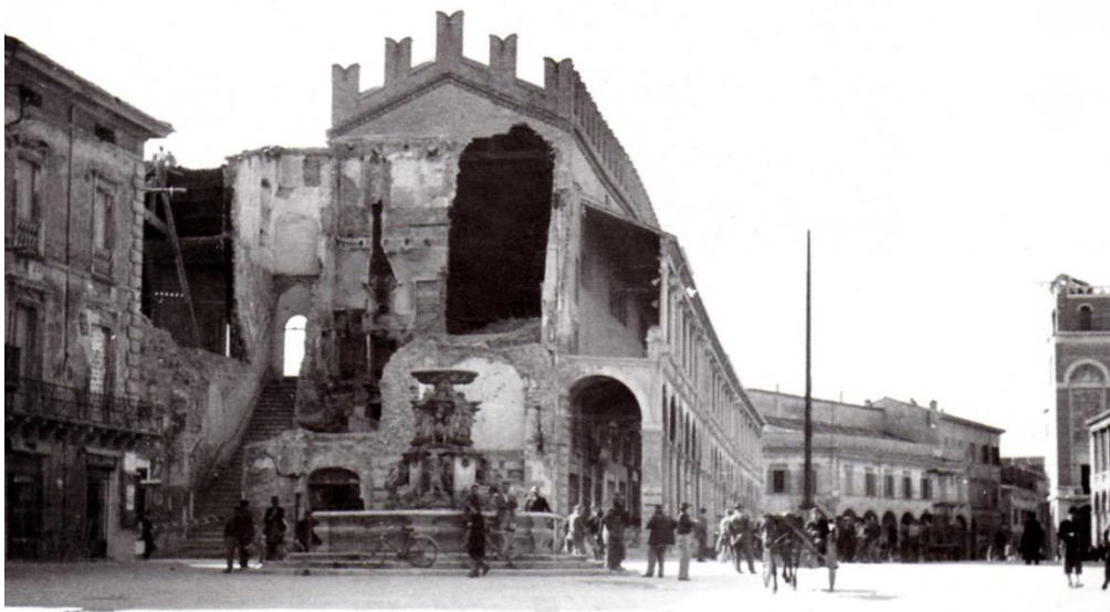
Figura 1.40 Il vuoto generato dall'abbattimento della Torre Civica, fatta saltare dai tedeschi in ritirata il 17 novembre 1944 (da "Faenza 100 anni di edilizia")
