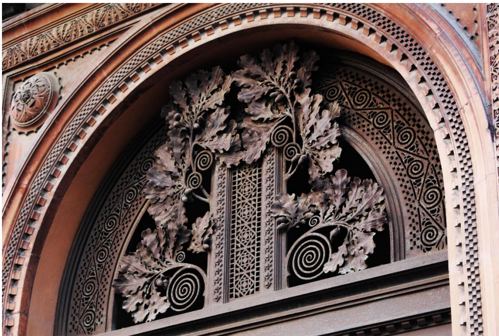
Figura 1.35 Decorazione in ferro battuto realizzata dall'Officina Matteucci per la nuova facciata della casa di famiglia in Corso Mazzini
