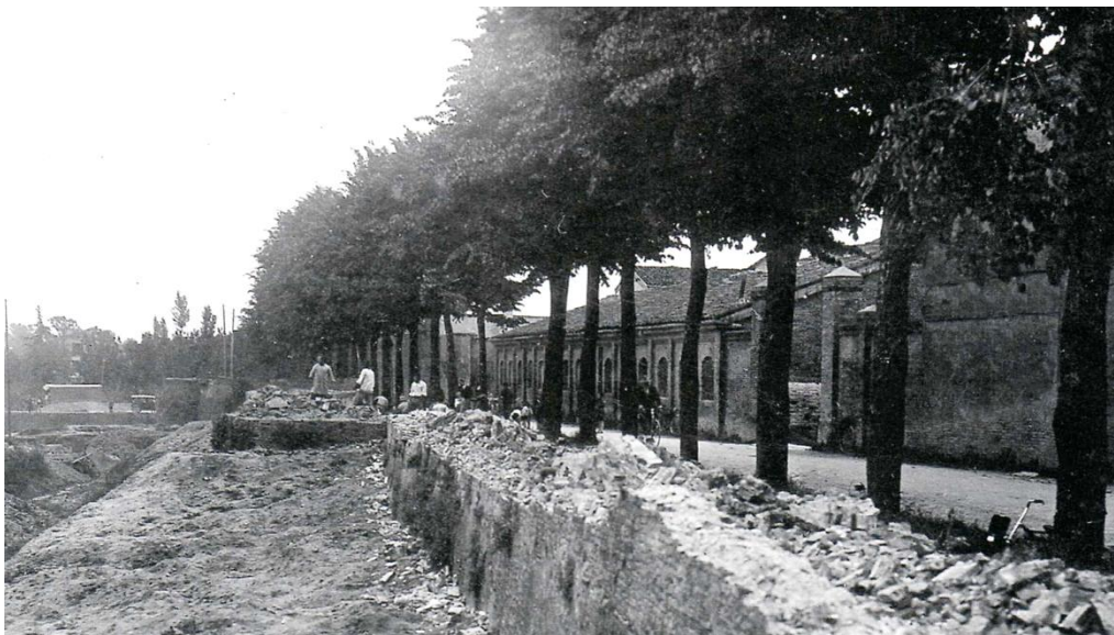
Figura 1.88 Demolizione delle Mura di San Francesco nel 1930 (sullo sfondo a destra l'attuale caserma dei Vigili del Fuoco) (da "Le mura di Faenza")
