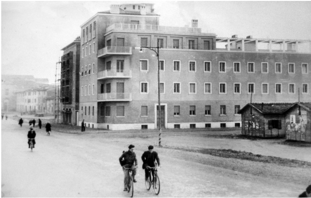
Figura 1.43 L'imbocco dell'attuale Corso Europa nei primi anni '50; a destra le baracche in legno per gli sfollati di guerra (da "Il Borgo Durbecco di Faenza")
