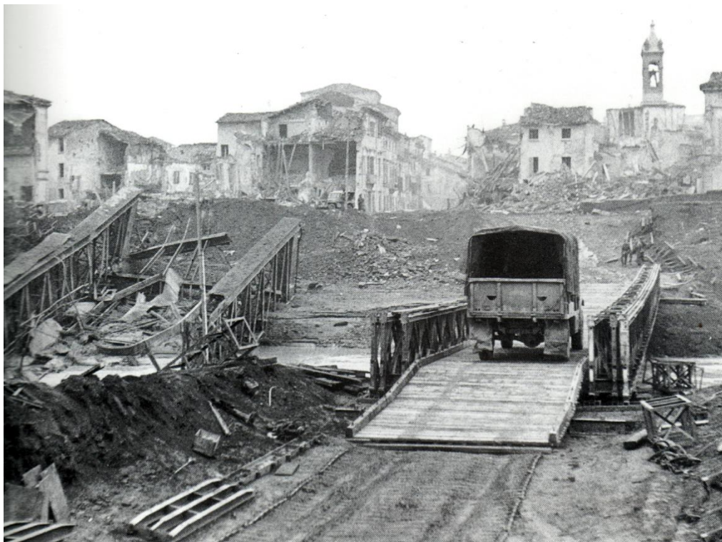
Figura 1.42 Mezzo alleato transita sul ponte provvisorio sul Lamone in direzione centro; sulla sinistra la carcassa del Ponte di Ferro, abbattuto dai tedeschi (da “La Battaglia di Faenza”)
