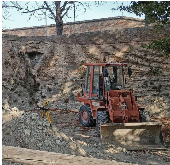
Figura 2.7 Rilievo in Via Lapi (da notare la ruspa, presente per rimuovere i depositi alluvionali visibili a sinistra)
