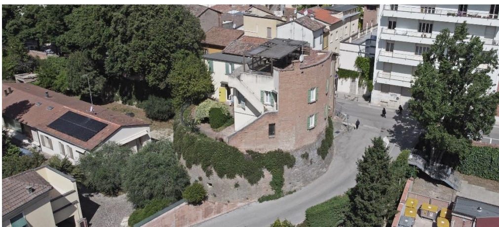
Figura 1.70 Il Torrione di Montecarlo, complesso difensivo sorto a protezione del ponte sul Lamone
