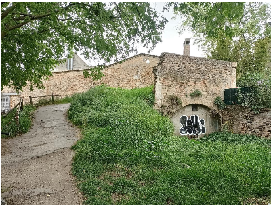
Figura 3.20 La rampa e la torretta rompitratta viste da Via Morini
