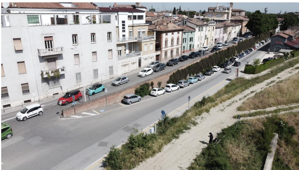
Figura 3.1 Via Mura Mittarelli e Via Ponte Romano nei pressi di Porta Ponte, con un tipico incolonnamento di auto in attesa al semaforo e in sosta a fianco delle Mura
