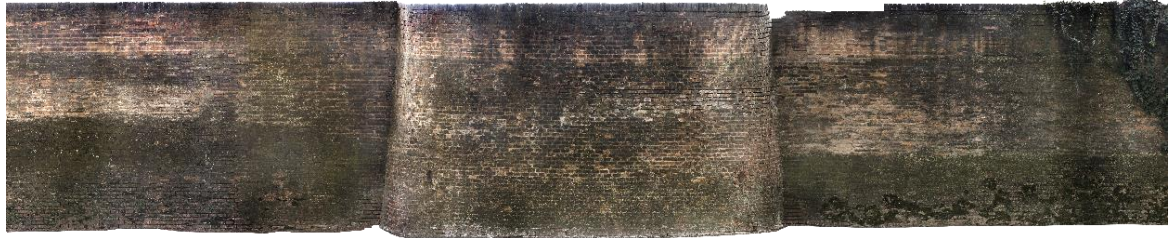
Figura 2.12 Tratto 5 (ex Mura Carceri) - lato esterno
