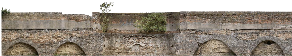
Figura 2.13 Tratto 5 (ex Mura Carceri) - lato interno
