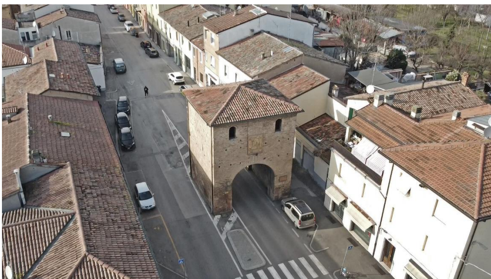
Figura 1.78 Porta delle Chiavi (in origine “dell’Ospitale”), unico accesso medievale scampato alla demolizione
