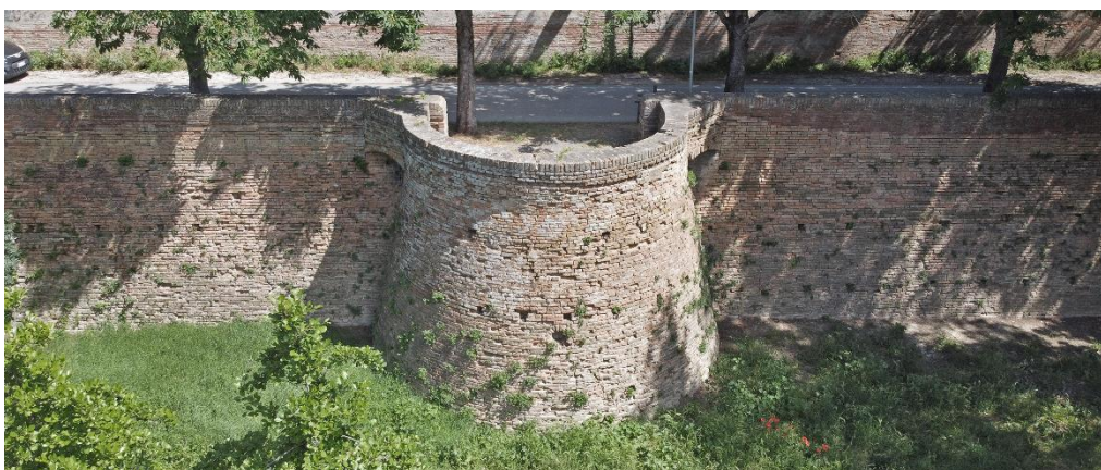
Figura 1.69 Un tipico torresino faentino, privo dei locali superiori e con la stanza ipogea interrata
