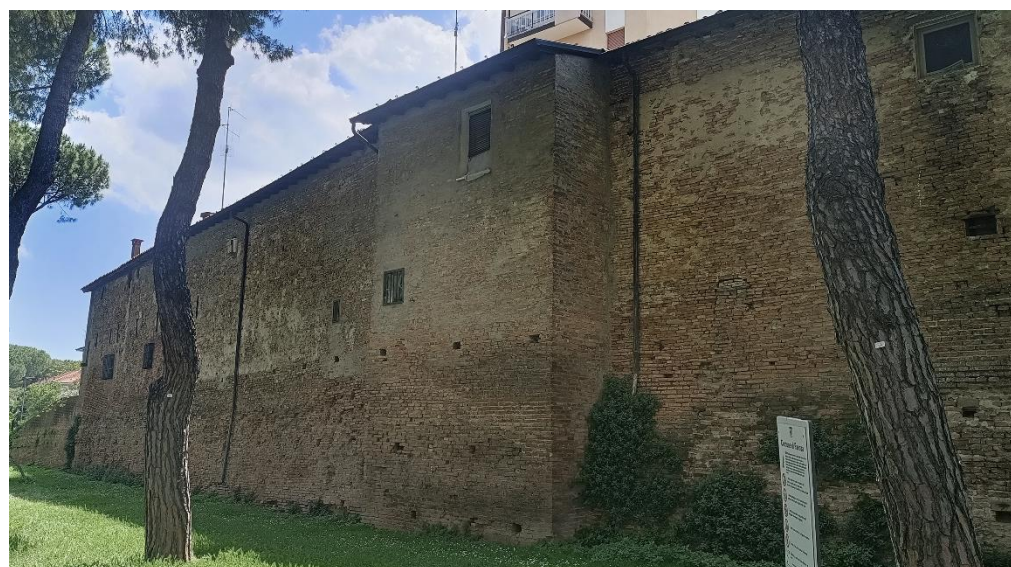
Figura 1.71 Una delle cinque torrette rompitratta disposte lungo il perimetro difensivo
