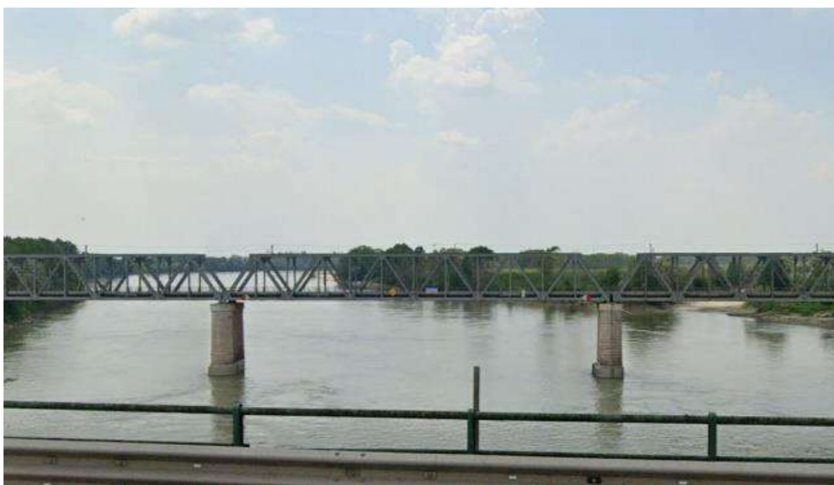
Prossimità del Po e presenza della linea ferroviaria
