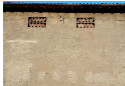
Graticcio inclinato in un edificio di Crapi (MO)
