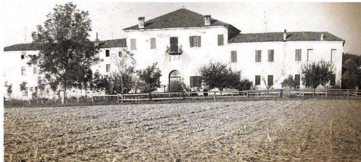
Vista su corte Nogarola che evidenzia il grande volume cubico del palazzo e le due ali minori simmetriche
