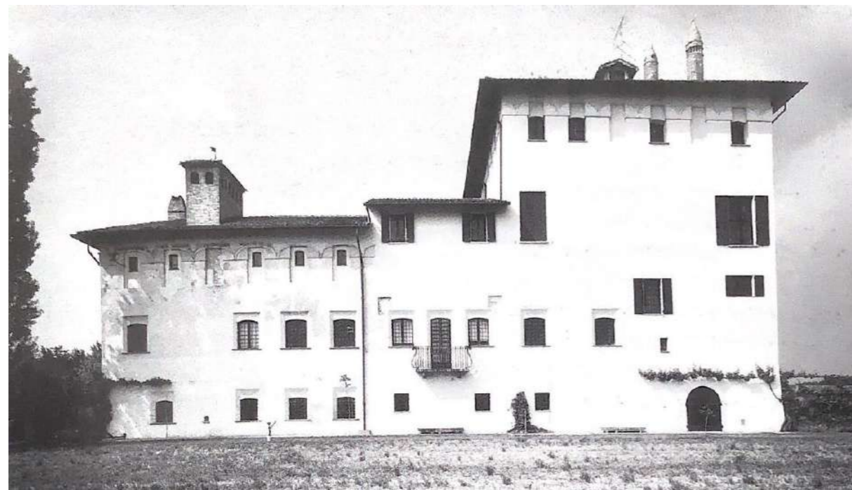
Prospetto meridionale di corte Ghirardina, che evidenzia l'articolazione in altezza dei corpi di fabbrica
