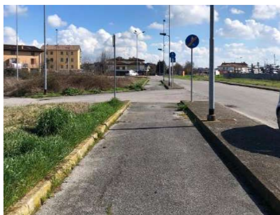
Tratto di pista ciclabile e pedonale adiacente all'area
