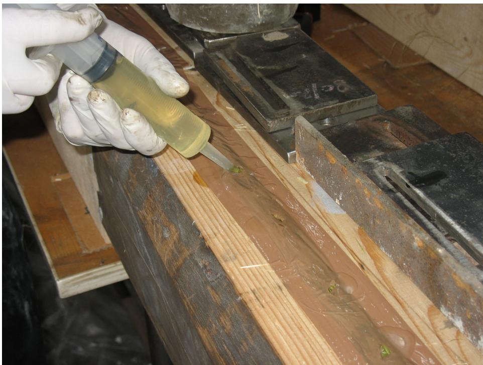
fig. 8.1.6 - inserimento della resina all'interno delle scanalature
