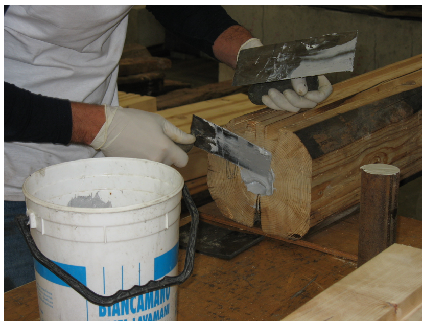
fig. 8.1.3 - preparazione dei fori per l'inserimento dei connettori a tubo
