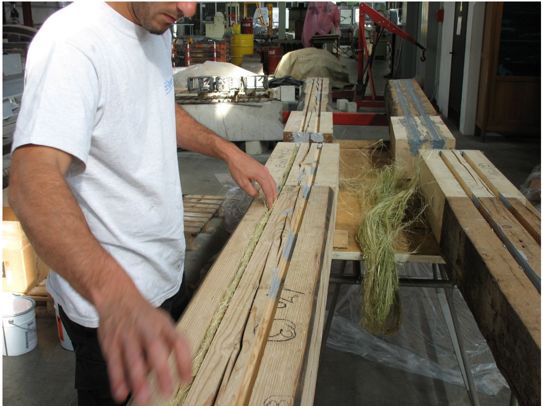
fig. 8.1.5 - predisposizione della fibra di canapa all'interno delle scanalature
