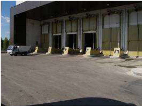
Figura10-Portoni di accesso alla fossa principale dello stabilimento di Ferrara
