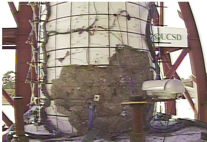
Fig. 2.1 – Danno alla base in una colonna in cemento armato convenzionale, testata sulla shake-table dell'Englekirk Structural Engineering Center di UCSD (Carrea, 2010)
