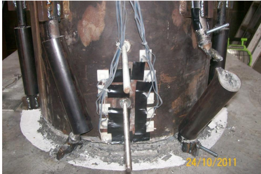
Fig. 4.8 – Distorsione dei dissipatori sul lato nord della colonna: quello di nord-est, a sinistra, si è piegato lateralmente e non si è fratturato
