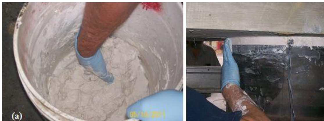
Fig. 3.8 - (a) Miscelazione dell'hydrostone e rifinitura della superficie esterna del giunto fra colonna e blocco di carico
