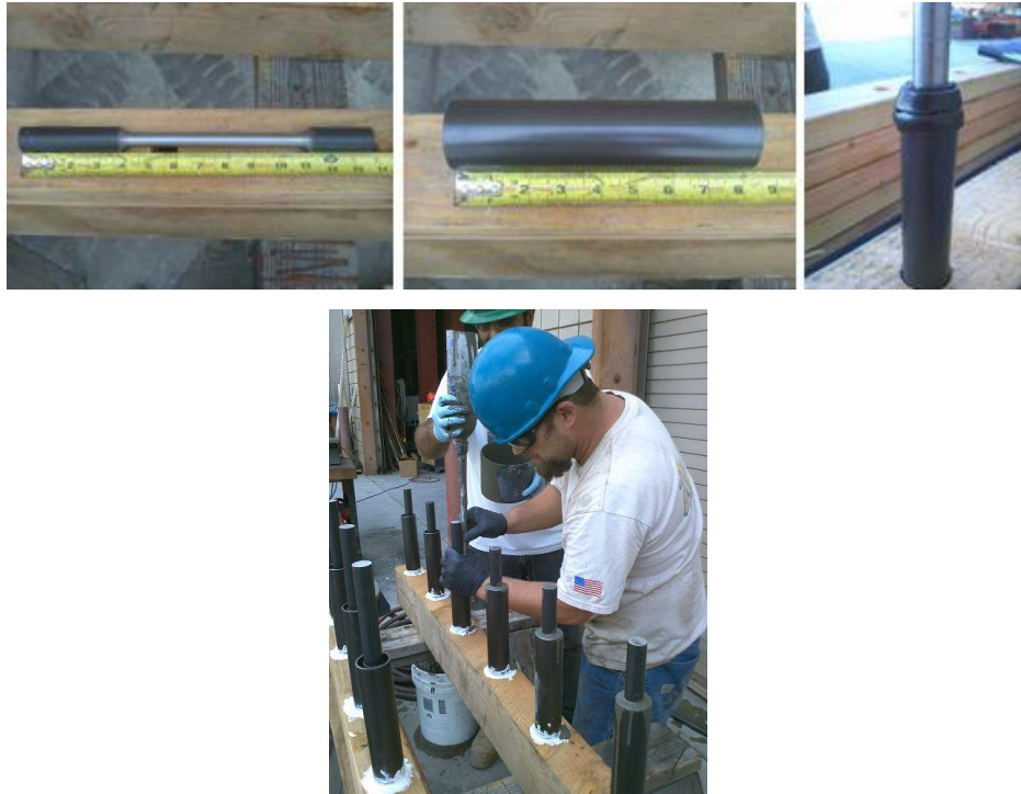
Fig. 3.20 – Realizzazione dei dissipatori esterni
