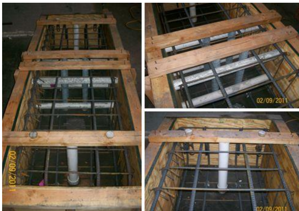
Fig. 3.14 – Realizzazione del blocco di carico
