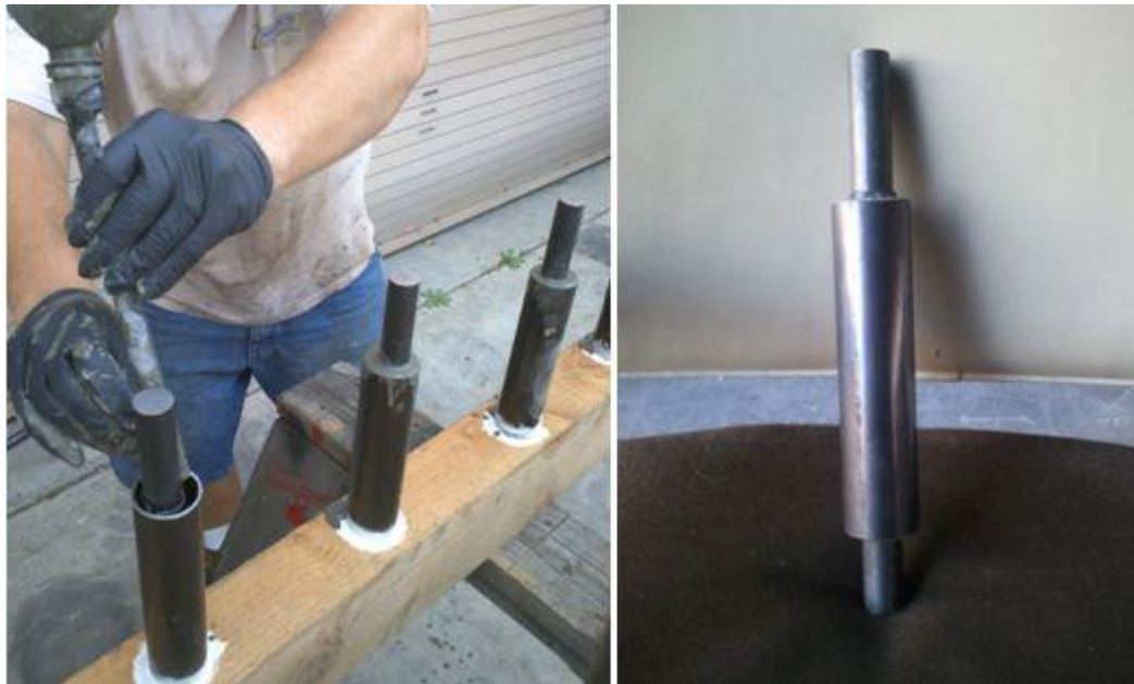
Fig. 3.7 – Assemblaggio dei dissipatori esterni
