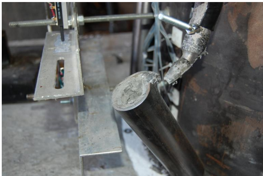
Fig. 4.27 – Frattura del dissipatore di nord-ovest
