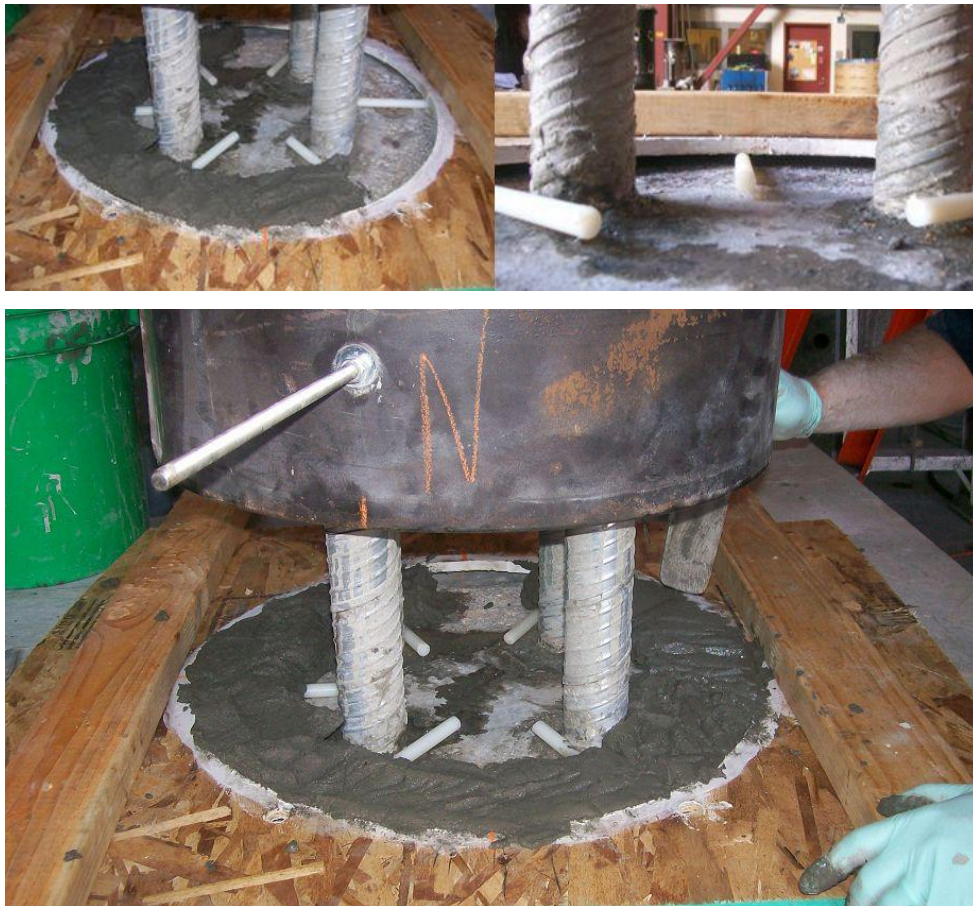
Fig. 3.6 - Dettaglio della realizzazione del giunto di malta fra colonna e fondazione
