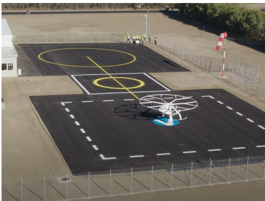
Figura 9: Vertiporto di test UV-0 nei pressi dell'aeroporto di Roma-Fiumicino
