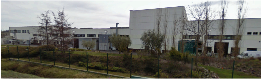
Figura 16 – Vista laterale dello stabilimento MEC3
