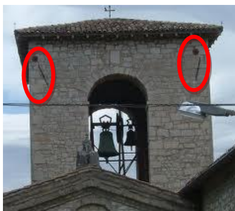
Figura 30 tiranti torre campanile
