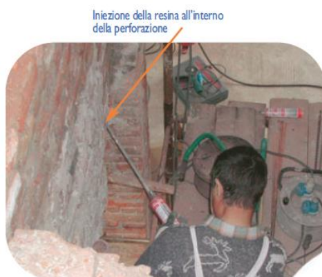
Figura 23 Realizzazione di una iniezione
