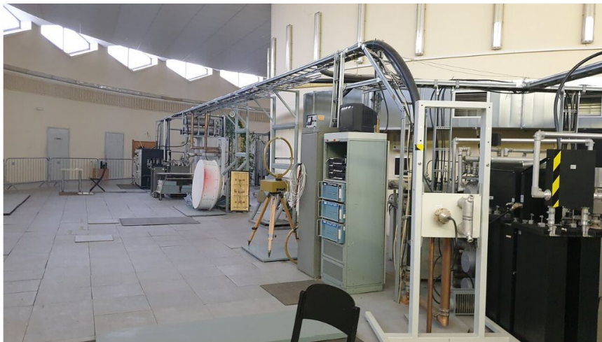
(fig. 56) Il Lithuanian Radio and Tv Center in Revisiting Solaris (sopra) e nella realtà (sotto).
