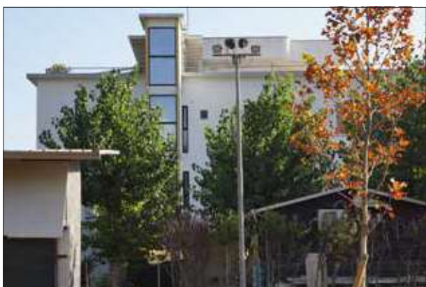
Facciata dalla parte del Parco di Ponente - sopr. 2023
