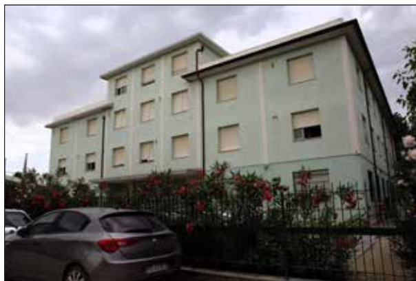
Facciata e ingresso su Viale Cabral - sopralluogo 2023
