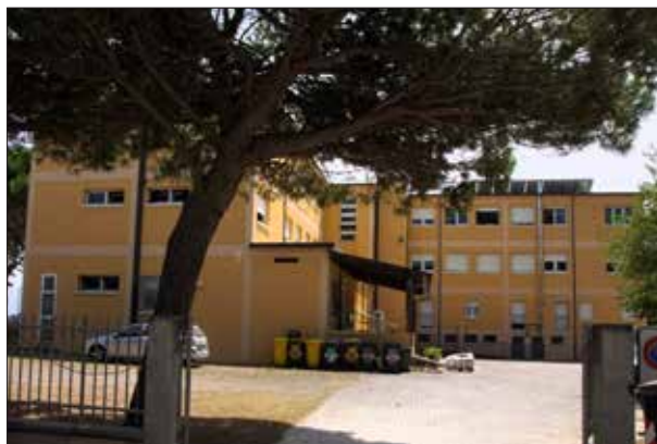
Lato Nord con ingresso carrabile - sopralluogo 2023
