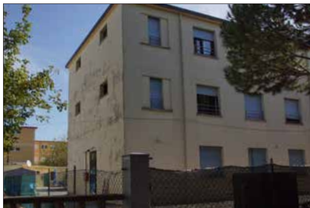
Dettaglio intonaco facciata Nord - sopralluogo 2023
