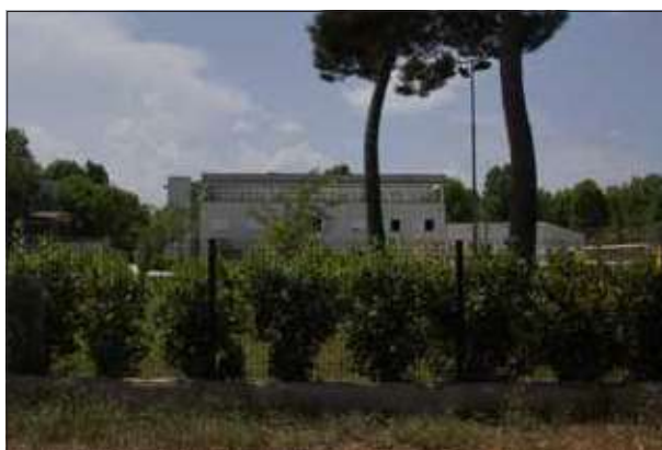
Foto da Via C. Colombo - sopralluogo 2023
