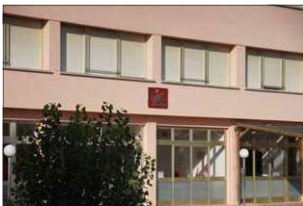
Decorazione in facciata - sopralluogo 2023
