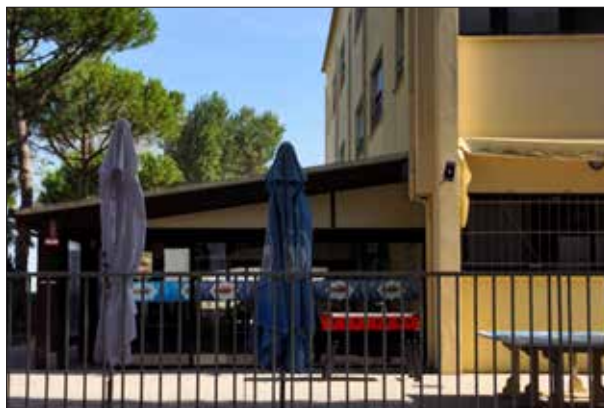
Dettaglio spazi comuni - sopralluogo 2023
