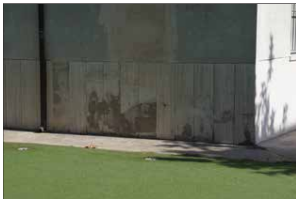
Dettaglio basamento - sopralluogo 2023
