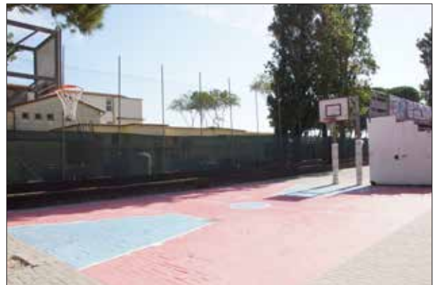
Campi da basket e spalti - sopralluogo 2023
