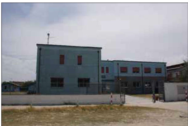
Facciata lato Via C. Colombo - sopralluogo 2023
