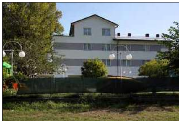
Facciata lato Parco di Ponente - sopralluogo 2023
