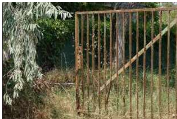
Cancello d'ingresso rotto e aperto - sopralluogo 2023
