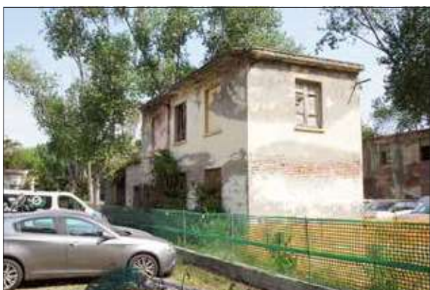
Vegetazione negli stabili - sopralluogo 2023
