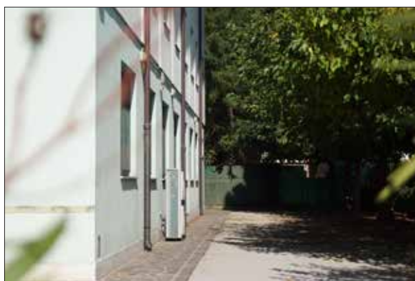
Spazio giardino lato Est - sopralluogo 2023
