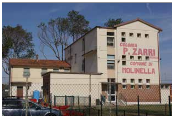
Lato Sud - sopralluogo 2023
