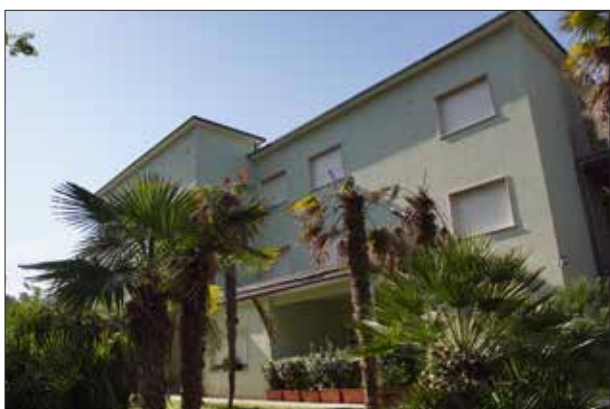
Giardino interno - sopralluogo 2023
