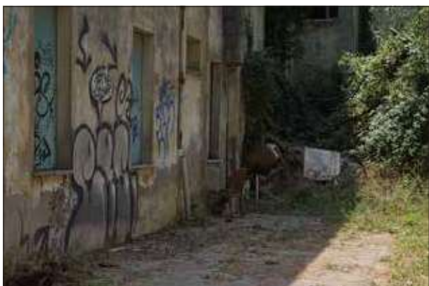
Pertinenze accessibili, accatastamento rifiuti - sopr. 2023
