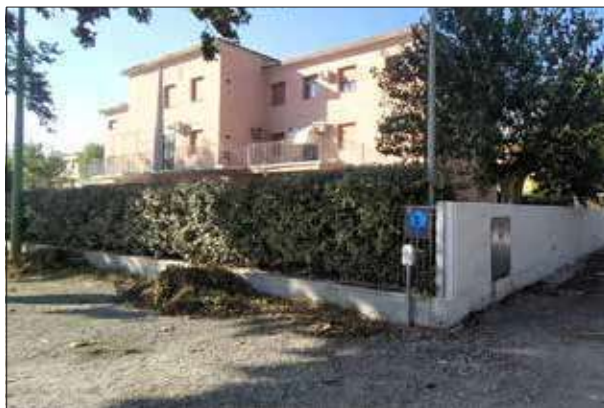
Lato Via C. Colombo e Via V. da Gama - sopr. 2023
