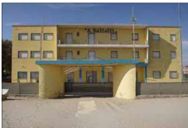
Facciata lato spiaggia con porta d'ingresso sigillata per la fine della stagione estiva - sopralluogo 2023
