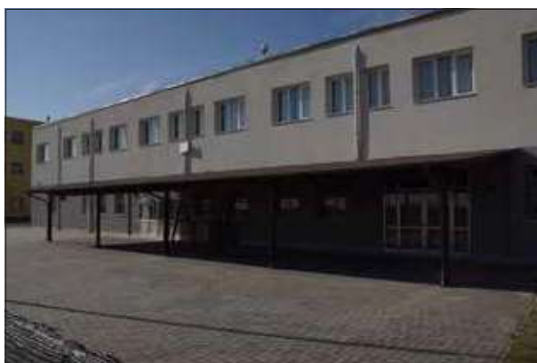
Facciata lato mare con tettoia e spazi in comune con la limitrofa Bellelli - sopralluogo 2023
