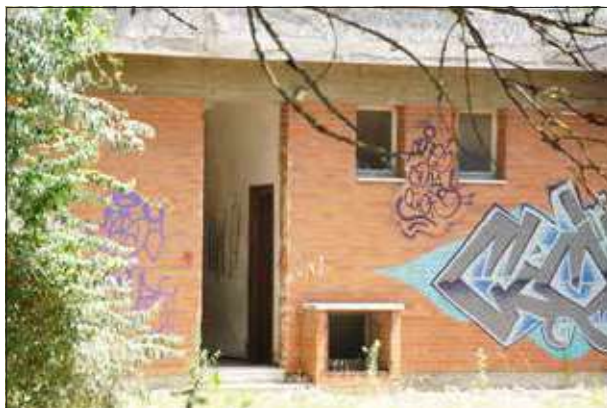
Interni piano terra accessibili - sopralluogo 2023
