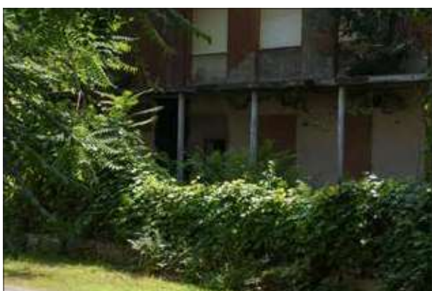
Porta aperta a piano terra nel portico laterale - sopr. 2023
