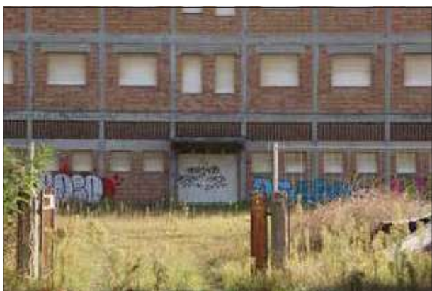
Dettaglio ingresso su Via C. Colombo con stralci di verde accatastati nel giardino - sopralluogo 2023
