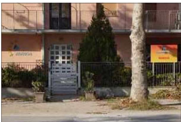
Ingresso su Via C. Colombo - sopralluogo 2023
