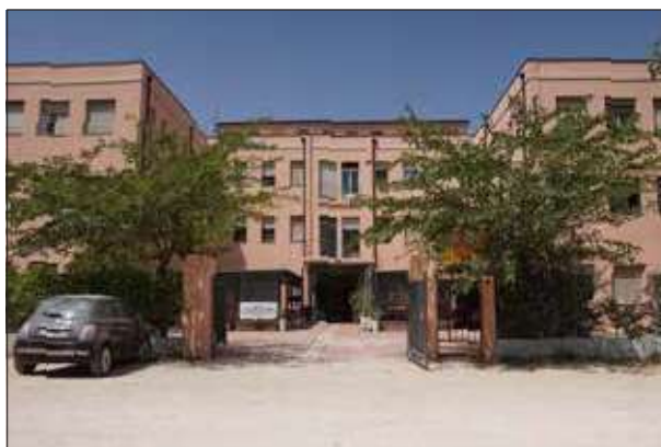
Ingresso Circus - sopralluogo 2023
