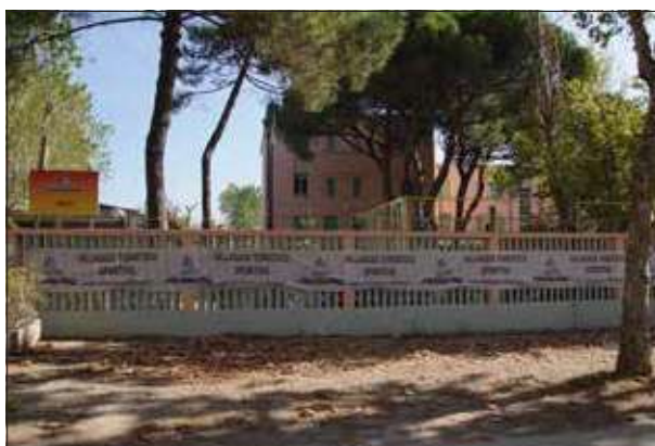
Foto da Via C. Colombo - sopralluogo 2023
