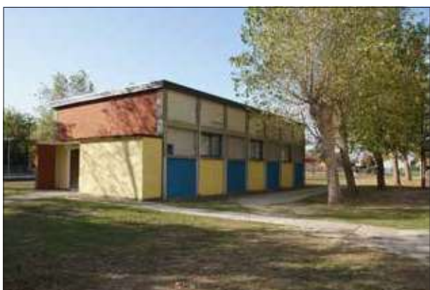
Edificio nel giardino - sopralluogo 2023
