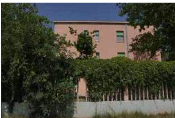
Vegetazione sulla cancellata perimetrale - sopralluogo 2023
