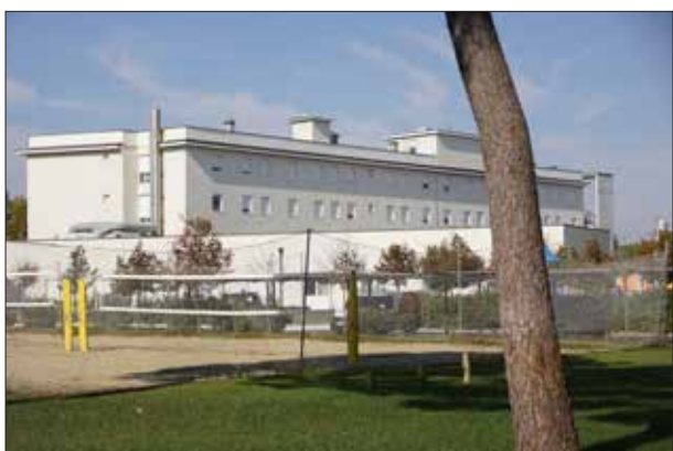
Nuovo stabile costruito al posto della precedente Colonia Trento - sopralluogo 2023
