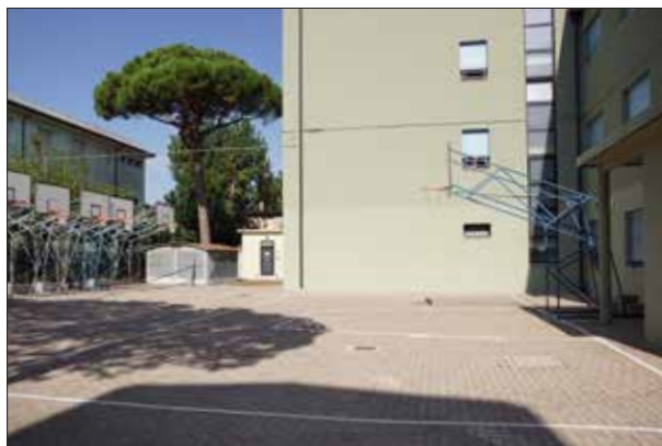
Campo da Basket giardino interno lato Viale Cabral sopralluogo 2023
