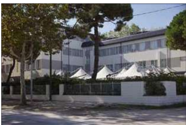
Angolo con Via C. Colombo - sopralluogo 2023
