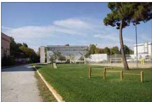
Arretramento del nuovo stabile rispetto al precedente sopralluogo 2023
