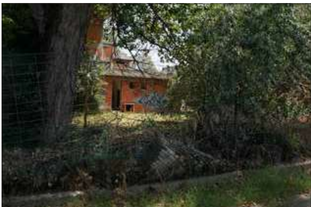
Recinzione rotta su Via Vasco de Balboa - sopr. 2023
