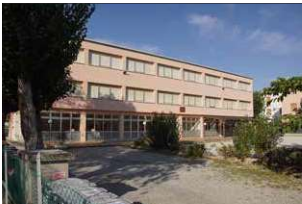
Facciata da Via C. Colombo - sopralluogo 2023
