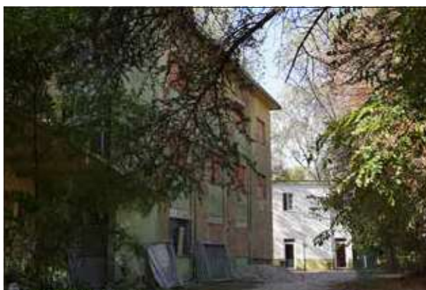
Chiusura delle finestre a piano terra - sopralluogo 2023
