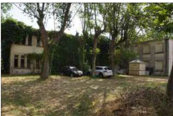
Vegetazione sullo stabile e finestre con reti - sopr. 2023
