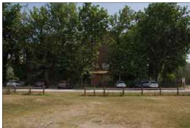
Stabile lato Piazza Marco Polo - sopralluogo 2023
