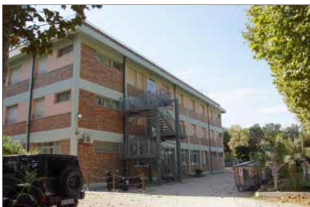
Giardino a ghiaio lato Nord - sopralluogo 2023
