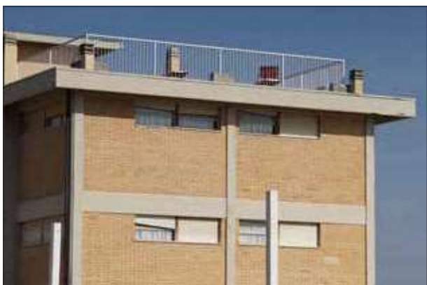
Terrazza sul tetto - sopralluogo 2023
