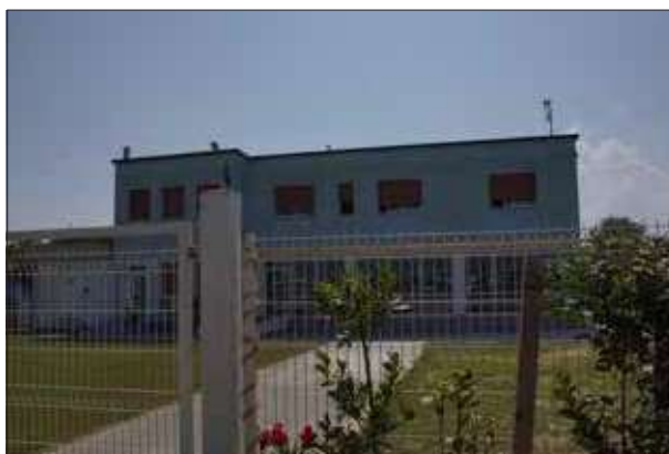
Facciata lato spiaggia con giardino - sopralluogo 2023
