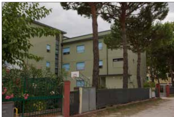
Lato su Viale Cabral - sopralluogo 2023
