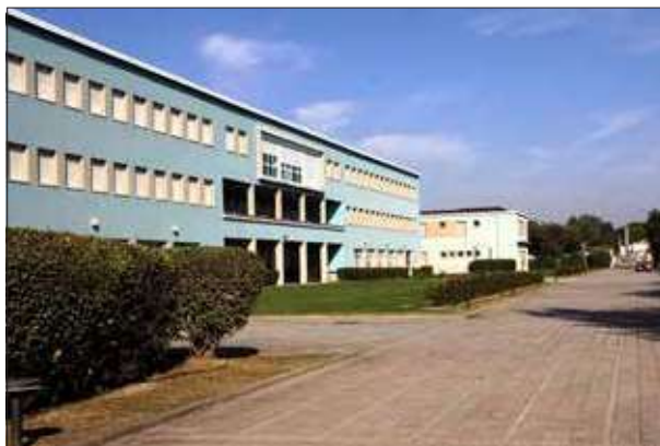
Facciata rivolta lato mare - sopralluogo 2023
