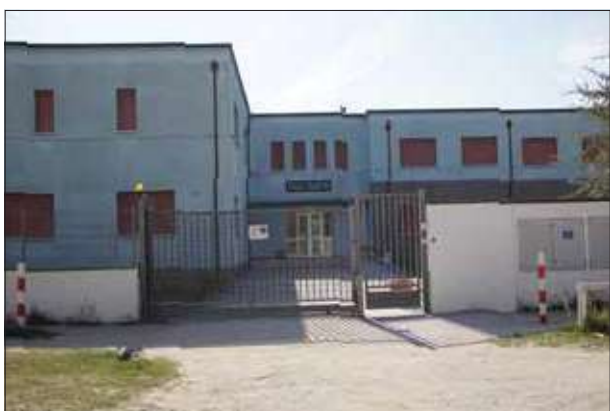
Ingresso su Via C. Colombo - sopralluogo 2023
