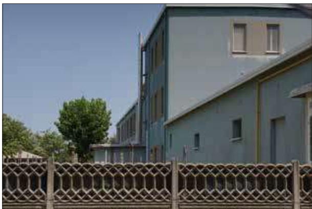
Lato su Via Vasco de Gama - sopralluogo 2023
