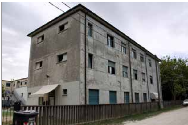
Facciata Nord su Viale M.A. Pinzon - sopralluogo 2023
