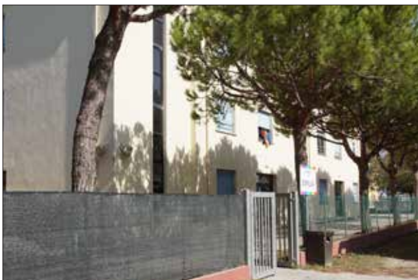
Cancello pedonale lato Viale Cabral - sopralluogo 2023
