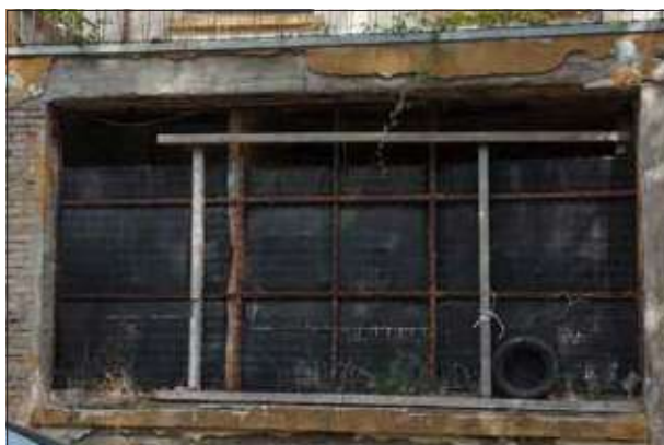
Chiusura portico e ingressi - sopralluogo 2023
