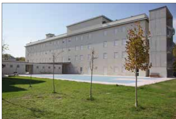
Campo sportivo e portico di ingresso da Via C. Colombo sopralluogo 2023
