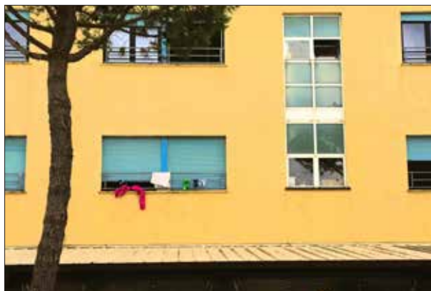
Dettaglio lato Viale Cabral Nord - sopralluogo 2023
