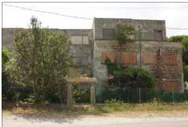
Facciata su Via da Pian del Carpine - sopralluogo 2023
