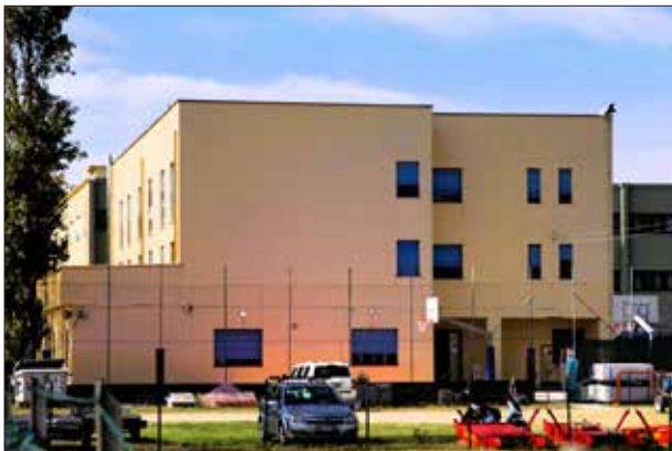
Lato verso la spiaggia - sopralluogo 2023
