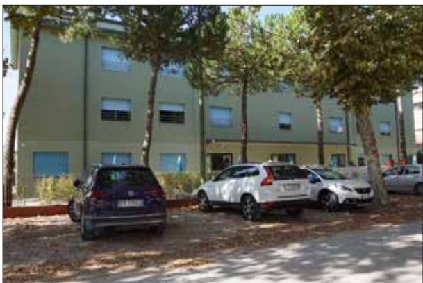
Facciata su Via C. Colombo - sopralluogo 2023
