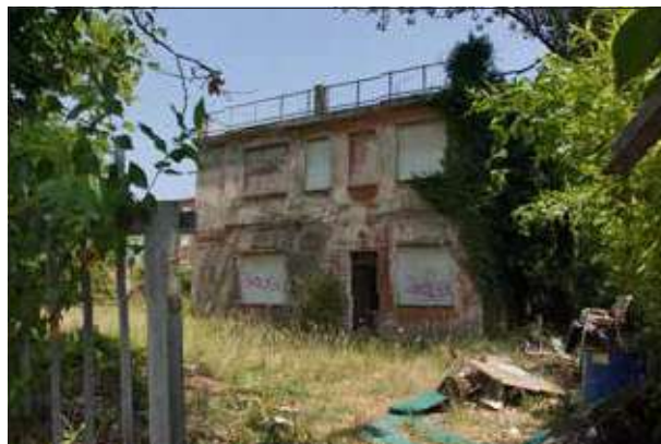
Secondo varco nella recinzione su Via Vasco de Balboa sopralluogo 2023
