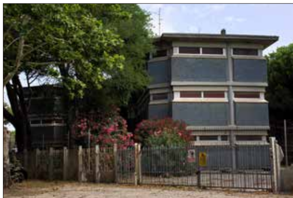
Ingresso lato Via C.Colombo - sopralluogo 2023
