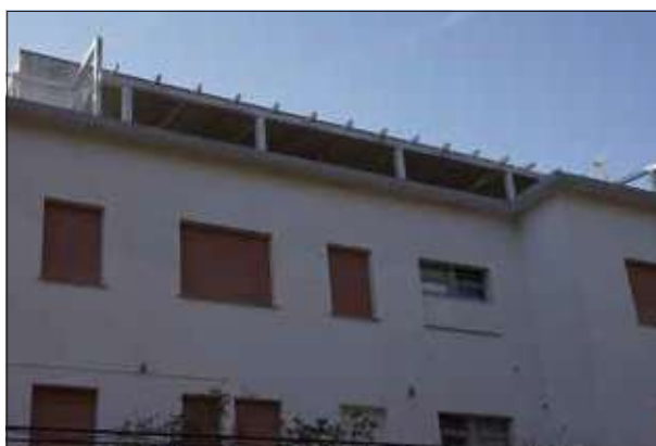
Dettaglio copertura - soprallugo 2023
