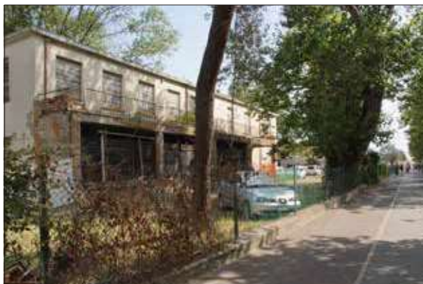
Facciata su Via Cavour con davanti ciclabile - sopr. 2023
