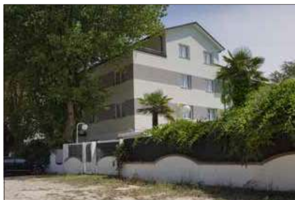
Ingresso su Via C. Colombo - sopralluogo 2023
