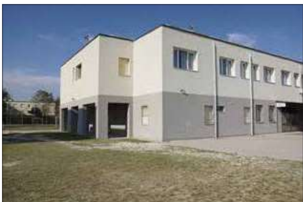
Campo da calcio dietro la struttura - sopralluogo 2023
