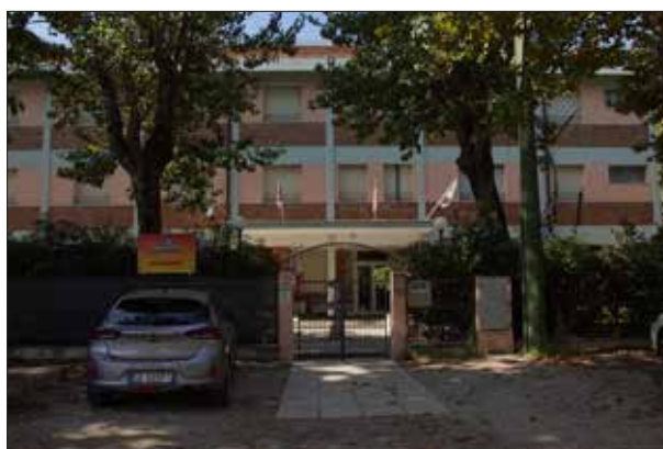
Facciata e ingresso su Via C. Colombo - sopralluogo 2023
