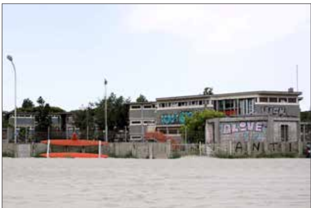
Foto dalla spiaggia, visibili segni di vandalismo diffusi sopralluogo 2023
