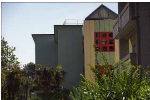
Lato Nord con elemento architettonico verticale aggiunto allo stabile originario - sopralluogo 2023
