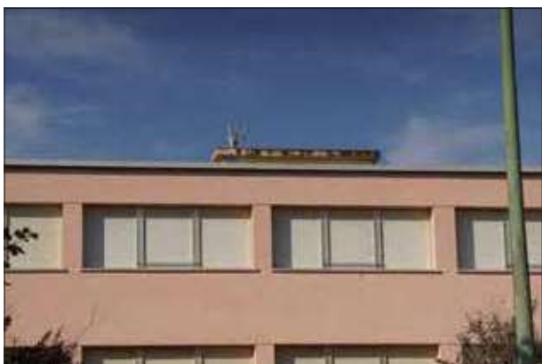
Particolare copertura - sopralluogo 2023
