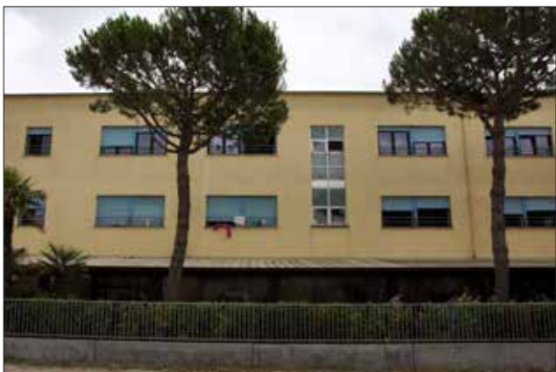
Ingresso su Viale Cabral Nord - sopralluogo 2023
