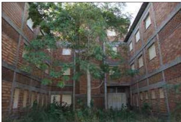
Lato Via Vasco da Gama - sopralluogo 2023
