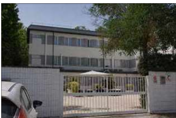
Ingresso su Via C. Colombo - sopralluogo 2023
