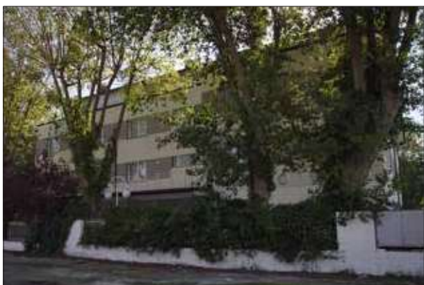
Lato Via C. Colombo - sopralluogo 2023
