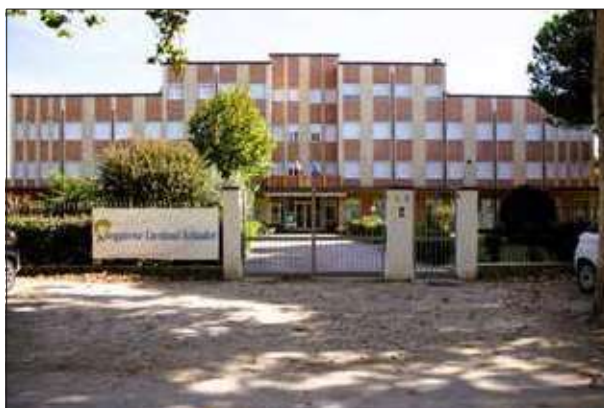
Facciata su Via C. Colombo - sopralluogo 2023
