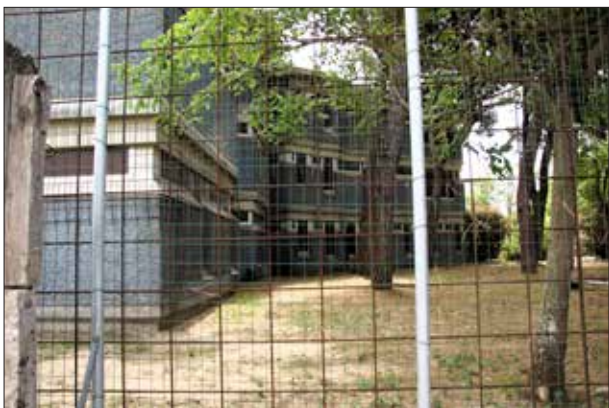
Lato Sud Viale M.A.Pinzon, varco nella recinzione originaria chiuso con una rete - sopralluogo 2023
