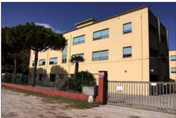
Lato Viale Cabral Sud - sopralluogo 2023
