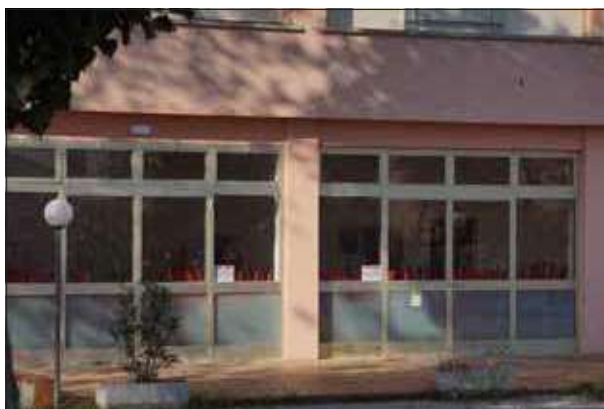
Refettorio al piano terra - sopralluogo 2023
