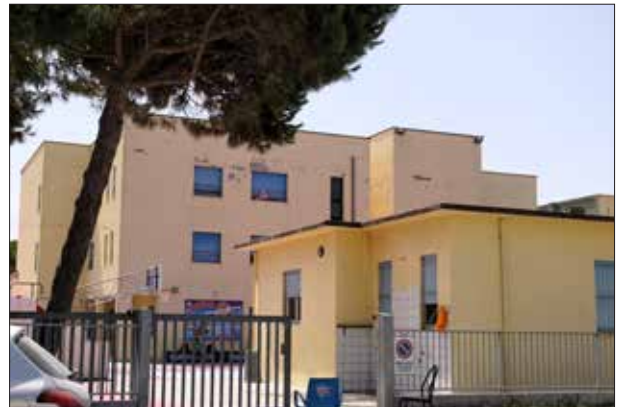
Ingresso su Viale Cabral Nord - sopralluogo 2023
