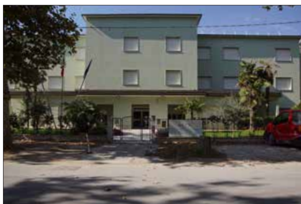
Ingresso su Via C. Colombo - sopralluogo 2023
