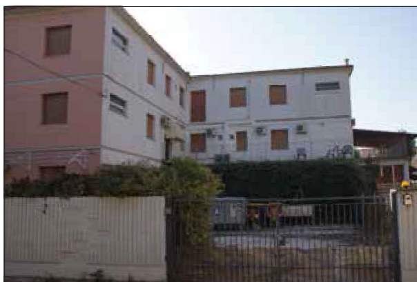
Lato su Viale Vasco da Gama - sopralluogo 2023
