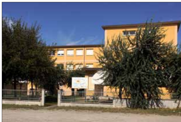
Ingresso pedonale su Viale Cabral - sopralluogo 2023
