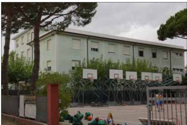
Lato Est - sopralluogo 2023
