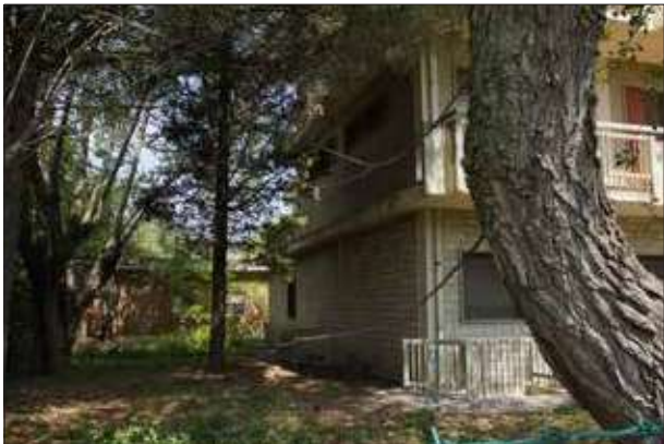
Edificio di servizio nel giardino con danni vandalici - sopr. 2023
