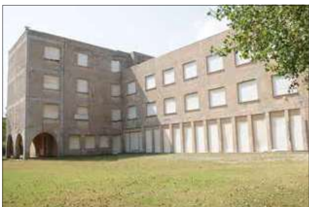
Facciata lato mare - sopralluogo 2023
