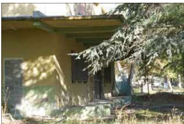
Tettoia lato Via C. Colombo - sopralluogo 2023
