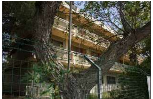
Facciata su Via Pian del Carpine - sopralluogo 2023
