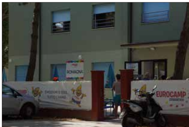
Dettaglio ingresso su Via C. Colombo - sopralluogo 2023
