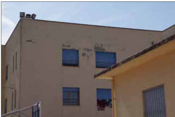
Dettaglio intonaco - spralluogo 2023
