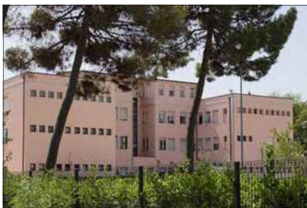
Lato dello stabile fotografato da Via C.Colombo - sopr. 2023
