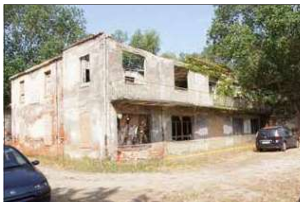
Facciata lato mare - sopralluogo 2023
