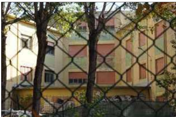
Lato parco di Ponente, visibili segni di vandalismo - sopr. 2023
