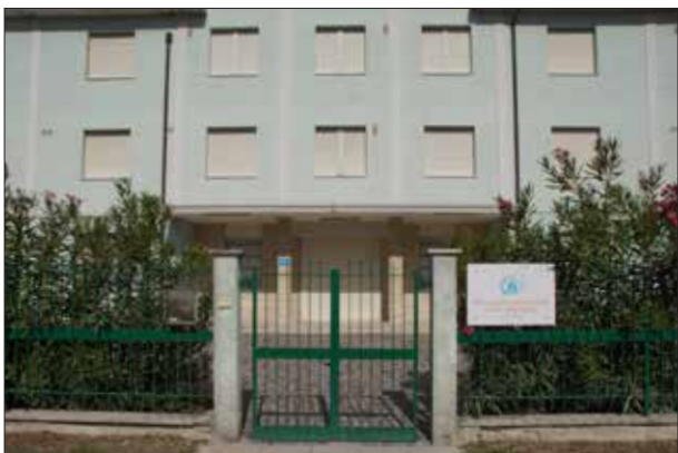
Ingresso pedonale su Viale Cabral - sopralluogo 2023
