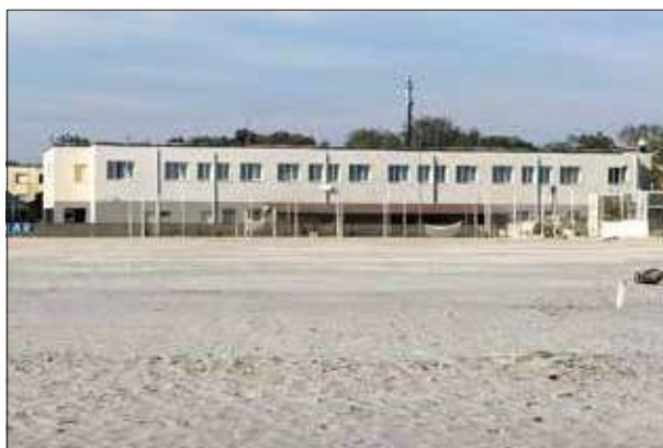
Facciata lato mare - sopralluogo 2023
