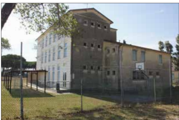
Giardino recintato intorno allo stabile con portico e campo da Basket all'aperto - sopralluogo 2023
