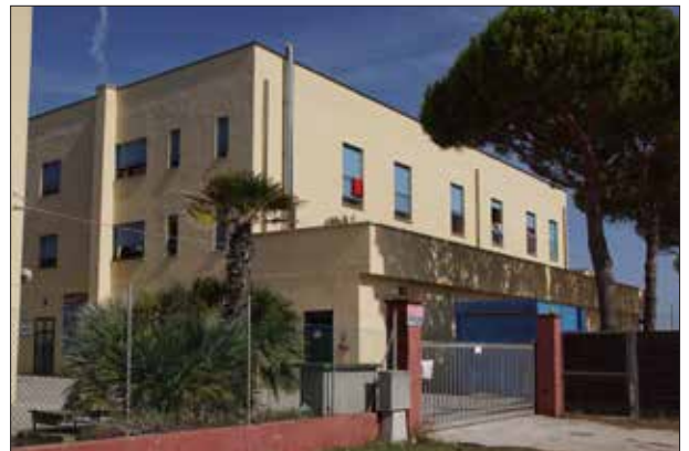
Lato Viale Cabral Sud - sopralluogo 2023
