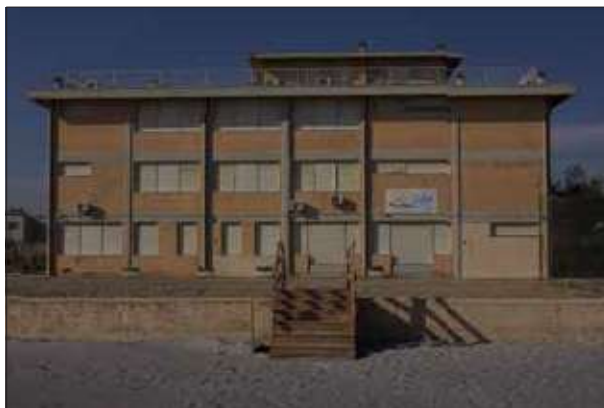
Facciata rivolta verso il mare - sopralluogo 2023
