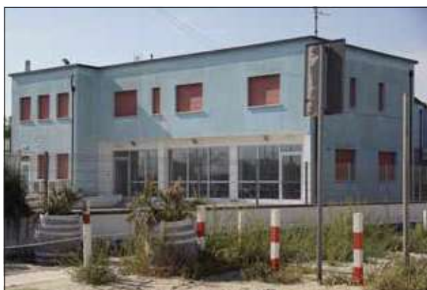
Particolare facciata verso la spiaggia - sopralluogo 2023
