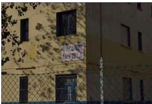
Particolare facciata - sopralluogo 2023
