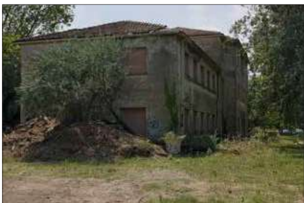
Accatastamento vegetazione a ridosso dello stabile e caduta tegole - sopralluogo 2023
