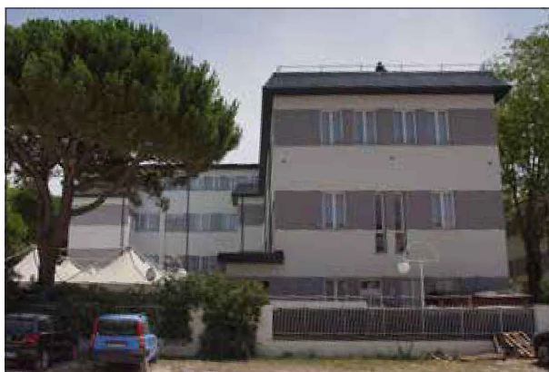
Facciata nord - sopralluogo 2023
