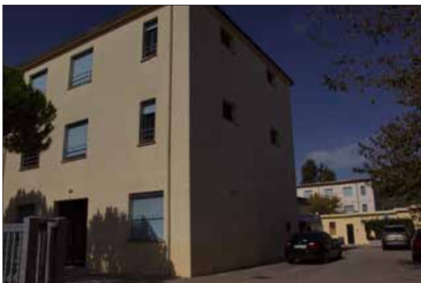
Lato Est e ingresso carrabile - sopralluogo 2023
