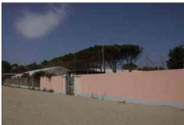
Muro di cinta verso la spiaggia - sopralluogo 2023
