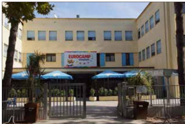
Ingresso su Via C. Colombo - sopralluogo 2023
