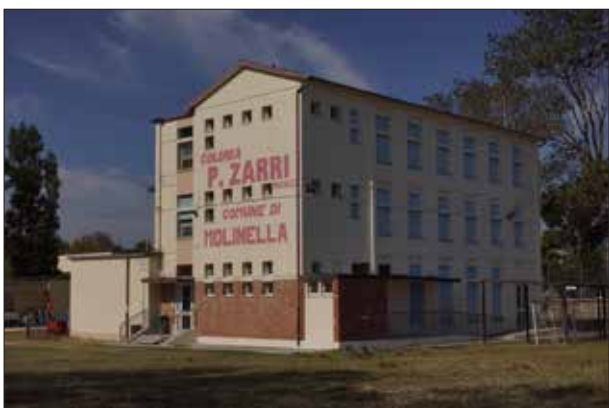
Facciata verso la spiaggia - sopralluogo 2023
