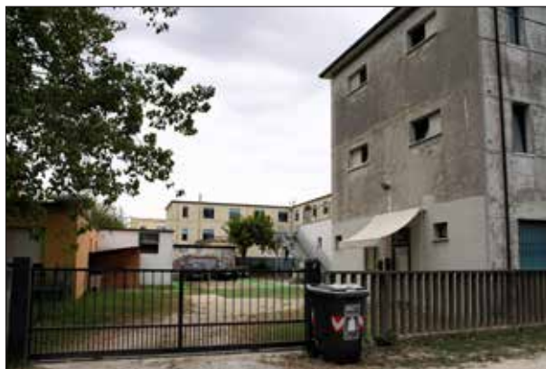
Giardino interno e accesso carrabile su Viale M.A. Pinzon sopralluogo 2023
