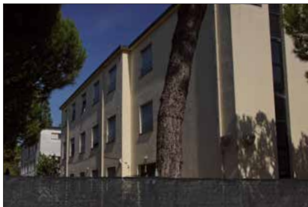
Facciata su Via C. Colombo - sopralluogo 2023
