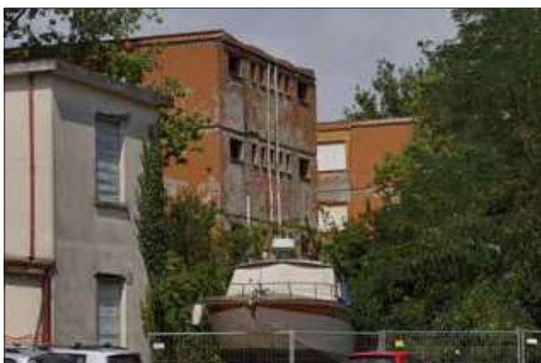
Retro con grondaie crollate e muratura esposta - sopr. 2023
