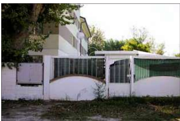
Dettaglio ingresso pedonale - sopralluogo 2023
