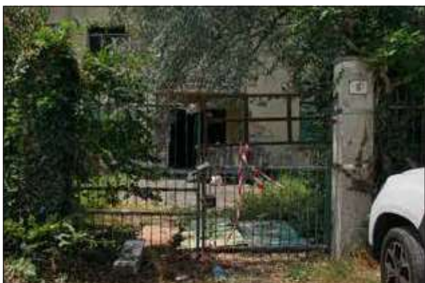
Ingresso con rifiuti e vegetazione non mantenuta - sopr. 2023
