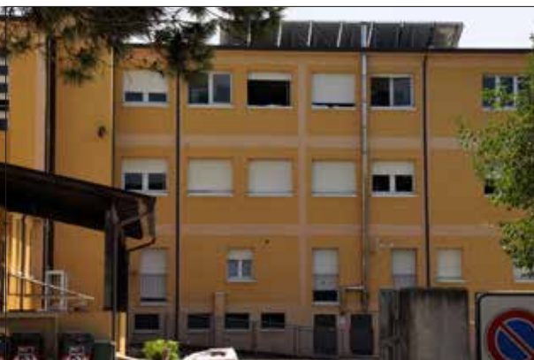
Particolare lato Nord con pannelli sul tetto - sopr. 2023
