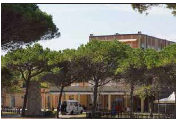
Stabile lato giardino verso la spiaggia - sopralluogo 2023
