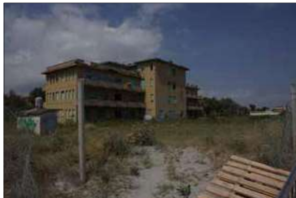
Lato spiaggia recinzione aperta - sopralluogo 2023
