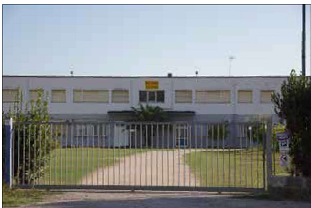
Ingresso su Via C. Colombo - sopralluogo 2023
