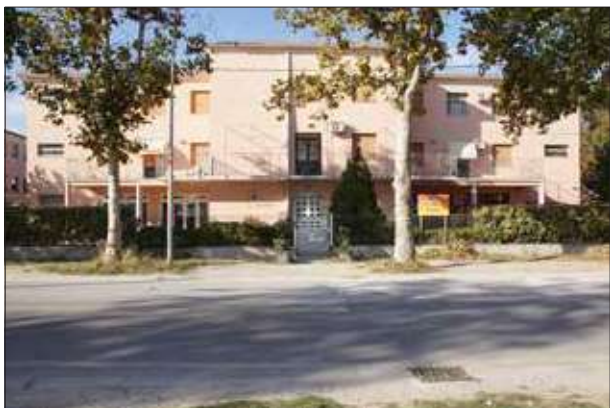
Facciata su Via C. Colombo - sopralluogo 2023
