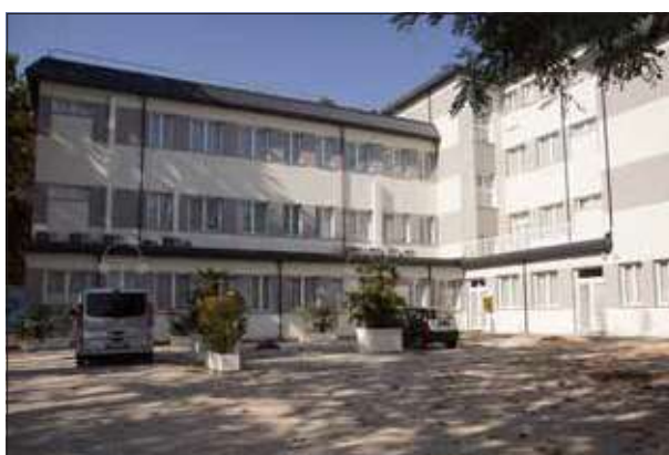
Spazi pertinenza interna - sopralluogo 2023
