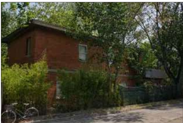
Stabile di servizio nella pertinenza su Via Vasco de Balboa sopralluogo 2023
