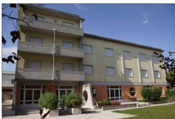
Facciata su Via C. Colombo - sopralluogo 2023
