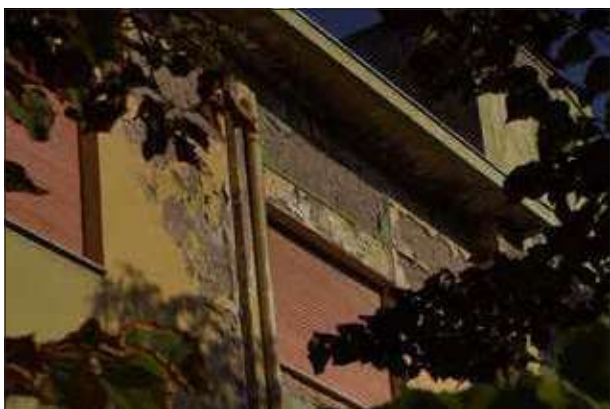
Particolare soletta del tetto - sopralluogo 2023
