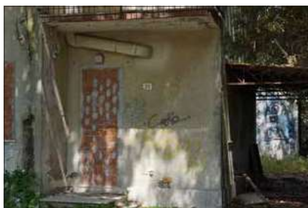
Aperture al piano terra murate - sopralluogo 2023
