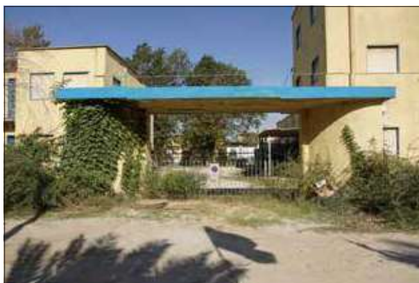
Ingresso su Viale F. Magellano - sopralluogo 2023
