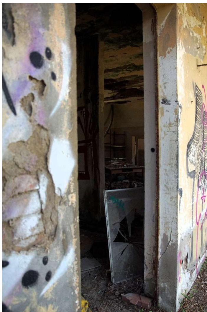
Figura 26 Colonia Leone XII, sopralluogo luglio 2023
