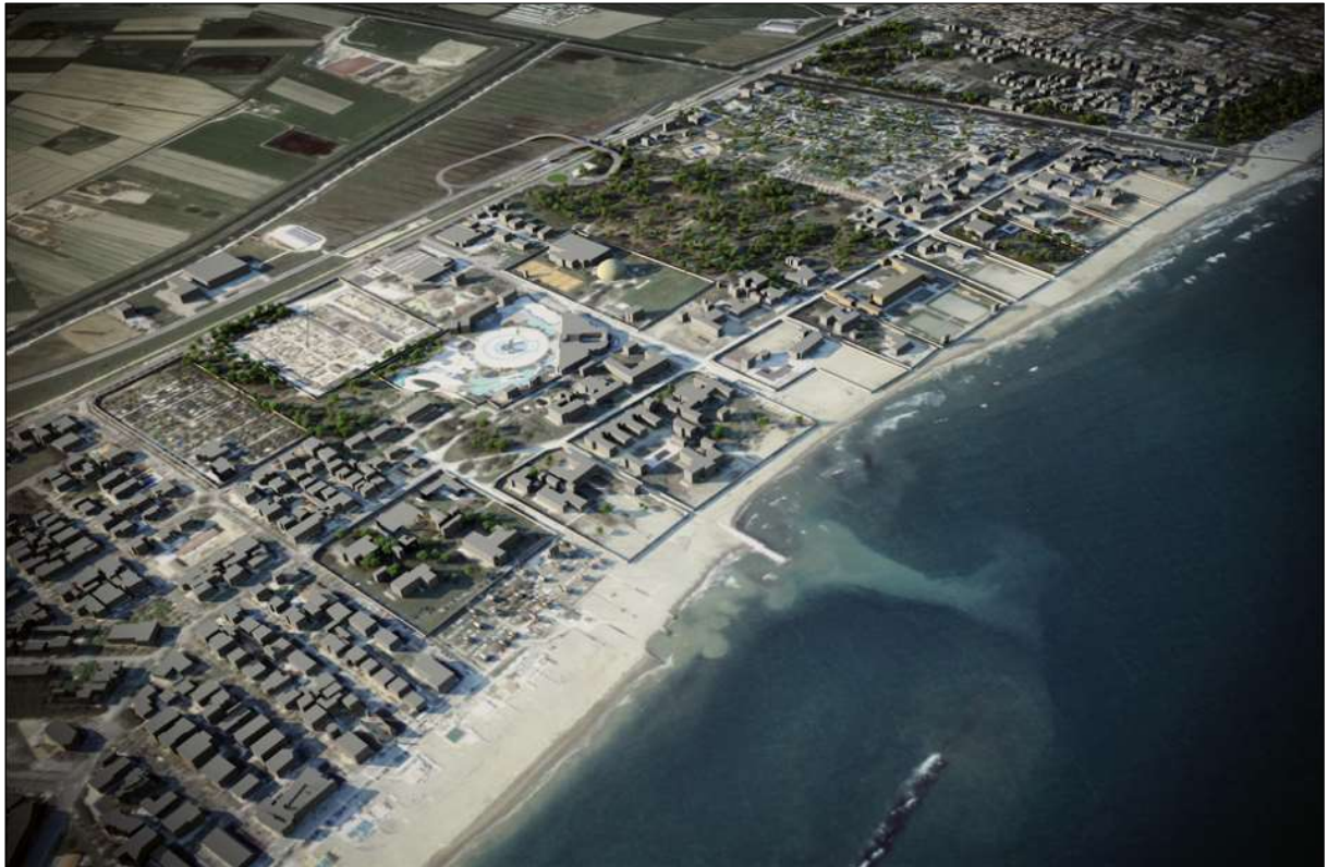
Figura 9 Stato di fatto dell'area di intervento, Mario Cucinella Architects, 2010
