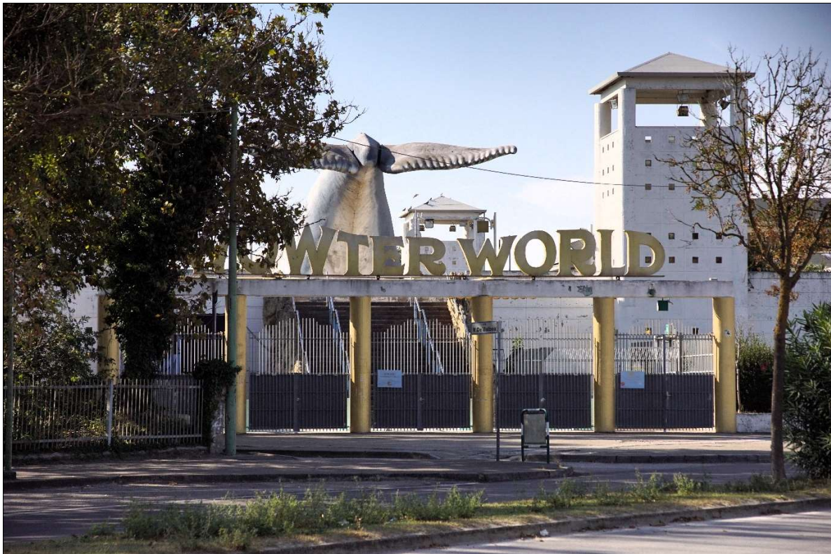
Figura 19 Ingresso parco acquatico, a fianco di colonie abbandonate e in forte stato di degrado, sopralluogo luglio 2023
