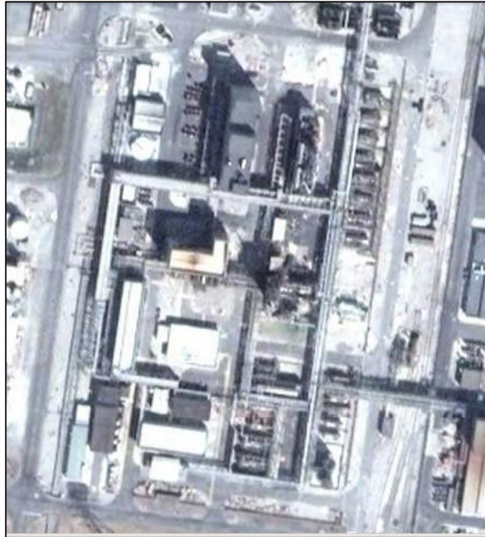
Figura 8 Vista dall'alto della porzione considerata di impianto
