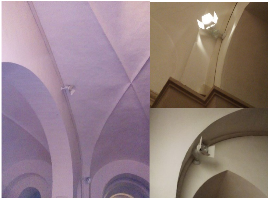
Figura 28 -10 In senso orario: per l'illuminazione dell'affresco, particolare di un corpo usato per l'affresco da due angolazioni, acceso o spento
