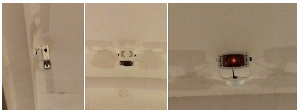
Figura 26 - Corpo illuminante centrale nella zona dell'altare da varie angolazioni; si noti il bagliore residuo nella lampada allo spegnimento
