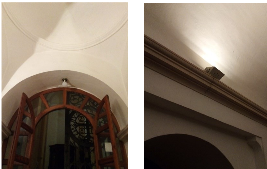
Figura 61 - Sinistra: luce ad uno dei due ingressi della cripta. Destra: questo tipo di proiettore è presente quasi ovunque nella cripta per l'illuminazione indiretta delle volte
