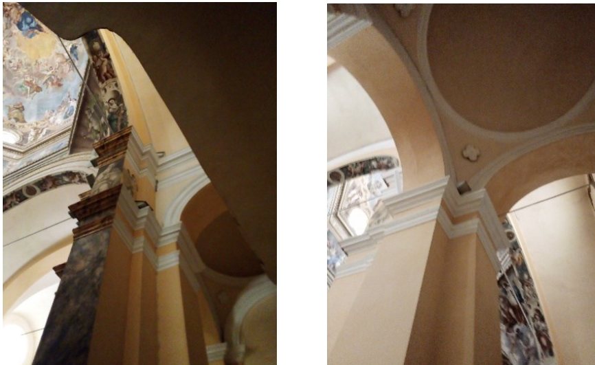
Figura 15 - a sinistra: nella zona della cantoria si ha illuminazione indiretta dai capitelli bassi, mentre diretta verso la cantoria con l'organo (non l'altra) dal cornicione con un altro proiettore, a destra: vicino alla cantoria si ha illuminazione indiretta dal capitello
