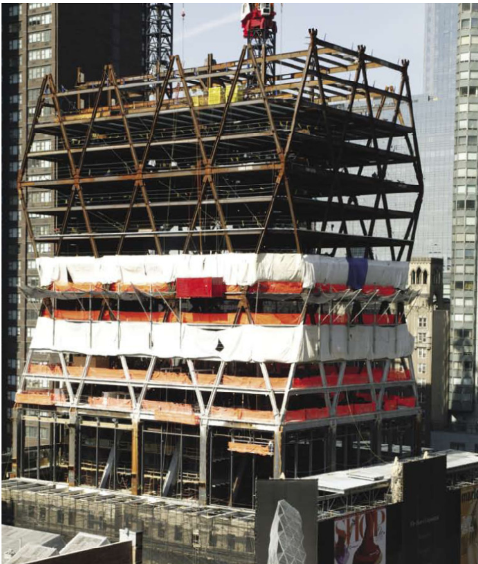
Fig. 1.62 Struttura DiaGrid in costruzione, Hearst Tower, NY
