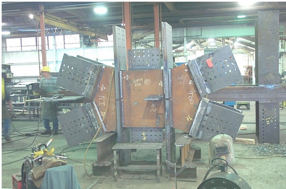
Fig. 1.63 Nodo di struttura DiaGrid in fabbricazione
