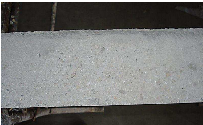
Figura 4.9 La superficie di calcestruzzo pronta per l'applicazione dei rinforzi.
