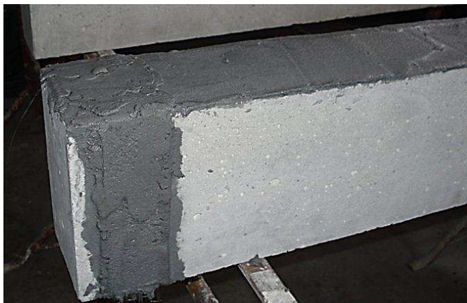
Figura 4.10 Rinforzo a flessione e U a taglio installati.
