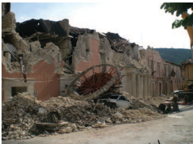
Fig. 10 - Immagini dei danni provocati dal terremoto
