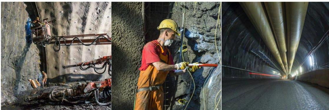
Figura 1. 12 Perforazione-Caricamento e brillamento-Ventilazione (www.bbt-se.com)
