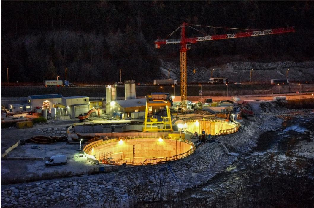
Figura 1. 16 Scavo di due dei quattro pozzi sotto il fiume Isarco ([www.bbt-se.com](http://www.bbt-se.com))
