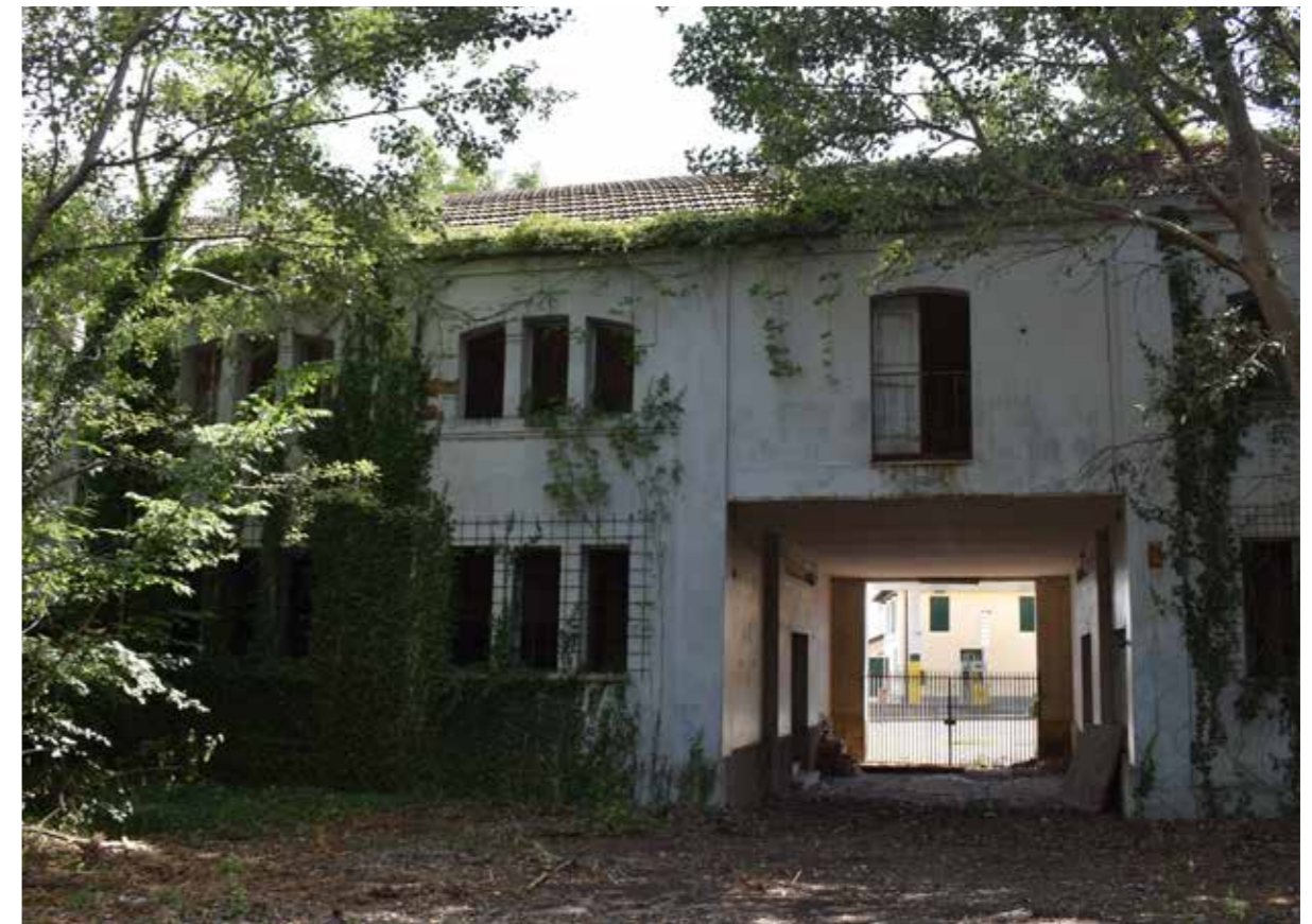
Fig. 3: Edificio "A", corte interna, dettaglio accesso all'area Rilievo fotografico realizzato dagli autori
