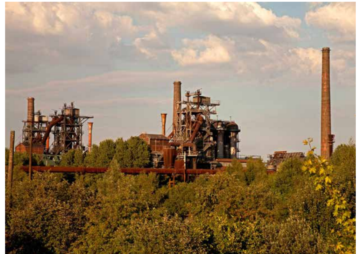
Fig. 2: Vista dell'impianto Immagini della fotografa Jutta Riegel
