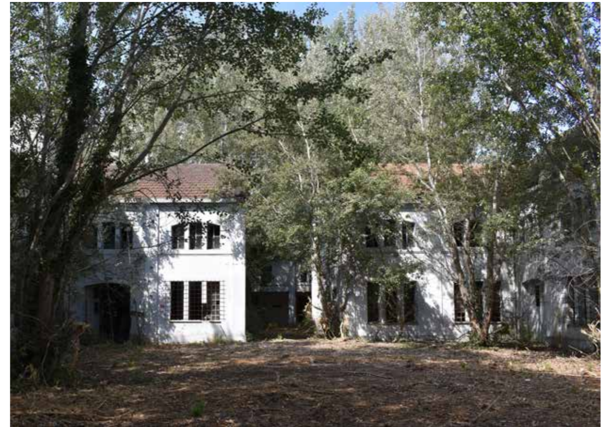
Fig. 2: Edificio "A", corte interna Rilievo fotografico realizzato dagli autori
