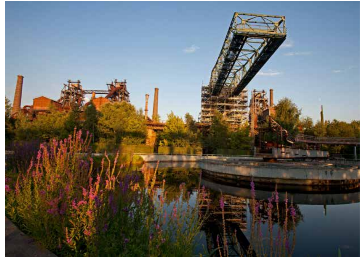
Fig. 1: Vista dell'impianto Immagini della fotografa Jutta Riegel
