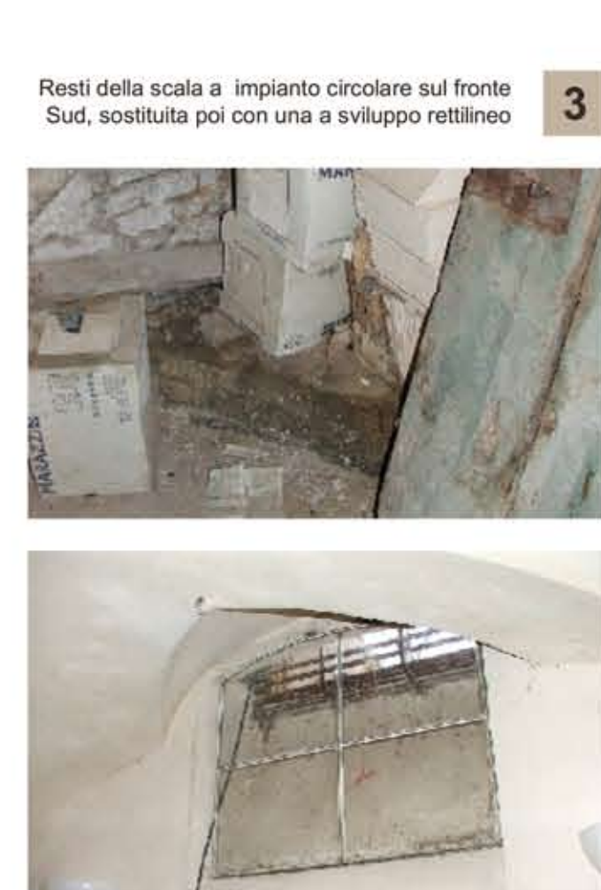
3 Resti della scala a impianto circolare sul fronte Sud, sostituita poi con una a sviluppo rettilineo
