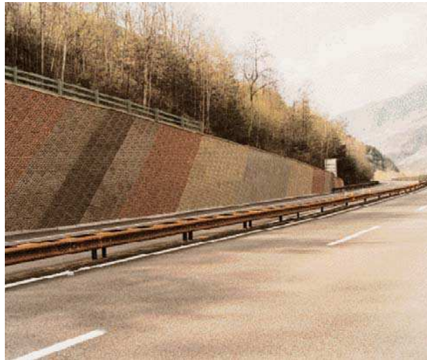
Fig. 1.5 - Muratura di protezione
