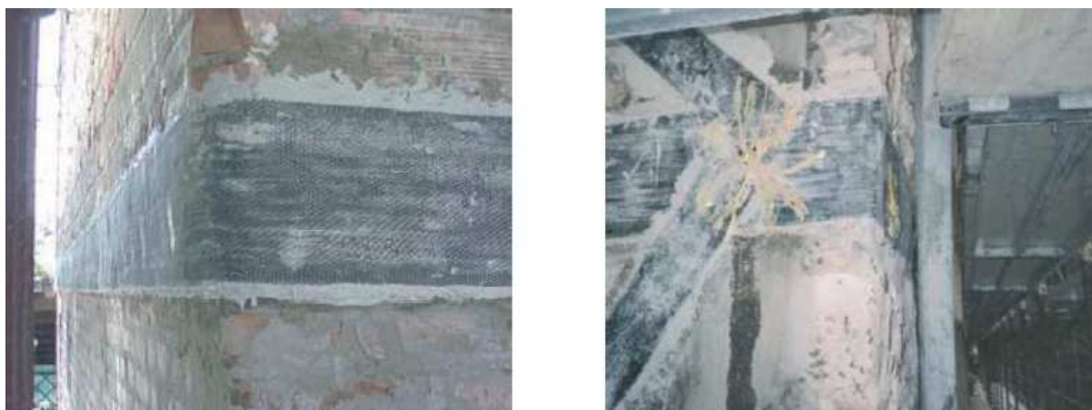
Fig. 6.19 - Interventi di fasciatura e applicazione di fibre in zona tesa
