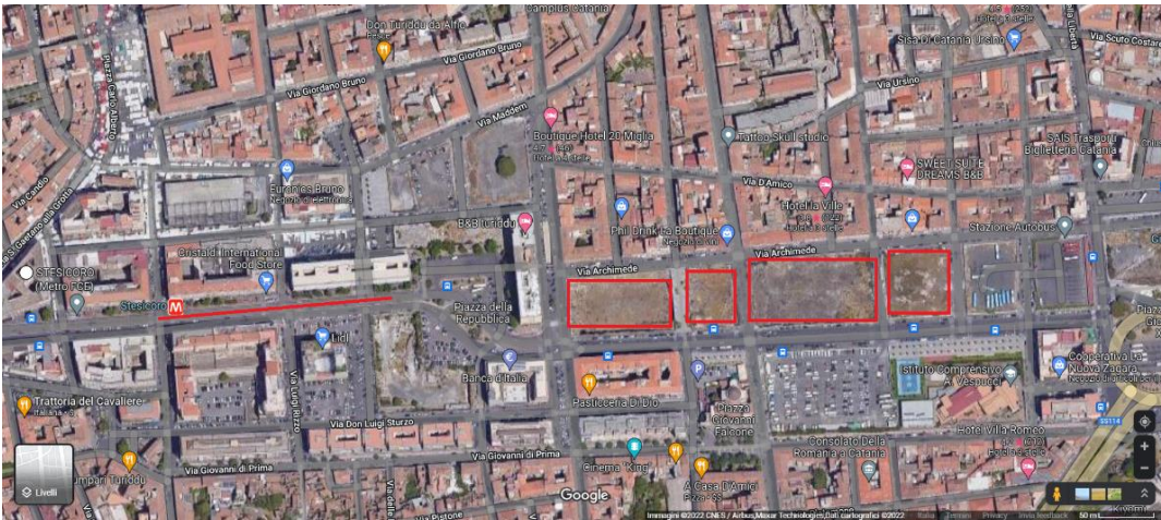
Fig. 6. Le attuali “voragini” in prossimità della stazione, Vecchio San Berillo, Catania. https://www.google.it/maps/@37.508283,15.0959662,683m/data=!3m1!1e3
