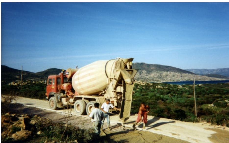
Fig. 2.2 Fase di realizzazione del massetto in calcestruzzo della pavimentazione
