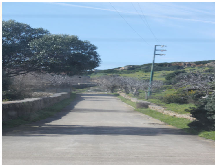
Fig. 2.12: Restringimento della carreggiata
