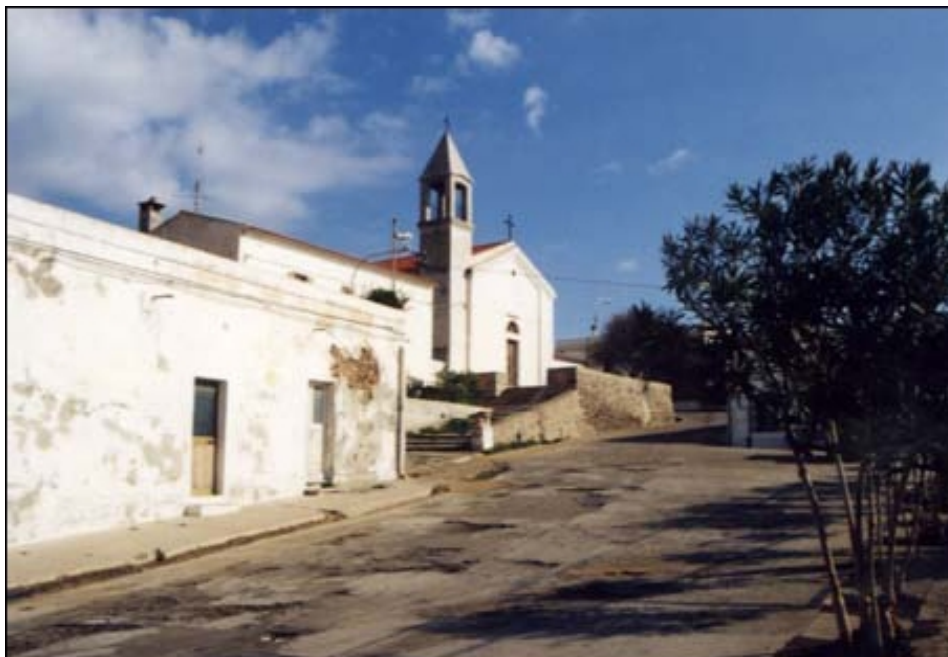
Fig. 2.16 : fenomeni di degrado presso Cala d'Oliva
