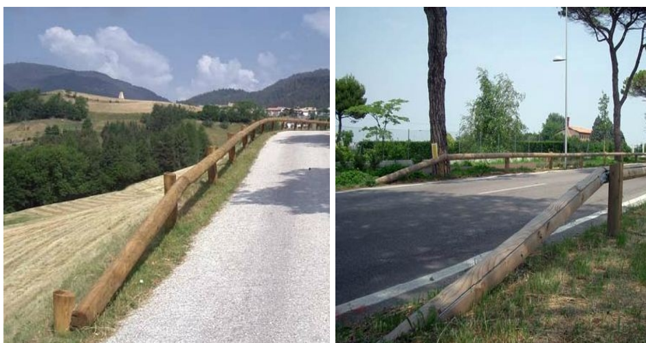
Figura 4.17 e 4.18: Parti terminali delle barriere metalwood infisse nel terreno
