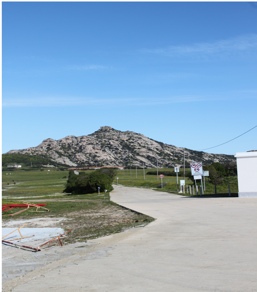
Figura 2.3: collegamento stradale a Fornelli, con evidente necessità di manutenzione.
