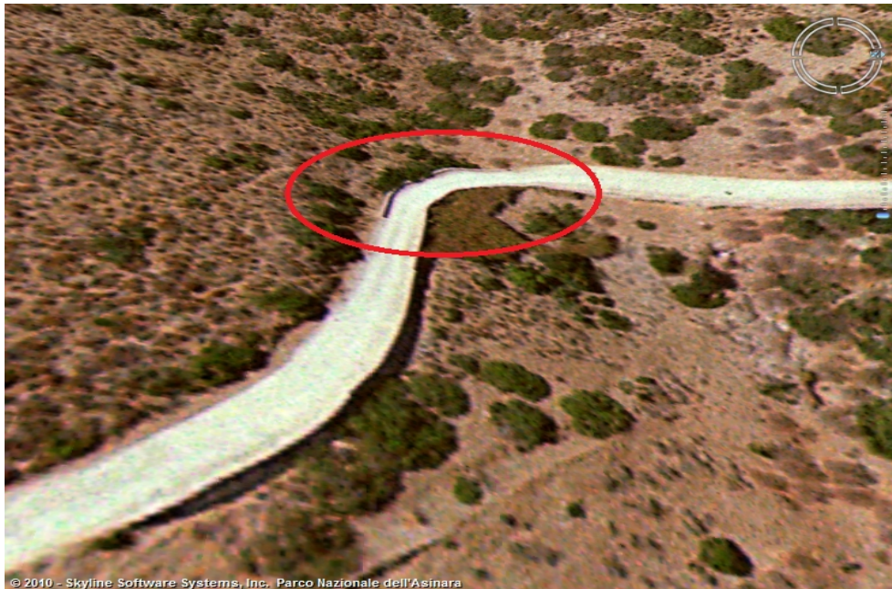
Fig. 2.11: tratto dove maggiormente si è riscontrata la presenza di detriti in carreggiata
