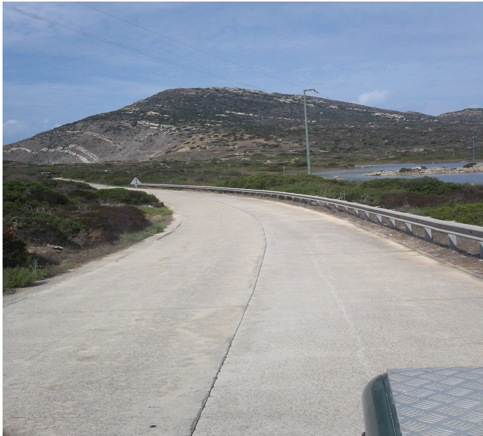
Fig. 2.18: presenza di barriere in acciaio che crea impatto visivo
