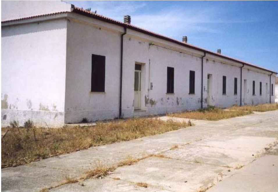
Fig. 2.14 : crescita vegetale tra blocchi di calcestruzzo
