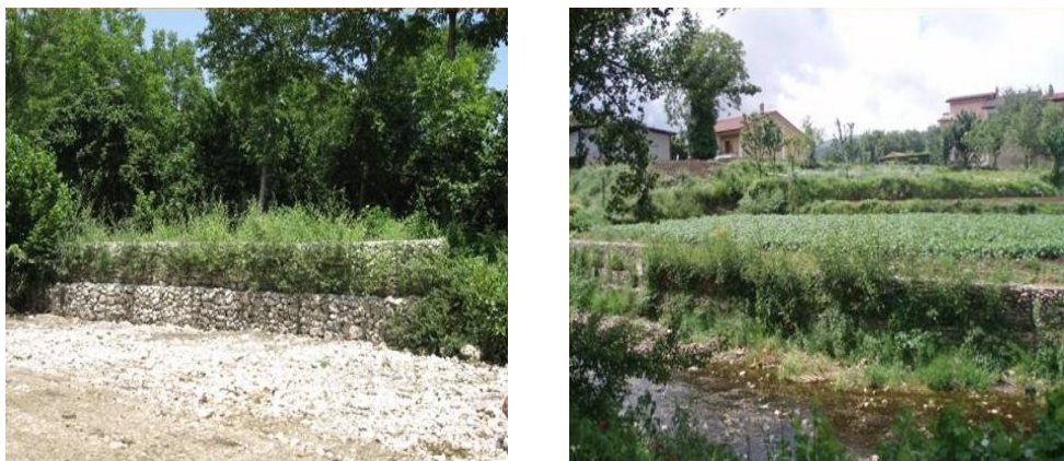
Fig. 3.16a e 3.16b: evoluzione della crescita vegetativa su un muro a gabbioni
