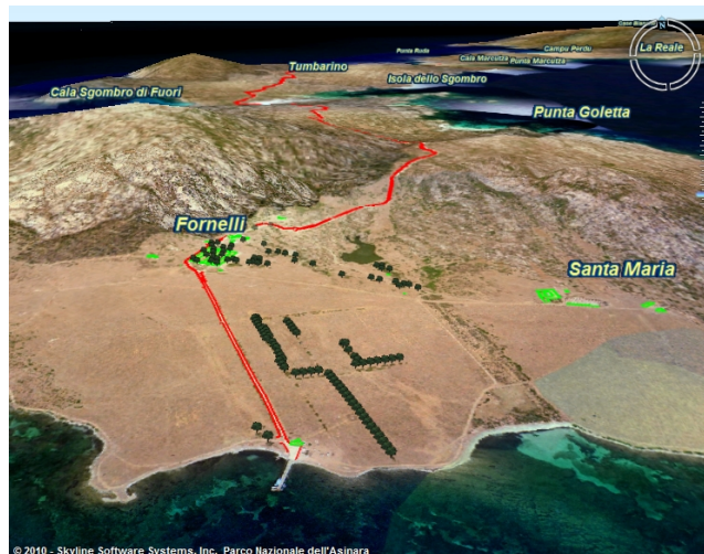
Fig. 1.21: Tratto iniziale della infrastruttura
