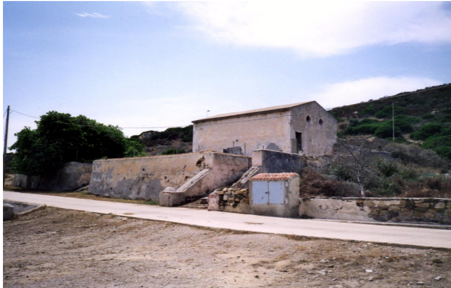
Fig.2.5 : Crollo muri perimetrali
