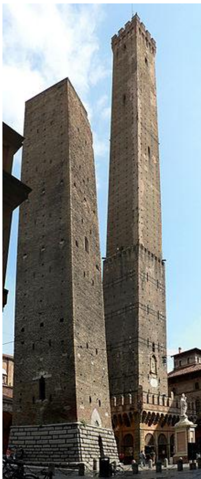
Figura 5.49. Le due torri simbolo della città di Bologna: la Torre Garisenda e la Torre degli Asinelli.
