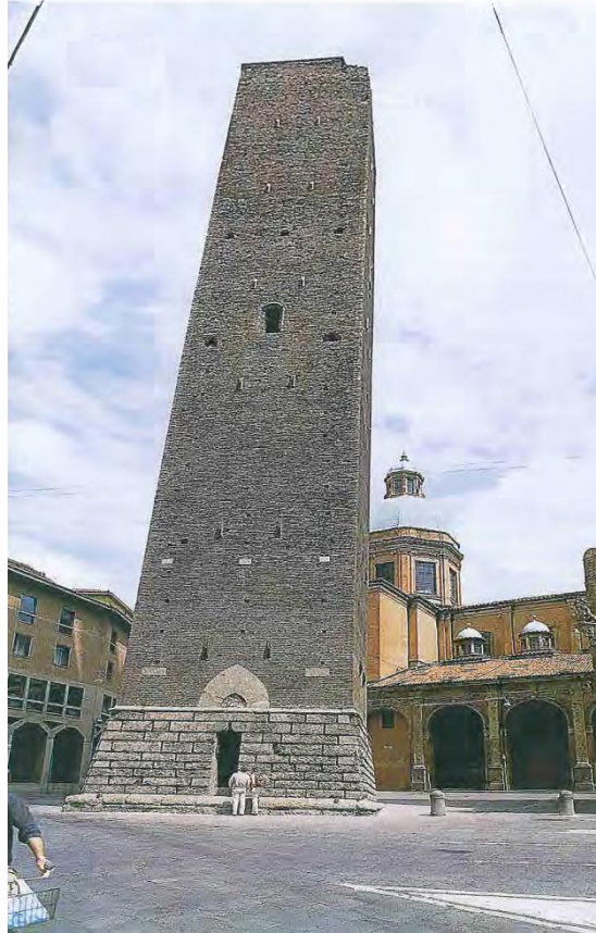
Figura 5.66. La Torre Garisenda a Bologna, nel 2000 a restauro ultimato.
