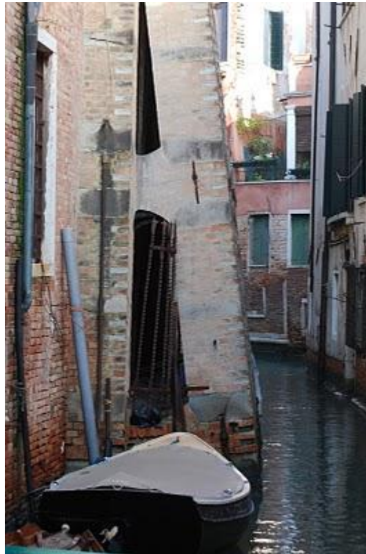
Figura 5.24. Contrafforti realizzati durante l'intervento di consolidamento delle fondazioni del 1903-1905 (Marchi, 2008).
