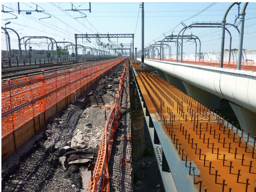
Figura 1.8 – Vista dell'impalcato dove verrà disposto il quarto binario
