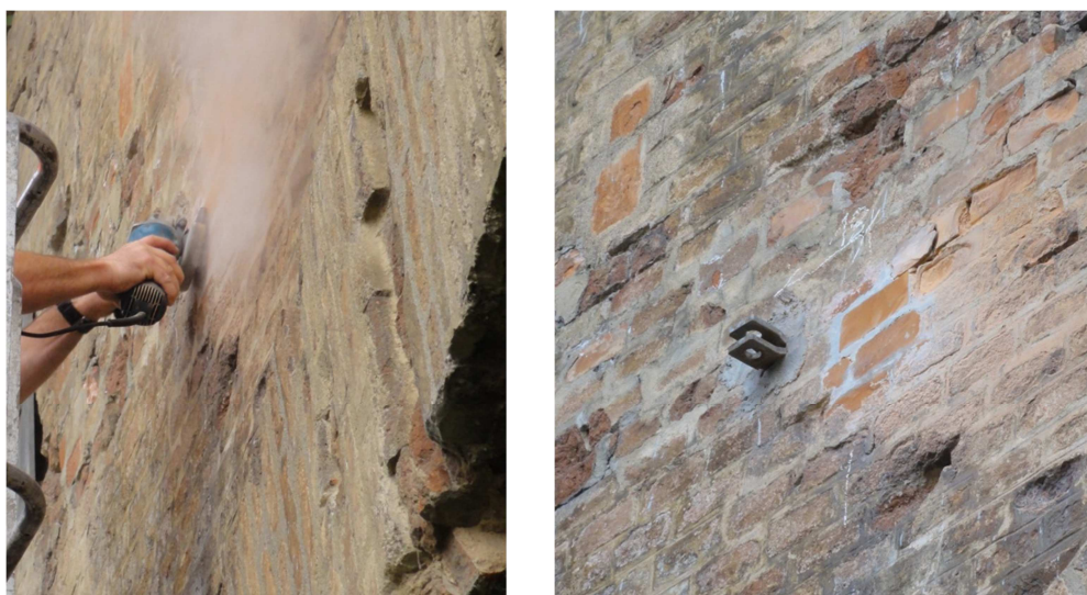
Figura 2.18 – Smerigliatura della superficie soggetta alla prova
