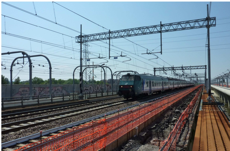
Figura 5.22 – Disposizione dei binari sul Ponte di attraversamento del fiume Reno
