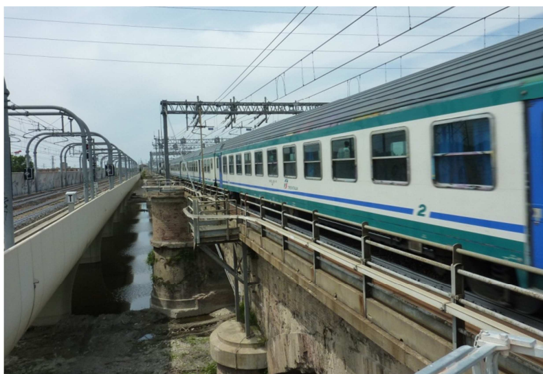
Figura 8.3- Transito di un convoglio ferroviario sul binario più a monte
