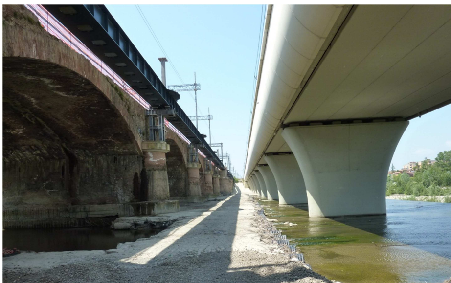
Figura 5.2 – Ponte di nuova costruzione adiacente al ponte oggetto di valutazione
