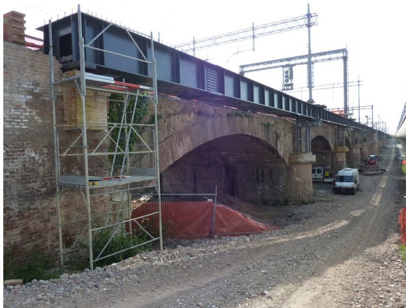
Figura 1.9 – Ponte lato valle, vista della trave cassone
