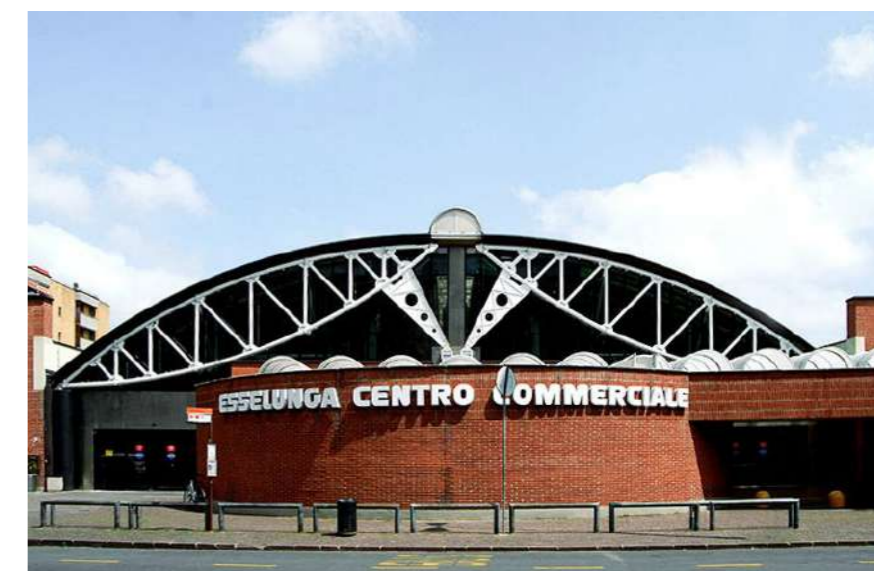
Figura 51. Ingresso principale del Centro Commerciale Le Torri, oggi rinominato Esselunga Centro Commerciale.
