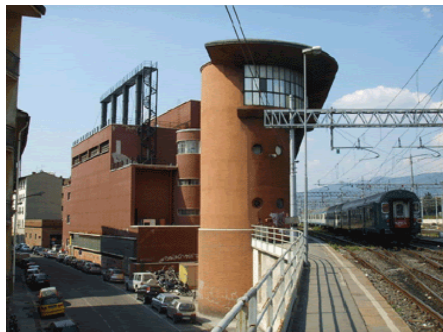
Centrale Termica di SMN, Angiolo Mazzoni.
