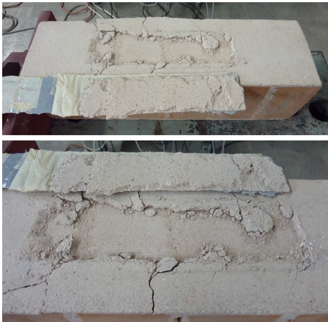
Figura 6.172 – Particolare della modalità di distacco del rinforzo (prova M3B1c).
