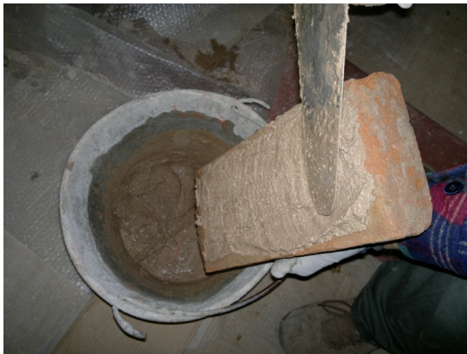
Figura 3.8 - Fase di applicazione della malta sulla faccia del mattone ancora da posizionare.
