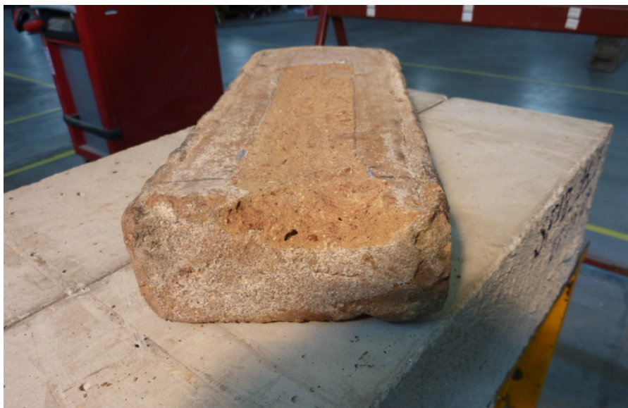
Figura 6.131 - Particolare: distacco di una porzione di mattone sulla parte anteriore.
