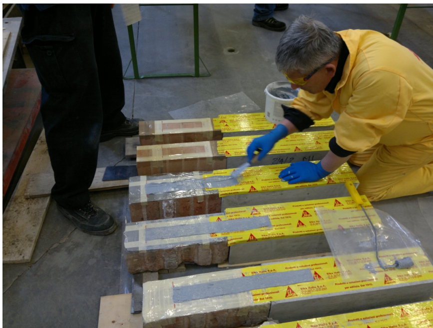
Figura 3.18 - Fase di stesura della resina sul sottofondo.
