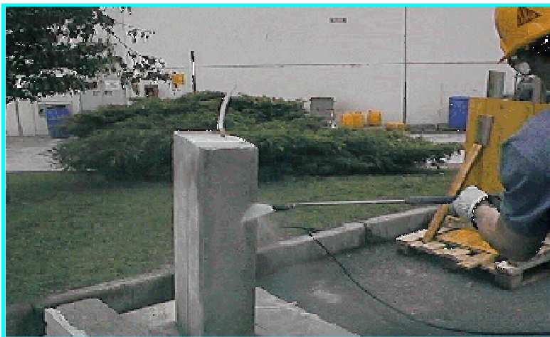
Figura 1.16 - Esempio di idrodemolizione.
