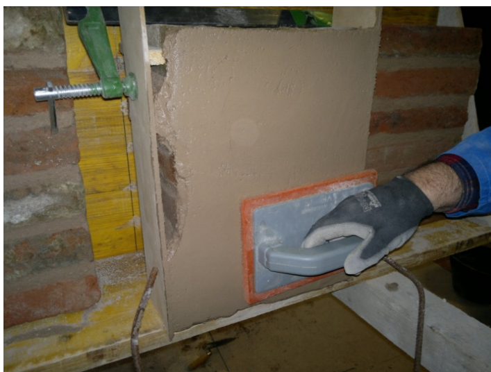
Figura 3.11 - Fase di realizzazione della rasatura superficiale.
