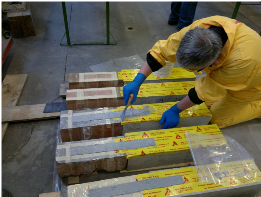
Figura 3.21 - Pulitura degli eccessi di resina ai lati del tessuto.
