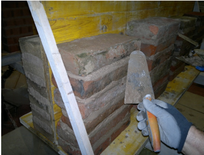
Figura 3.10 - Collocazione del mattone e recupero della malta eccedente.
