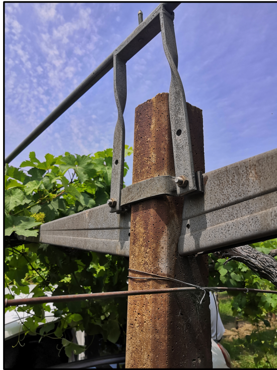
Figura 14. Azienda DZ. Supporti mobili del sistema GDC imperniati ai pali
