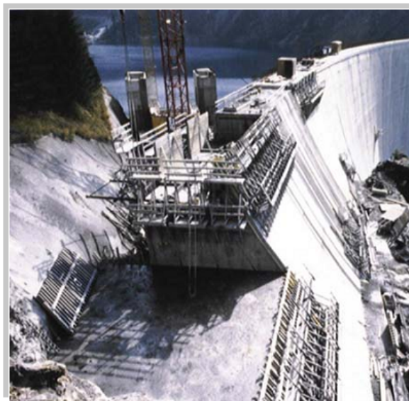
Figura2.6: Diga di Luzzone in Svizzera
