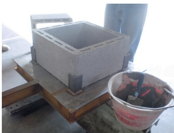
Figura7.5: Inizio costruzione del pilastro
