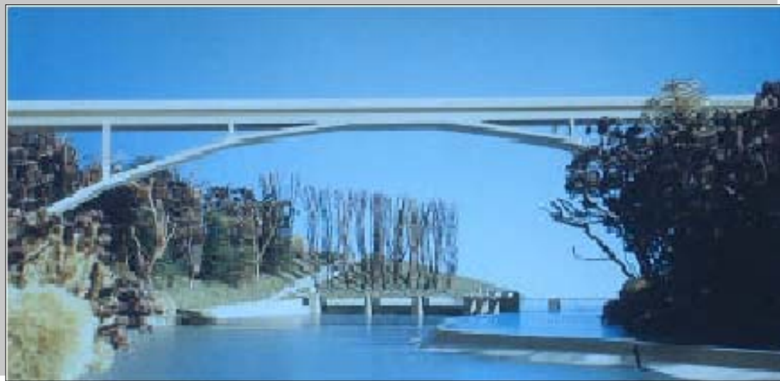
Figura2.4: Ponte di Siggenthal in Svizzera con sensori annegati nel calcestruzzo[19]
