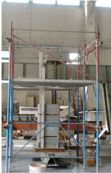
Figura7.9: Realizzazione del ponteggio intorno alla struttura
