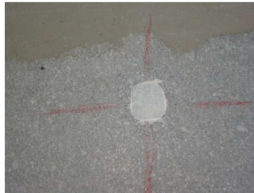
Fig.8.13 [Punto di misura del LVDT]
