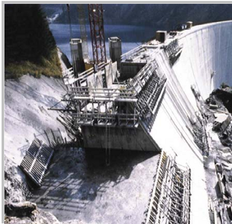
Fig.6.4 [diga di Luzzone]
