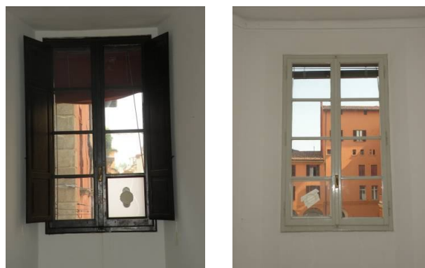
Figura 7.105: Infisso "tipo" lato via IV Novembre ed infisso "tipo" lato cortile.
