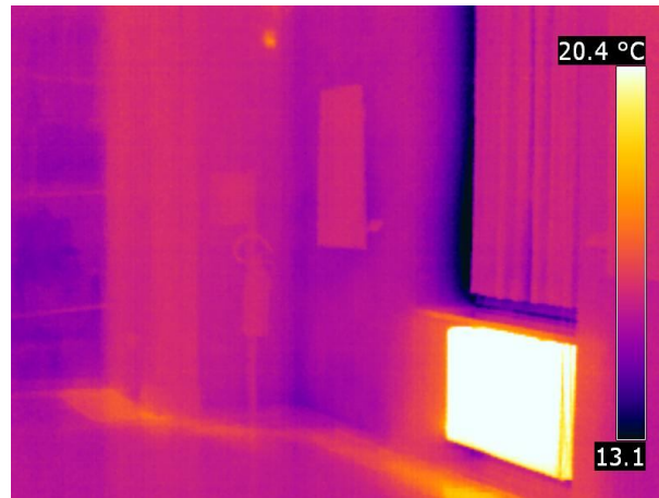
Figura 7.42: Termogramma del condotto degli impianti a pavimento nella Sala dei Primitivi.
