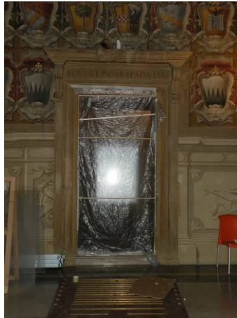
Figura 7.61: Rafforzamento della chiusura realizzata nell'apertura presente nella parete situata a sud.
