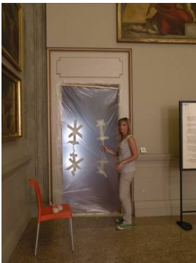
Figura 7.77: Apertura sigillata tra Sala n°20 e Sala Urbana.
