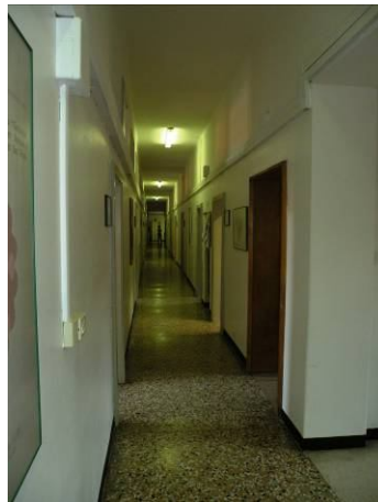
Figura 7.11: Scorcio del corridoio del secondo trapiano di Palazzo D'Accursio.
