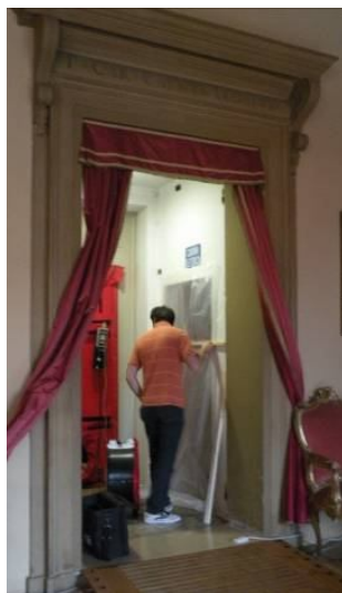
Figura 7.70: Realizzazione della chiusura del corridoio di emergenza adiacente alla ventola.
