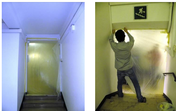
Figura 7.12: Chiusure realizzate agli estremi del corridoio in esame.
