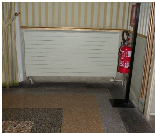
Figura 7.104: Condotto degli impianti nel pavimento in marmo della Sala n°19.
