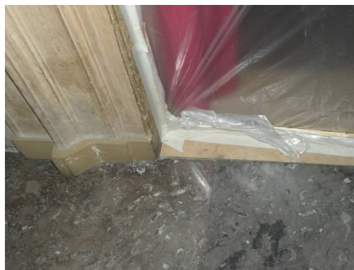
Figura 7.59: Fissaggio dei teli di nylon al pavimento mediante nastro adesivo.
