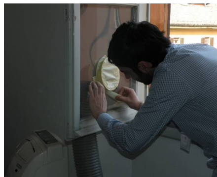
Figura 7.16: Chiusura delle prese d'aria nei vetri degli infissi.
