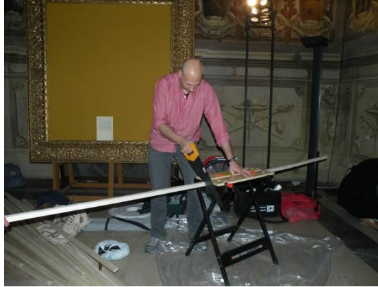
Figura 7.27: Preparazione delle aste in legno utilizzate per effettuare le chiusure.
