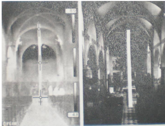
Figura 2.5: Mappa delle temperature presenti all'interno di una chiesa e striscia di carta installata per rilevare la temperatura dell'aria.
