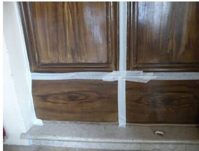
Figura 7.110: Particolare della sigillatura della porta in legno della Sala Vidoniana.
