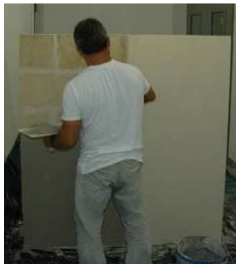
Figura 6.5: Applicazione dello strato di intonaco di calce sul fronte del W1.
