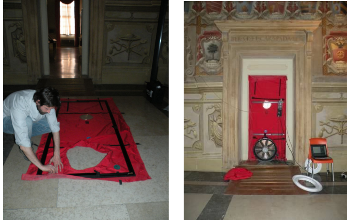
Figura 7.24: Installazione della strumentazione del Blower Door nella Sala Urbana.
