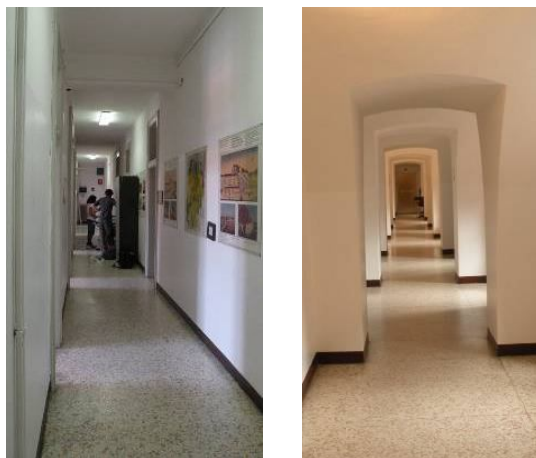
Figura 7.50: Tronchi del corridoio del primo piano di Palazzo D'Accursio.
