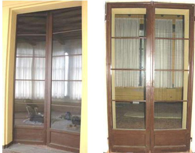
Figura 4.3: Infisso tipo sulla loggia frontale ed infisso tipo sulla loggia laterale
