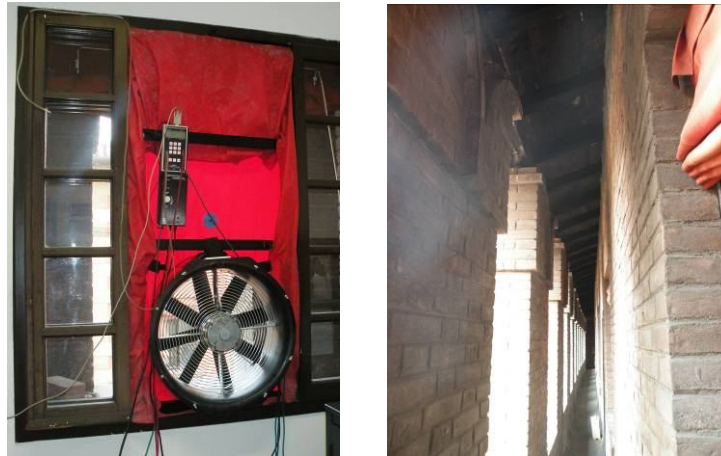
Figura 7.13: Strumentazione installata nell'infisso W3F94 e camminamento di ronda presente all'esterno di tale infisso.
