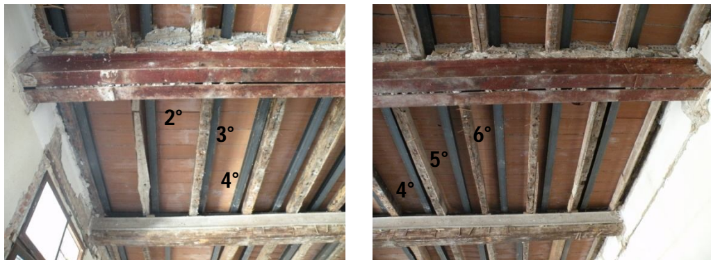
Figura 5.30: Solaio del soffitto della GF7+GF8+GF9.
