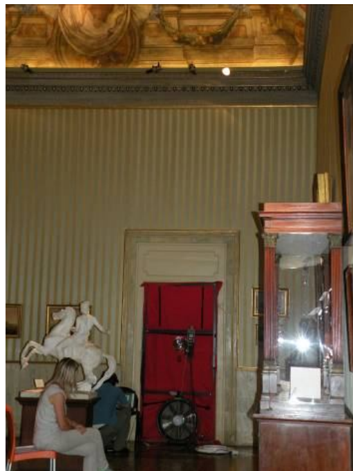
Figura 7.79: Ventilatore installato nella porta tra la Sala n°19 e la Sala n°20.
