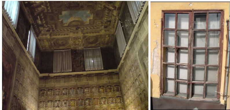
Figura 7.109: Infissi della Sala Urbana visti, rispettivamente, dall'interno e dall'esterno della stessa.
