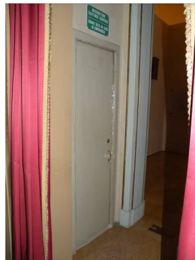
Figura 7.71: Realizzazione della chiusura del vano tra la Sala Vidoniana e la Sala dei Primitivi.
