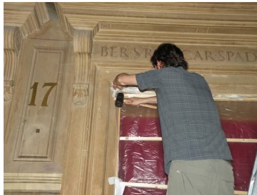
Figura 7.58: Montaggio dei telai in legno all'interno delle aperture.
