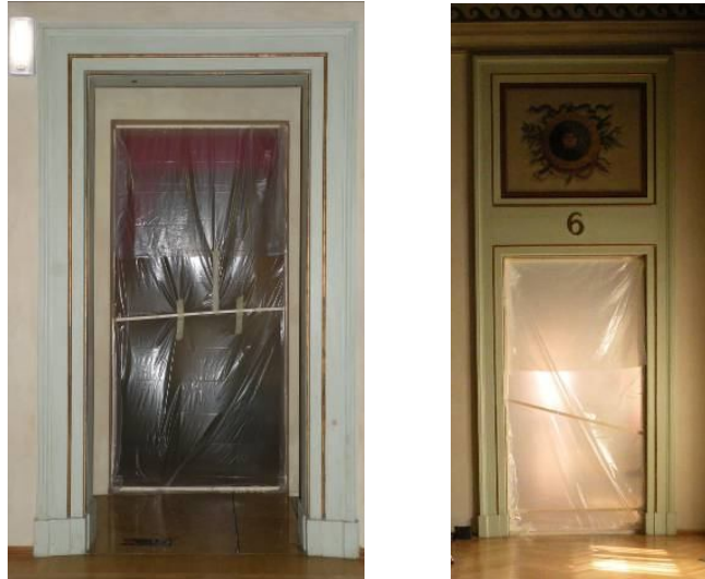
Figura 7.34: Sigillatura delle chiusure, mediante aste in legno, teli in nylon e nastro adesivo, delle aperture presenti, rispettivamente, nella parete sud della Sala dei Primitivi e nella parete nord della Sala del '500.
