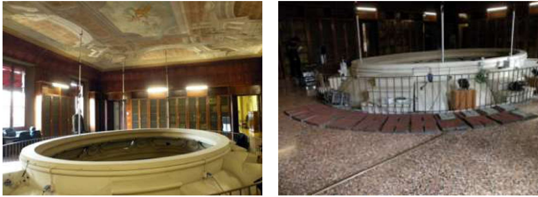
Figura 3.10: Sala Ovale di Palazzo Malvezzi e relativa prova di carico con piastra.
