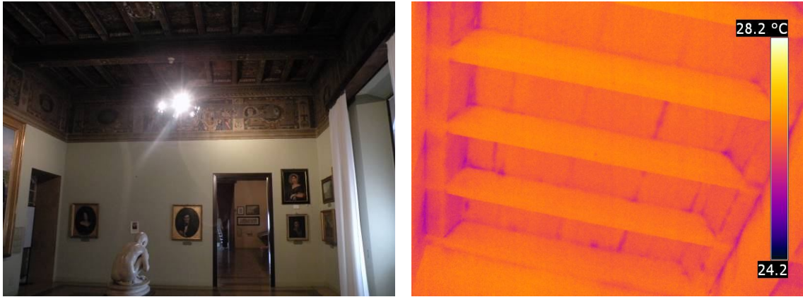
Figura 7.47: Vista generale e soffitto a cassettoni della Sala n°18.
