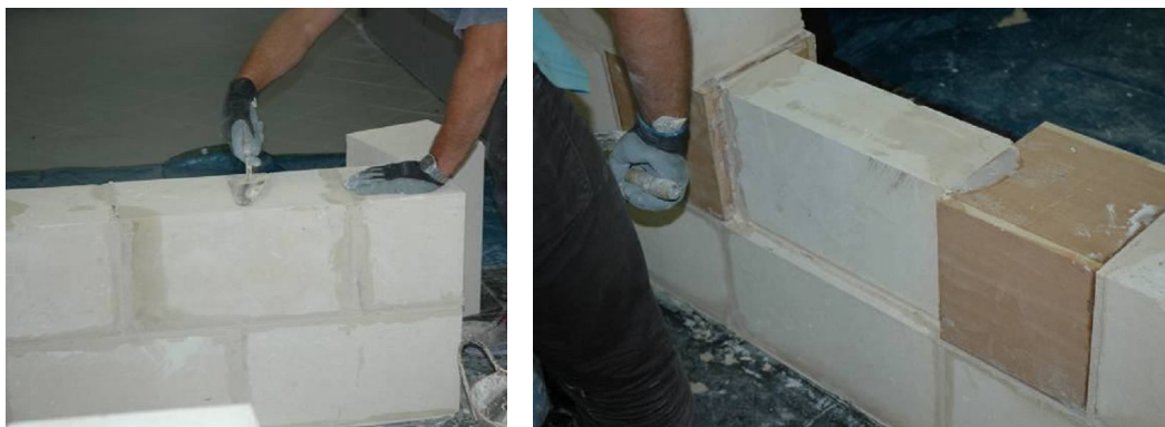
Figura 6.3: Realizzazione, rispettivamente, del muretto W1 (struttura di riferimento) e del muretto W2 (struttura contenente difetti).
