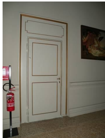
Figura 7.78: Porta in legno chiusa e sigillata.
