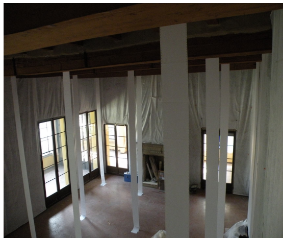
Figura 4.16: Vista dall'alto delle strisce di carta installate nel salone 1F9.
