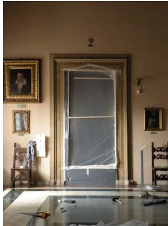
Figura 7.92: Passaggio presente tra la Sala dei Cavalleggeri e Sala degli Svizzeri.
