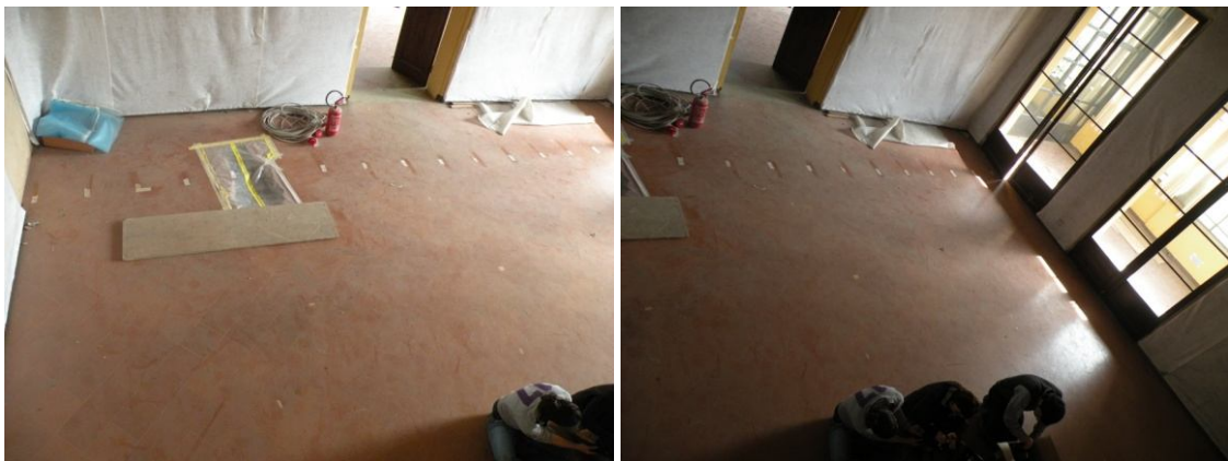
Figura 5.5: Traccia della linea radar nel pavimento del salone 1F9.
