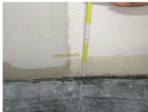
Figura 6.30: Risalita della soluzione di acqua e cloruro di sodio sul muretto W1 dopo 5h dall'immersione.
