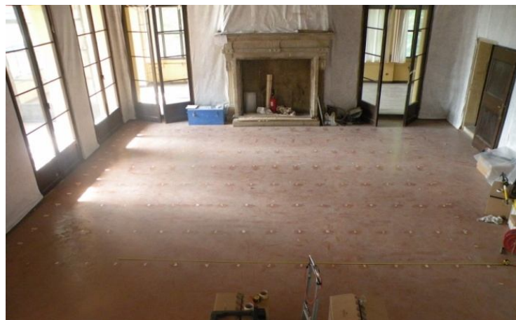
Figura 5.7: Traccia della griglia radar nel pavimento del salone 1F9.
