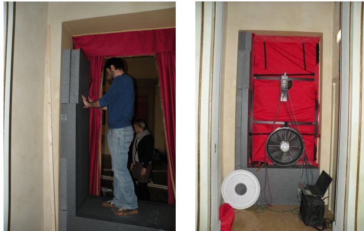
Figura 7.33: Posizionamento dei blocchi di EPS e della ventola nella Sala dei Primitivi.
