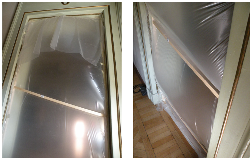
Figura 7.35: Particolari della sigillatura effettuata nella parete nord della Sala del '500.
