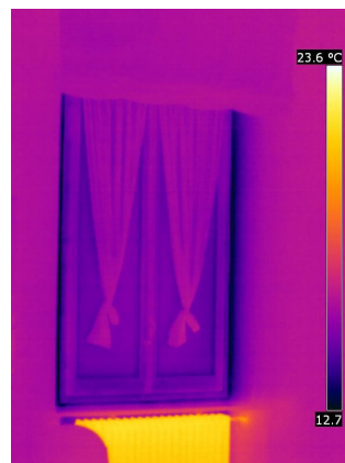
Figura 7.39: Termogramma dell'infisso tipo sul lato est della Sala dei Primitivi.
