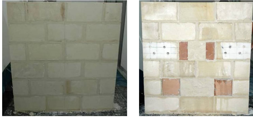
Figura 6.1: Prospetto dei muretti W1 e W2 pre-intonaco.
