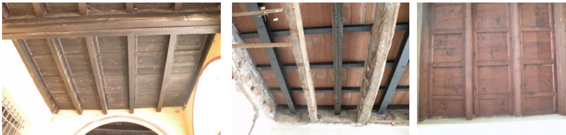
Figura 5.13: Tipologia di solaio presente, rispettivamente, nella loggia GF1, nella stanza GF6 e nel corridoio GF3.
