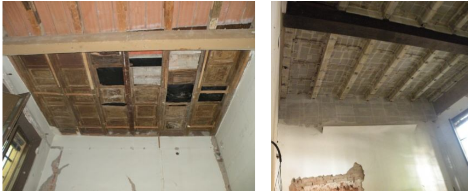
Figura 5.31: Tipologia di solaio presente sul soffitto, rispettivamente, della GF14+GF15 e della GF13.
