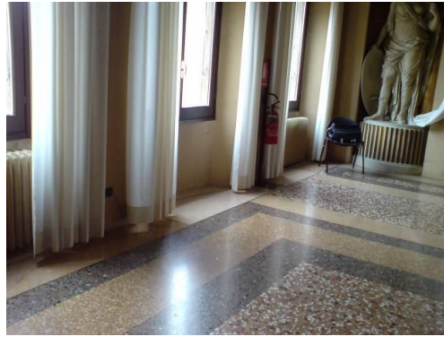
Figura 7.103: Condotto degli impianti a pavimento nella Sala Vidoniana.
