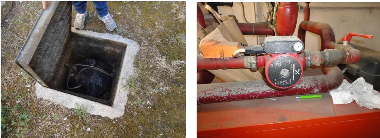
**Figura 15.** Serbatoio interrato per gasolio (a sinistra) e pompa anticondensa con inverter (a destra).
