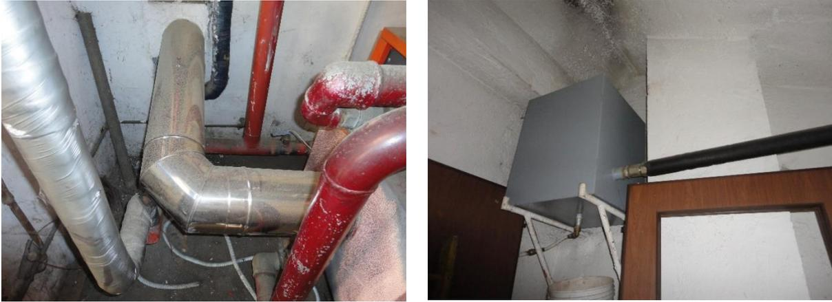
**Figura 14.** Canale da fumo (a sinistra) e vaso di espansione aperto in sottotetto (a destra).
