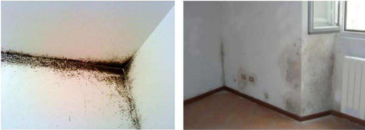
**Figura 2.** Formazione di muffa e condensa superficiale in prossimità di un ponte termico.
