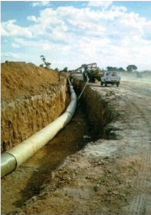
Fig.11 Tubi in PRFV posti in opera.
