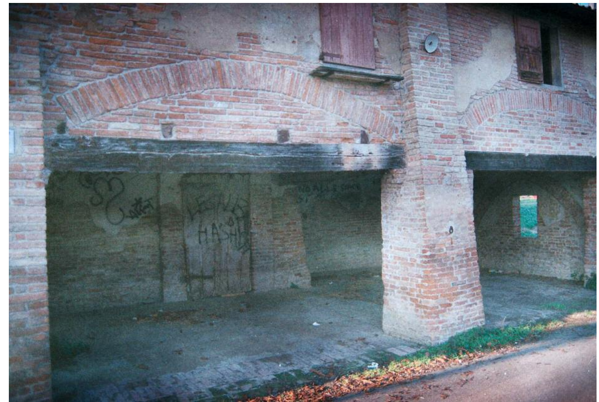
Aperture con architravi in legno e sistema statico pesante con archi a tutto sesto ribassati e tamponati del portico di accesso a sud-est.
