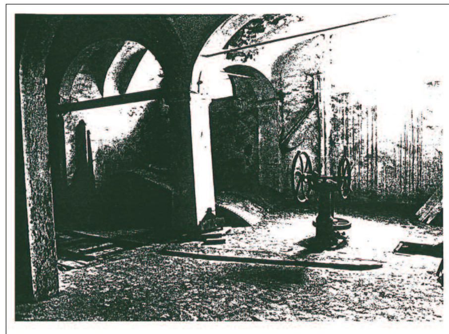
Molino Figna anno 1978 - Manovra paratoie e turbina
