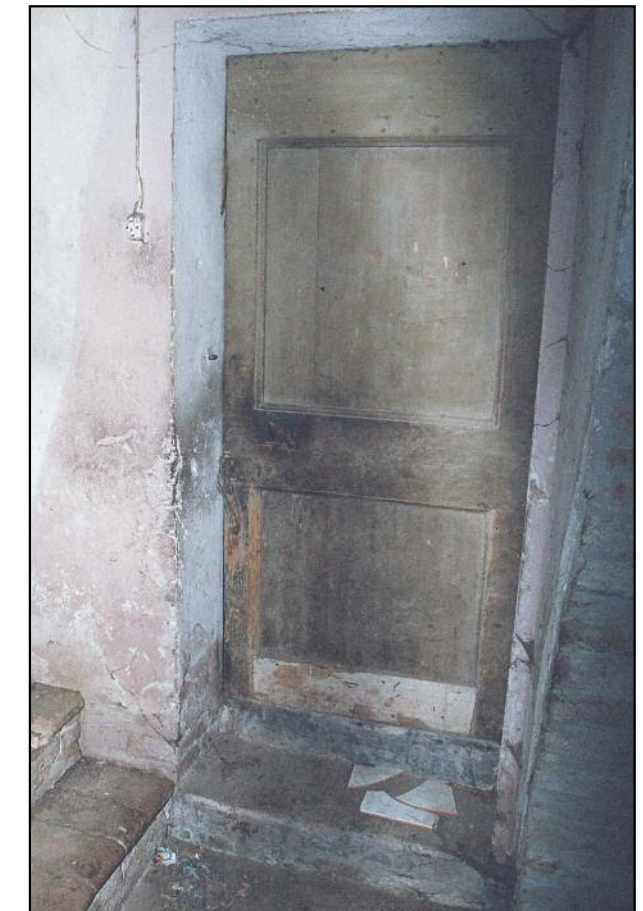
Porta interna posta al piano terra.
