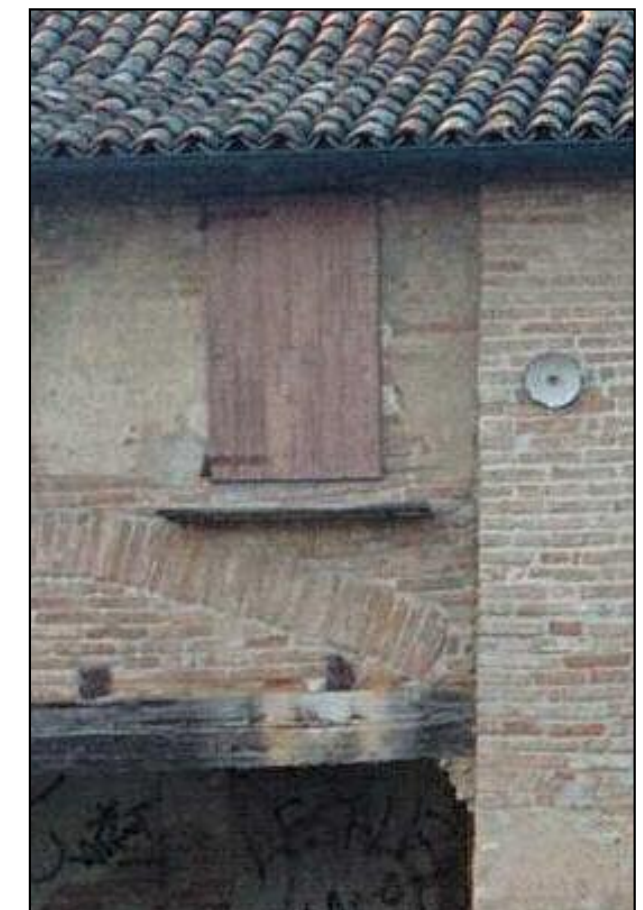
Scuroni esterni delle finestre del primo piano a sud-est.
