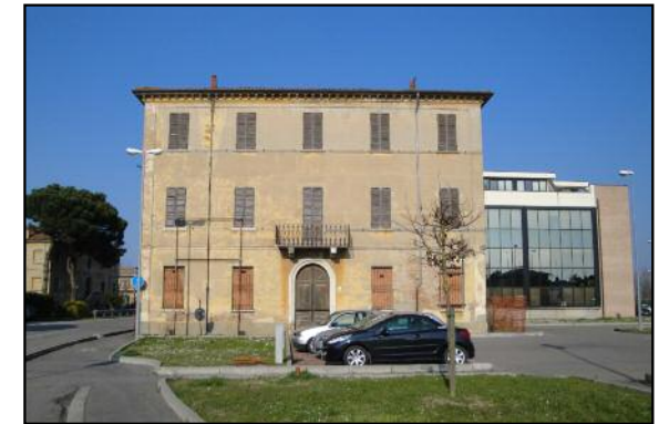
6 - Mulino di Brozzi-Lugo ( lato sud-ovest )
