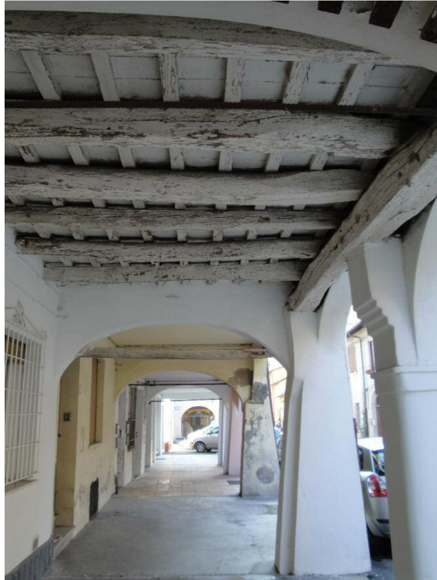
Particolare dei solai del primo piano degli edifici del centro storico
