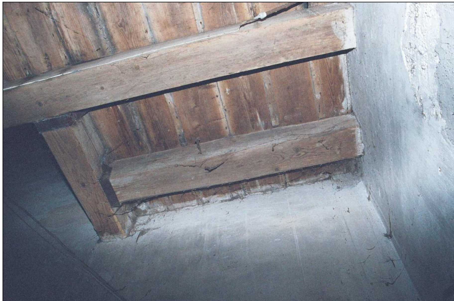
Solaio primo piano nella parte di edificio di inizio XIX secolo
