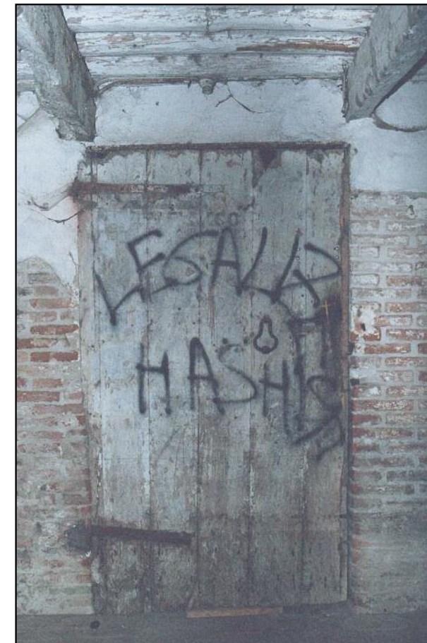
Porta di accesso principale posta sotto il porticato.
