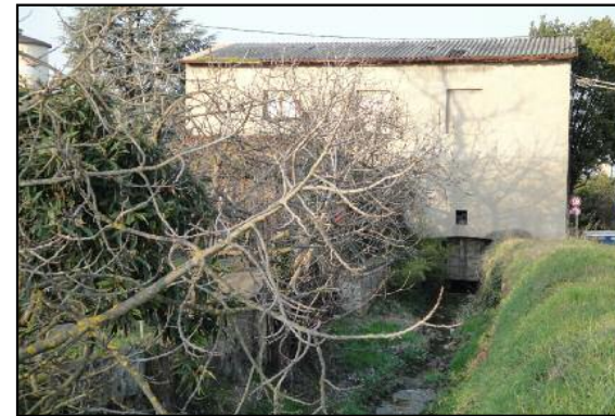
2 - Mulino di Mezzo ( lato -ovest )
