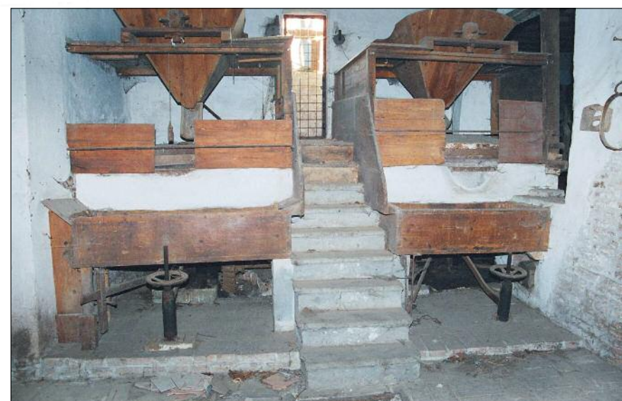
Scala in mattoni di servizio alla zona molitura in diretto collegamento con botola di accesso alla camera della turbina a sostituzione dell'antica ruota.
