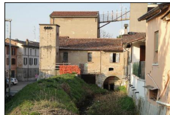
4 - Mulino di Solarolo ( lato sud-ovest )
