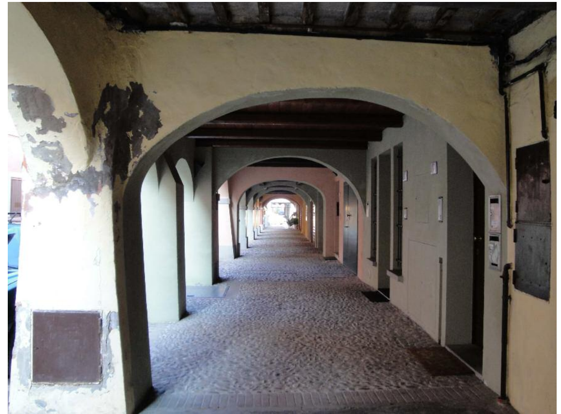
Particolare del loggiato e solai in legno e laterizio del primo piano.
