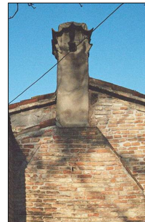
Comignolo posto su edificio del XVI secolo.
