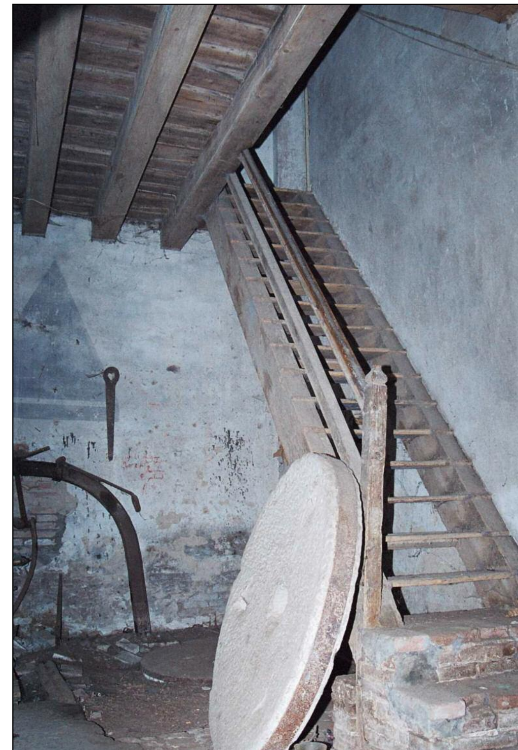
Scala interna di collegamento fra piano terra e camere da letto del primo piano o sottotetto. È costituita da una semplice pedata incastrata tra due montanti (casciali) e corrimano; un sistema misto costituito dai primi tra gradini di mattoni in cotto su cui poggia la scala in legno .
