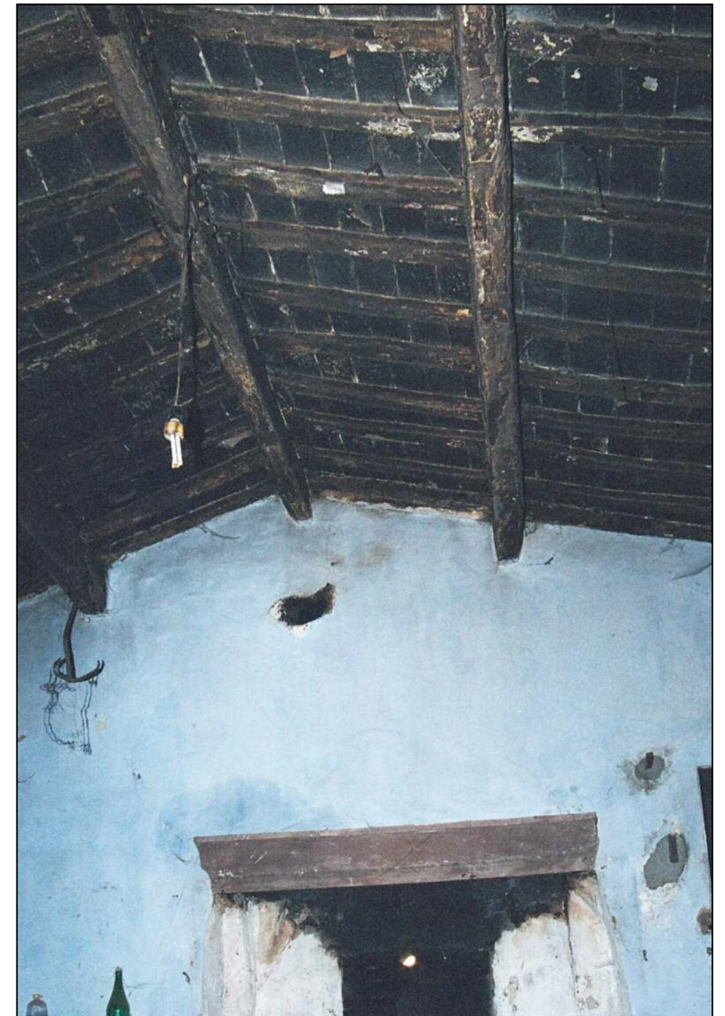
Struttura di copertura nella parte di fabbricato presumibilmente del XVI secolo. La struttura secondaria è formata da travetti ( morali ) su una principale di travi poggianti su una muratura che segue la pendenza del tetto.
