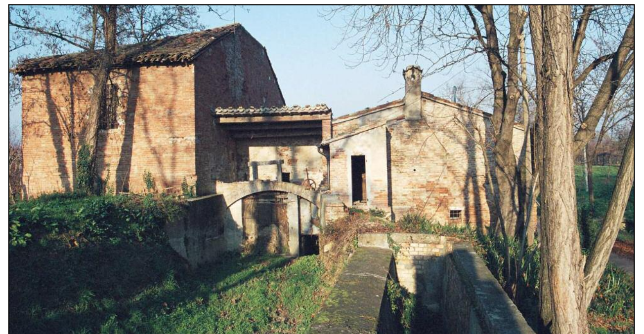
Lato sud-ovest. In primo piano a destra il muro in mattoni del canale sboritore. Sullo sfondo paratia regolabile del canale di ingresso.
