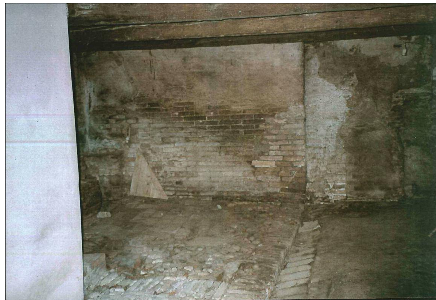
Pavimentazione stalla, situata al piano terra dell'edificio del XVI secolo
