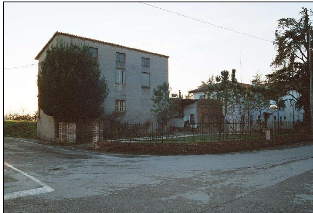
Molino di Mezzo - Lato Nord-Est (Attuale)
