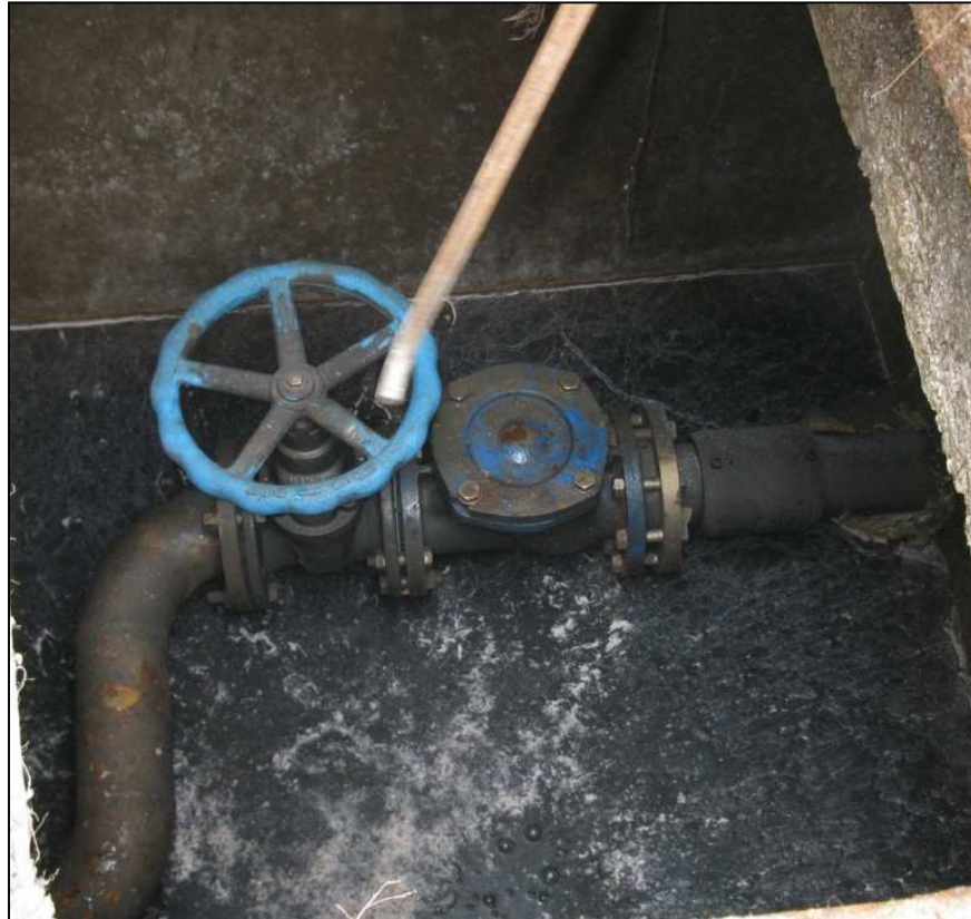
Figura 40 Particolare vano alloggio pompe
