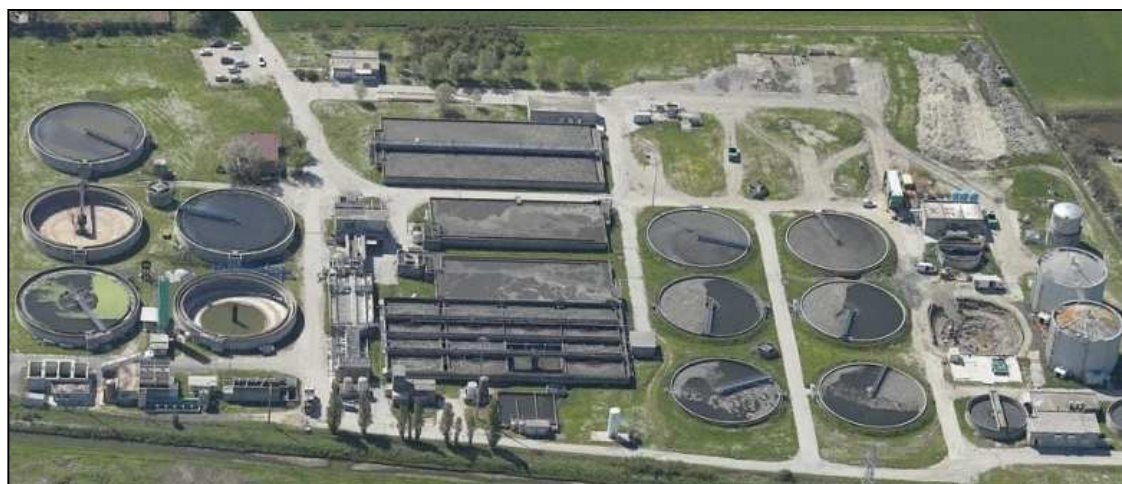
Figura 18 Vista area dell'Impianto di Depurazione Ravenna città
