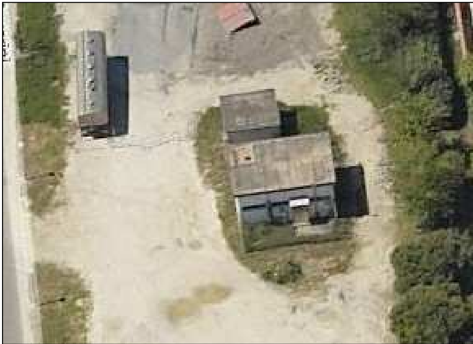
Figura 27 Vista area dell'edificio contenente l'impianto di sollevamento Rotta e i dispositivi per il controllo
