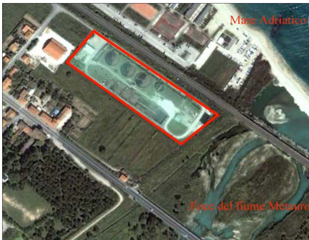
Figura 6 Impianto di depurazione di Ponte Metauro - comune di Fano
