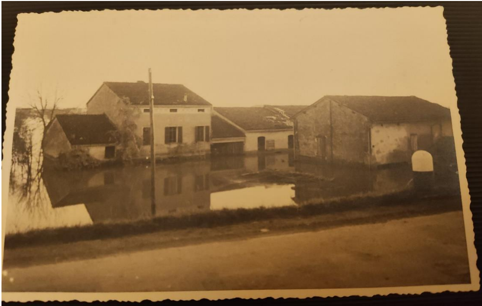
Figura 1. Alluvione del Po (1951)
