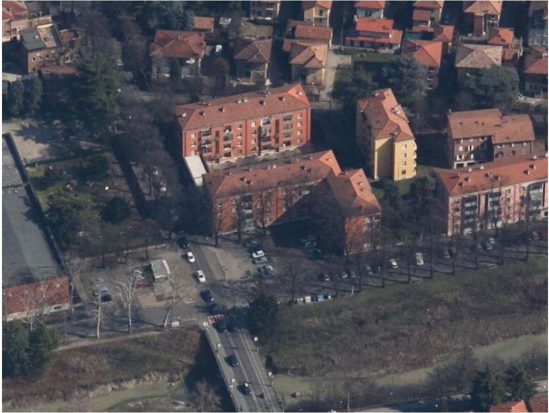
Figura 20 – Vista aerea del fabbricato oggetto di studio e area circostante
