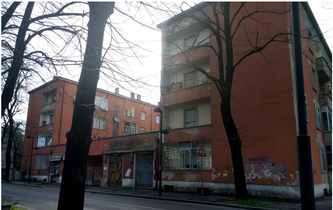
Figura 21 – Prospetto nord, lato strada su via Magenta del civico 18
