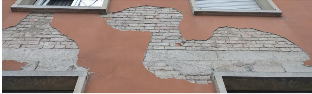
Figura 29 – Tamponamenti in laterizio pieno e solaio interpiano
