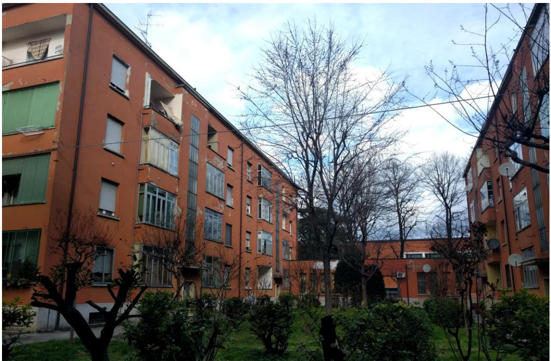
Figura 23 – Prospetto sud, lato interno alla corte del civico 18
