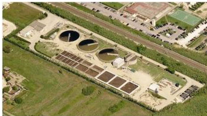
Figura 4. L'impianto di depurazione Ponte Metauro
