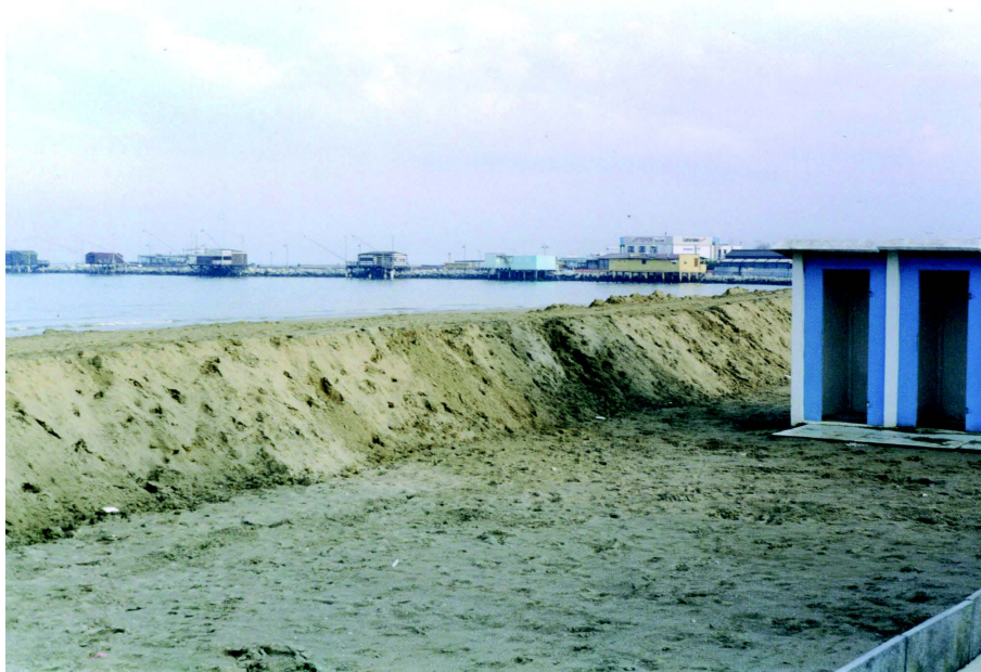
Figura 1.17 Esempio di argine invernale a protezione degli stabilimenti balneari. Fonte: Stato del litorale emiliano-romagnolo all'anno 2007 e piano decennale di gestione. Arpa, 2008.
