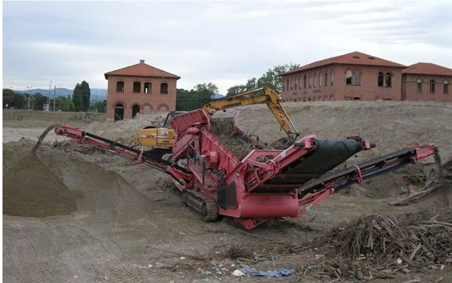
Figura 1.16 Vagliatore all'opera su una spiaggia. Questo strumento è in grado di separare la frazione da smaltire dalla sabbia idonea al riutilizzo. Fonte: https://www.ecodemolizionisrl.com/pulizia-spiagge-e-ripascimenti
