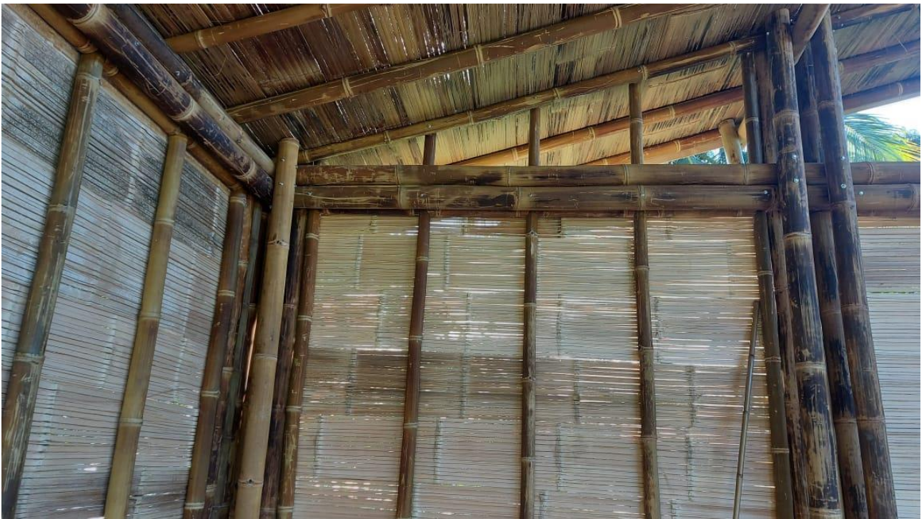
Figura 19 Vista dei tamponamenti dall'interno dell'edificio.
