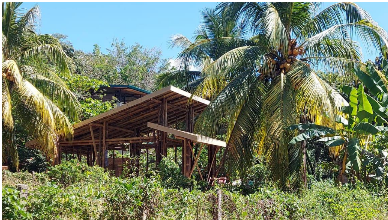
Figura 13 Vista dell'edificio originale in realizzazione in Costa Rica.
