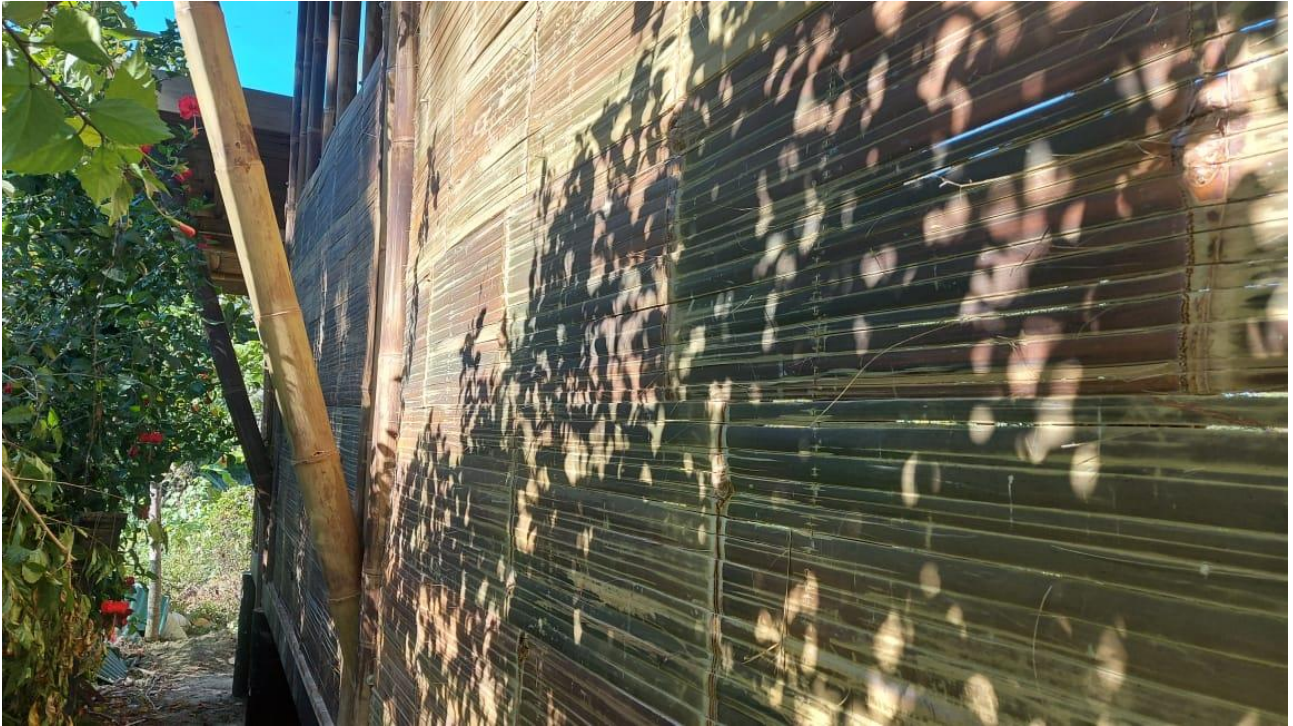
Figura 18 Vista dei tamponamenti dall'esterno dell'edificio.
