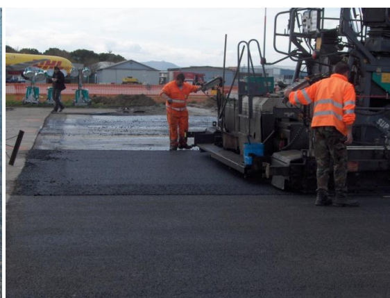
Figura 101: Stesa del conglomerato bituminoso.
