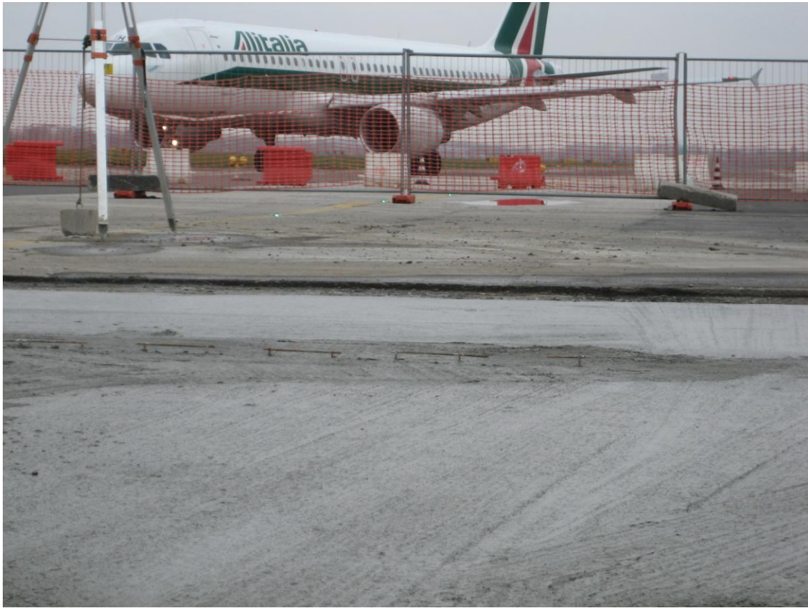
Figura 84: Cantiere nella via di rullaggio.
