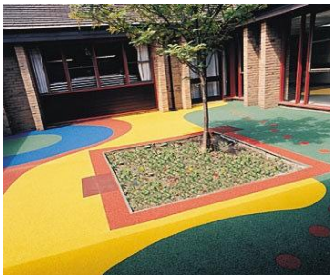
Figura 14: Esterno di un asilo rivestito con materiale in gomma riciclata.
