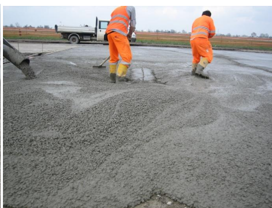
Figura 97: Stesa del calcestruzzo ordinario.
