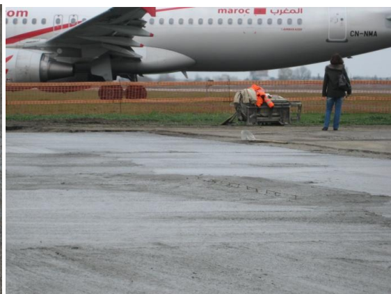
Figura 99: Calcestruzzo additivato con PFU.
