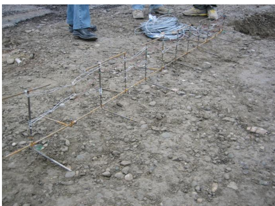
Figura 90: Posizionamento del traliccio.
