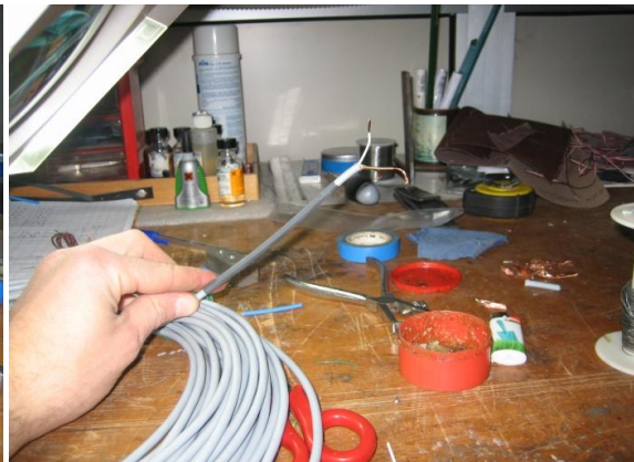
Figura 69: Rivestimento del cavo con guaina.
