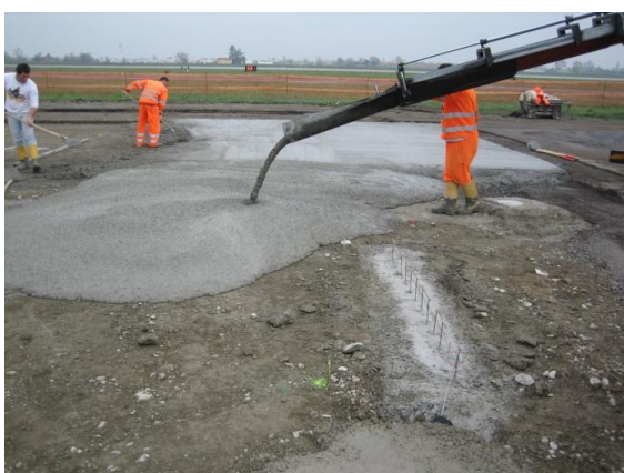
Figura 92: Getto del calcestruzzo con PFU.
