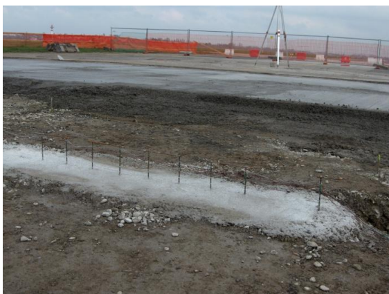
Figura 96: Prima lastra di calcestruzzo con PFU.
