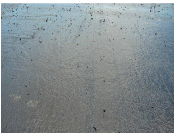
Figura 100: Catramina stesa sul calcestruzzo.
