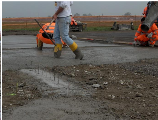
Figura 95: Stesa del calcestruzzo con il rigone.
