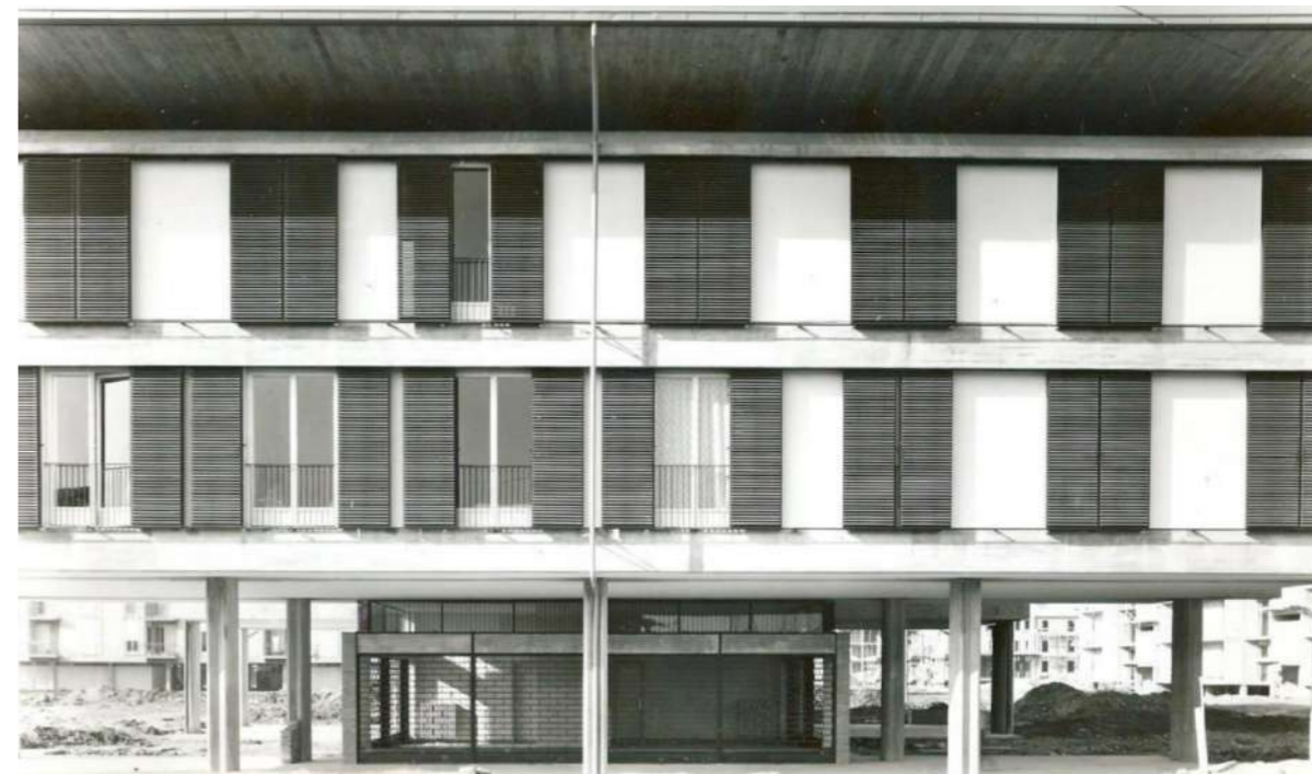
Dettagli costruttivi delle persiane del primo e secondo piano, Laboratorio di laurea sostenibile , Università di Bologna, 2020.
