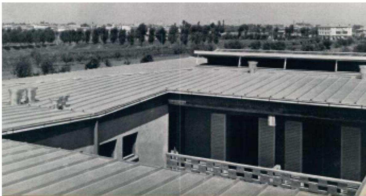
Veduta della copertura degli edifici ad H, Barca, Bologna, 1957, Casabella continuità n°263 , Mazzocchi G., 1962.
