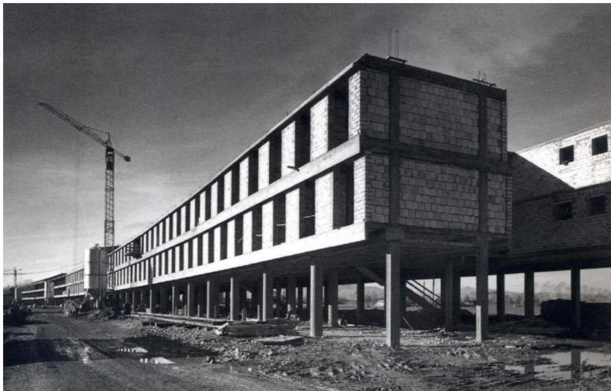
Vista del “Treno” durante la costruzione, quartiere Barca, Bologna “Giuseppe Vaccaro” a cura di M. Mulazzani, 2002.
