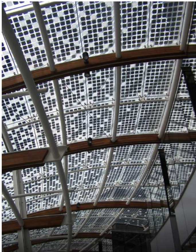
Foto della copertura in piazza Gae Aulenti, Milano.
