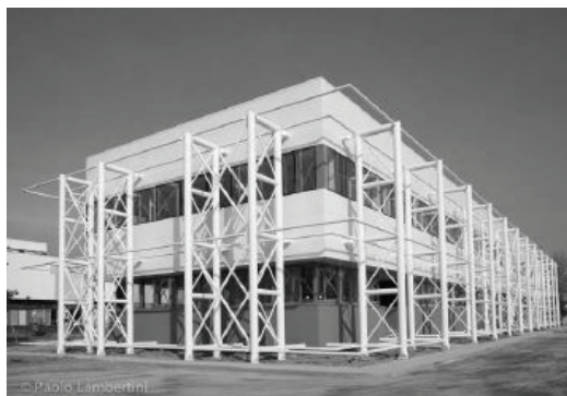
Figura n.33: Adeguamento sismico della palazzina uffici nello stabilimento Magneti Marelli, Crevalcore.
