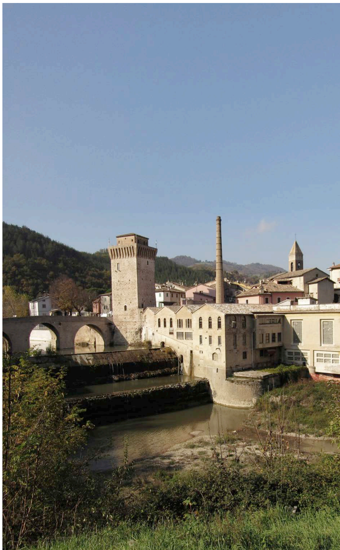
Fig. 17, Area di intervento.
