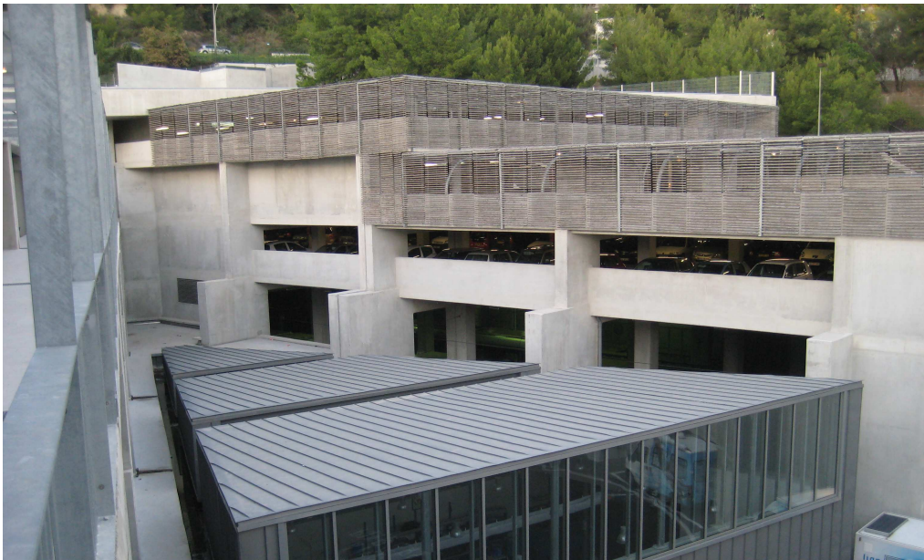
Marc Barani, Centro multimodale di Nizza, 2007
